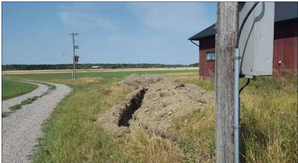
Figur 10. Schakt grävt invid befintlig markkabel. Foto från sydost.
