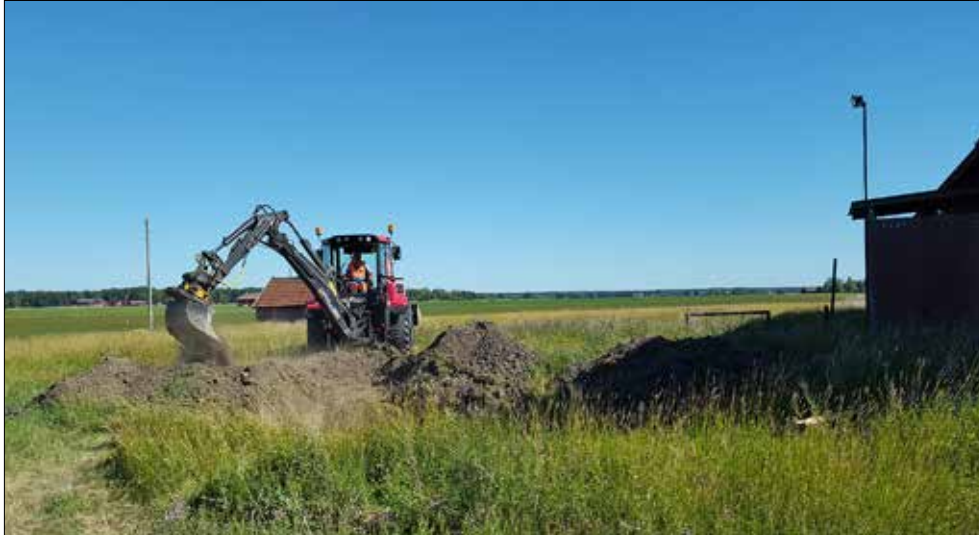
Figur 5. Arbetsbild över schakt grävt för ny transformatorstation. Foto från söder.
