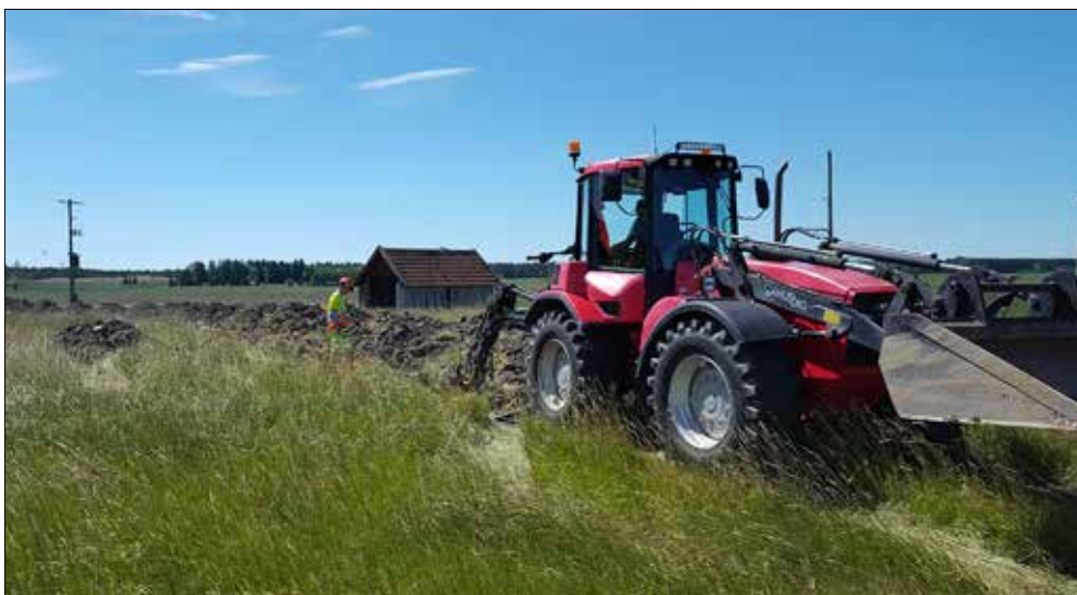
Figur 7. Översikt av schakt väster om ladugård. Foto från nordnordost.
