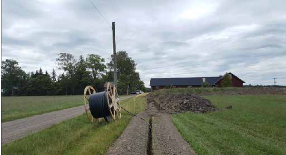
Figur 8. Schakt grävt för ny markkabel norr om ladugård. Entreprenörens schakt i förgrunden. Foto från norr.
