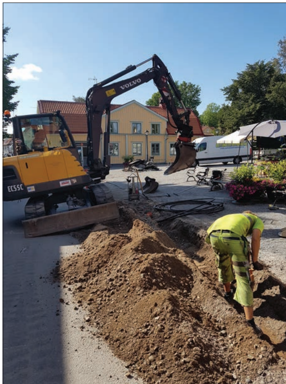
Figur 6. Schaktning för PE32-slang i sydöstra hörnet av Stora Torget. Foto från öster av Oskar Spjuth.
