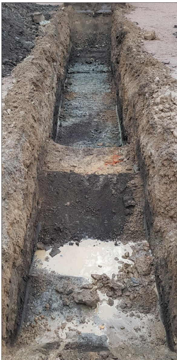
Figur 4. Schakt 225. Foto från sydväst.
