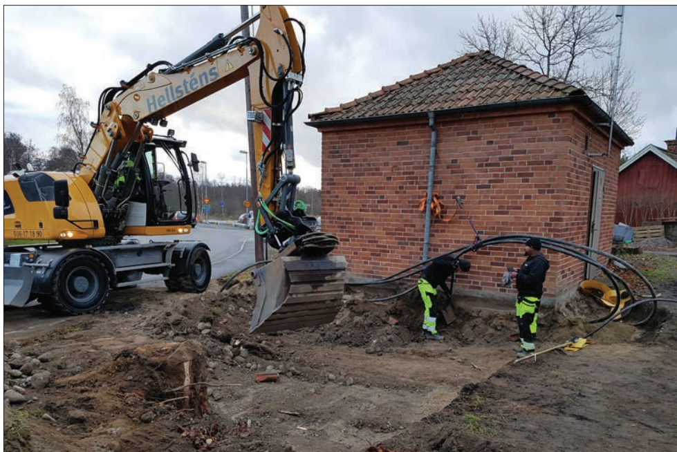
Figur 4. Delar av schaktet togs upp intill en befintlig nätstation. Foto från öster.
