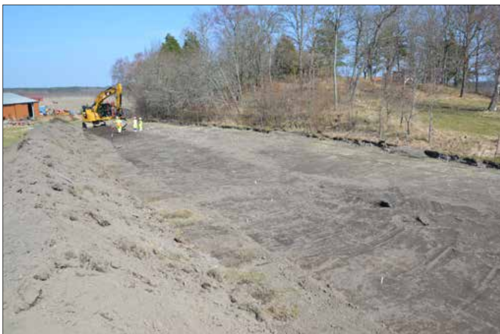
Figur 15. Det norra schaktet från väster, i bakgrunden syns den höjd där bytomten Hallsta är belägen. Foto Andreas Forsgren.
