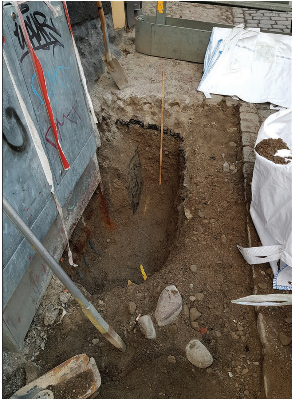
Figur 6. Schakt 1 sett från öster.
