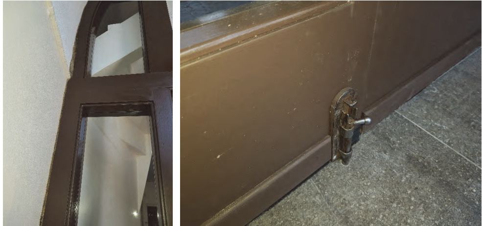
Figur 12. Karmen är monterad mot muren med skruv i expanderplugg. Glipan är tätad med lindrev. Figur 13. Ett litet hål är borrarat i stengolvet för regeln som låser ena dörrbladet.
