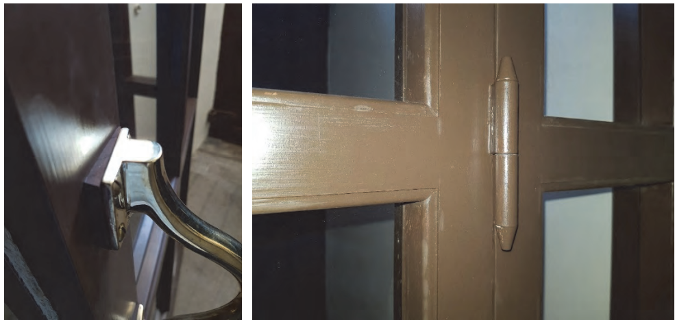
Figur 14. Draghandtaget är monterat på kilar för att få en mer greppvänlig vinkel. Figur 15. Gångjärn med konformad tapp.
