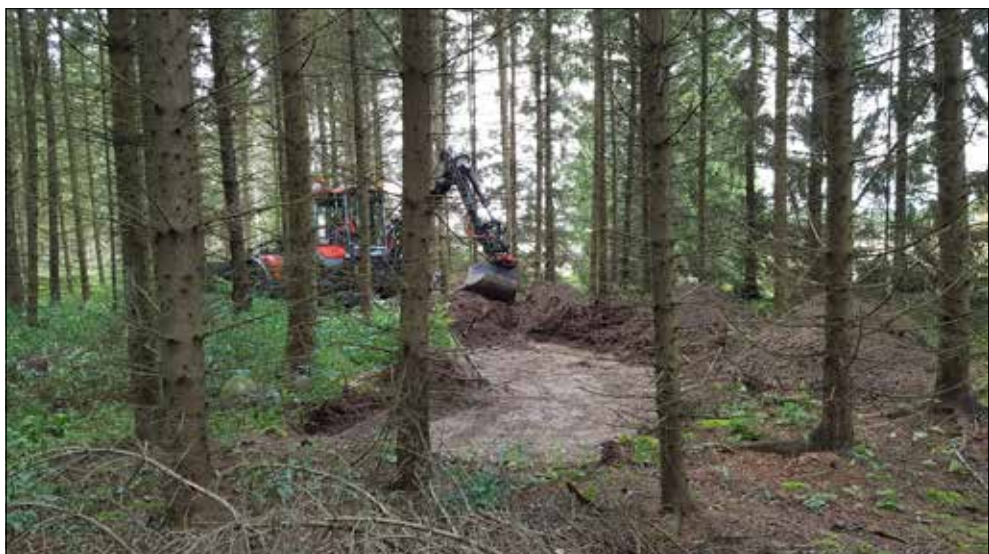
Figur 7. Schakt 18 inom det södra utredningsområdet. Foto från sydväst.
