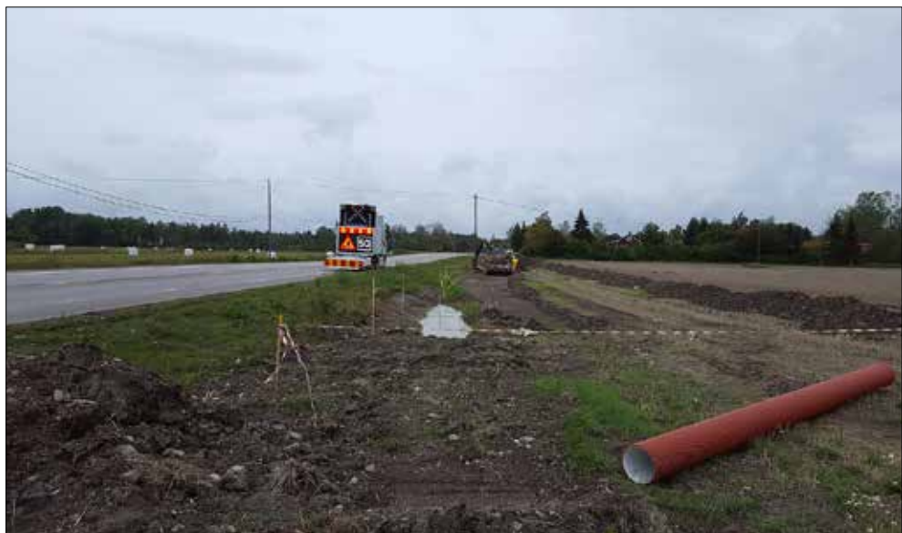
Figur 6. Foto över arbetsområdet för gc-vägen. Framför grävmaskinen syns hur stor del av matjordslagret som redan var bortschaktat före förundersökningen. Foto från nordost av Jan Äblström.
