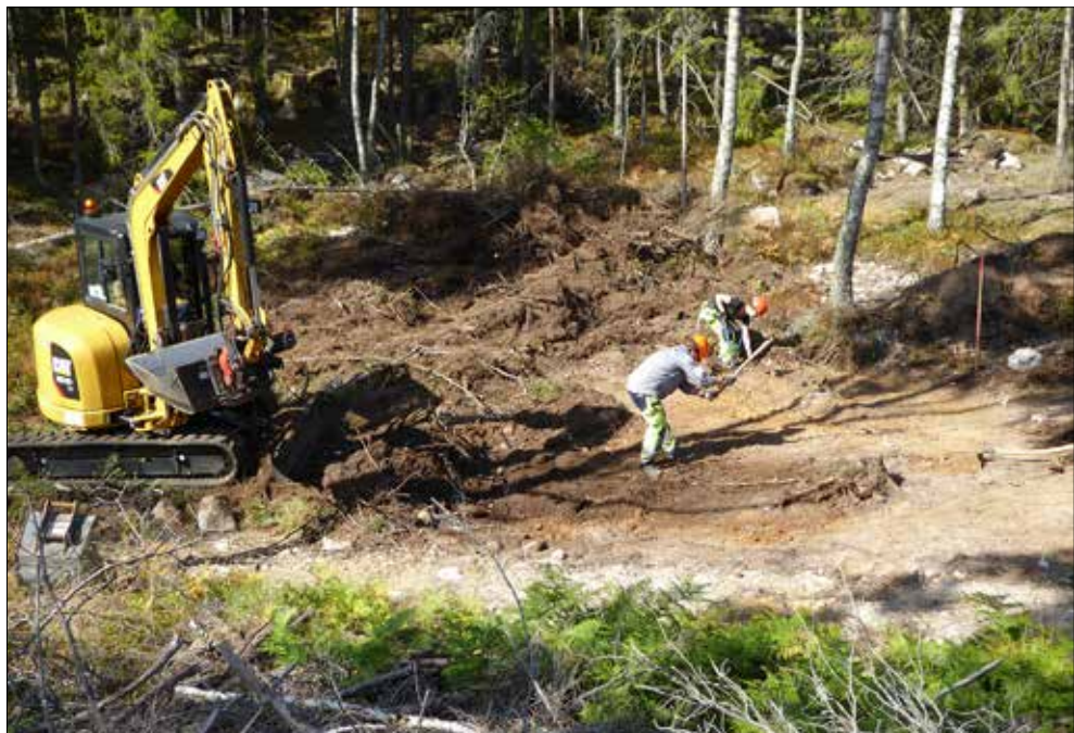
Figur 60. Den centrala delen av Helgona 434-4 schaktas fram. Foto från väster av Caroline Strandberg.
