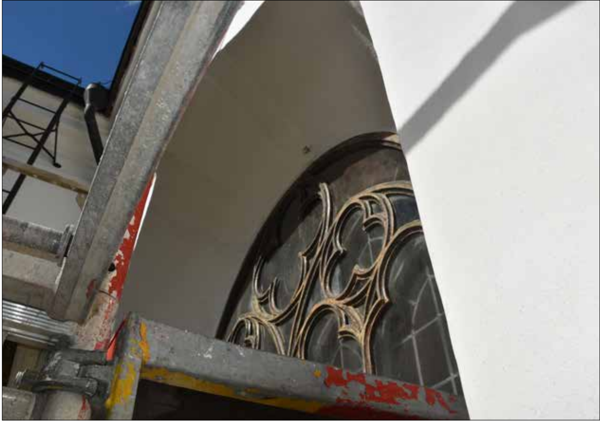
Figur 4. Ett av fönstren, sett från ställning. Arbete med skrapning pågår.
