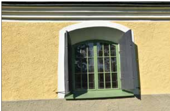
Figur 51. Sakristians fönster och fönsterluckor, västra sidan.
