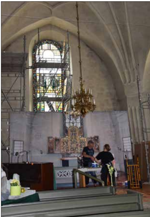
Figur 34. Pågående arbete med glasmålningar i koret.
