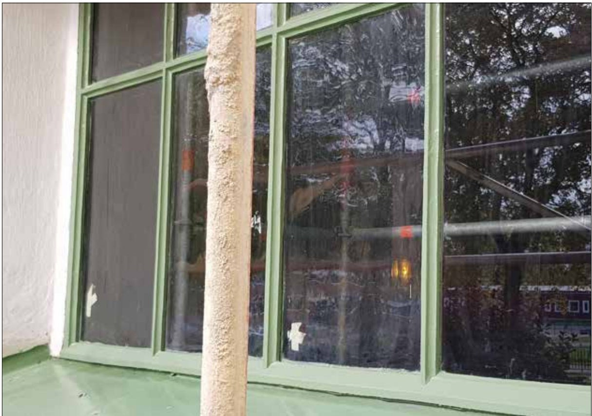
Figur 13. Inspektion av nymålade gjutjärnsbågar. Ett av fönstren sett från byggnadsställning den 26 september 2018.
