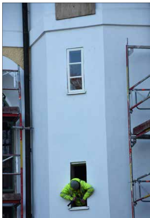
Figur 23. Montering av nymålade fönster i trapphuset. Fönstren är målade med kittrvit linoljefärg.
