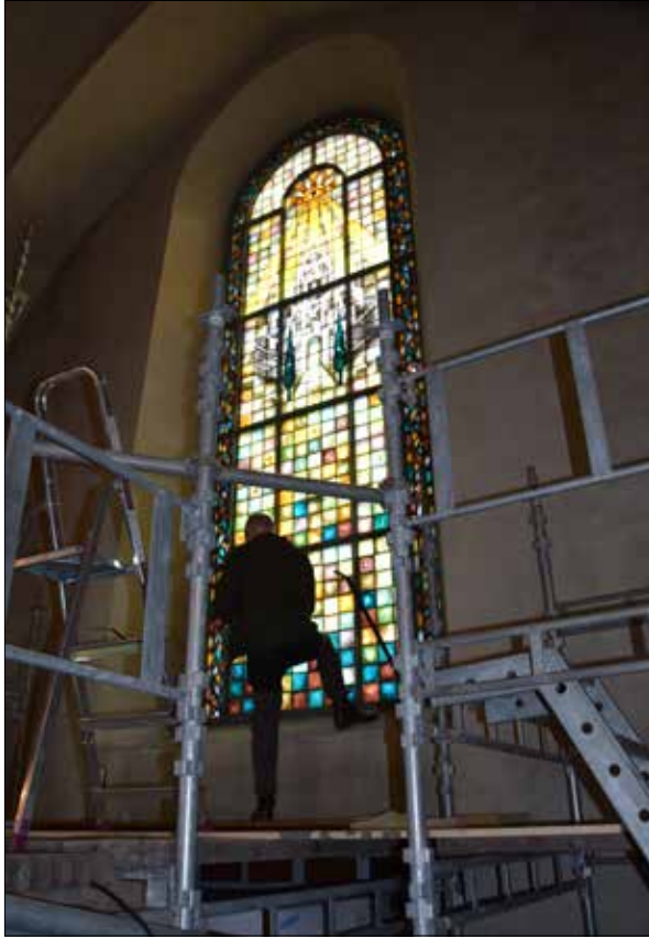
Figur 33. Korets östra fönster före renovering.
