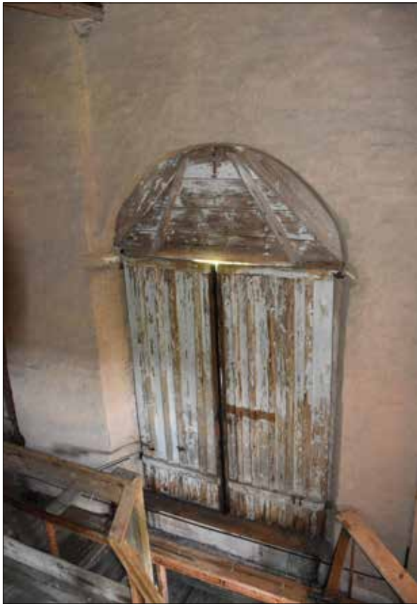
Figur 5. En av ljudluckorna i lanterninen. Insidan behöver inte åtgärdas.
