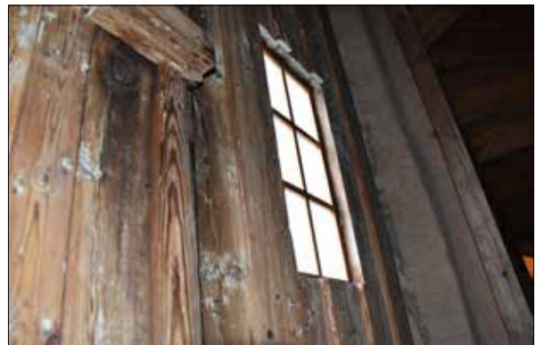
Figur 45. Det nya fönstret sitter på plats vid slutbesiktning i oktober 2019.
