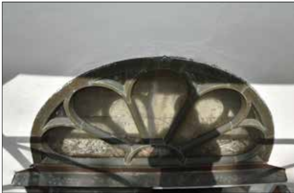
Figur 8. Överljus, södra entrén. Spröjsen är klädda med koppar och munbläst glas. Bågstycket var ruttet och behövde bytas.
