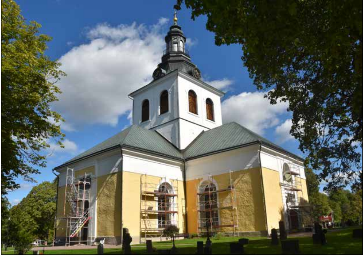
Figur 2. Besök i augusti 2018. Ställningar är på plats och arbetet med rengöring och skrapning har påbörjats.
