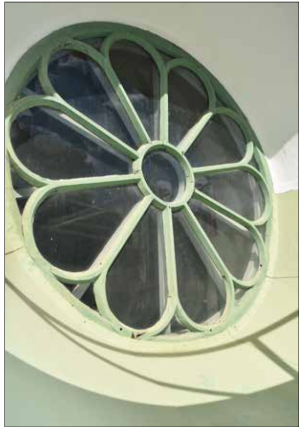
Figur 6. Runt fönster före renovering, södra entrén.
