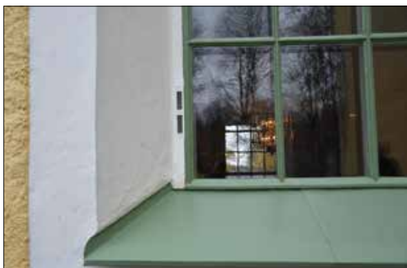
Figur 53. Detalj av ventilationsgaller, fönster och fönsterbleck, slutbesiktning i oktober 2019.
