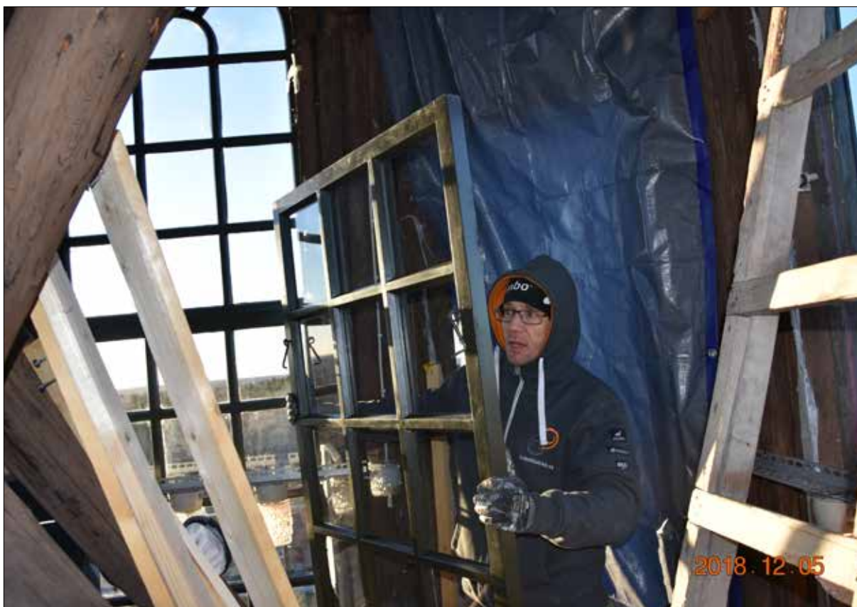
Figur 21. Dags att montera nyrenoverade fönster i lanterninen.
