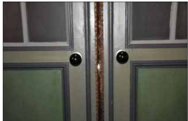
Figur 46. Detalj av norra vingfångets dörr. Lådet kommer att smörjas in och inte bytas.
