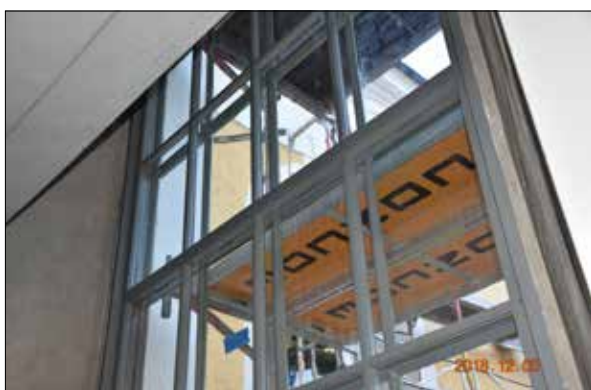
Figur 19. Nymålade träbågar. Fönster sett inne från kyrkan.
