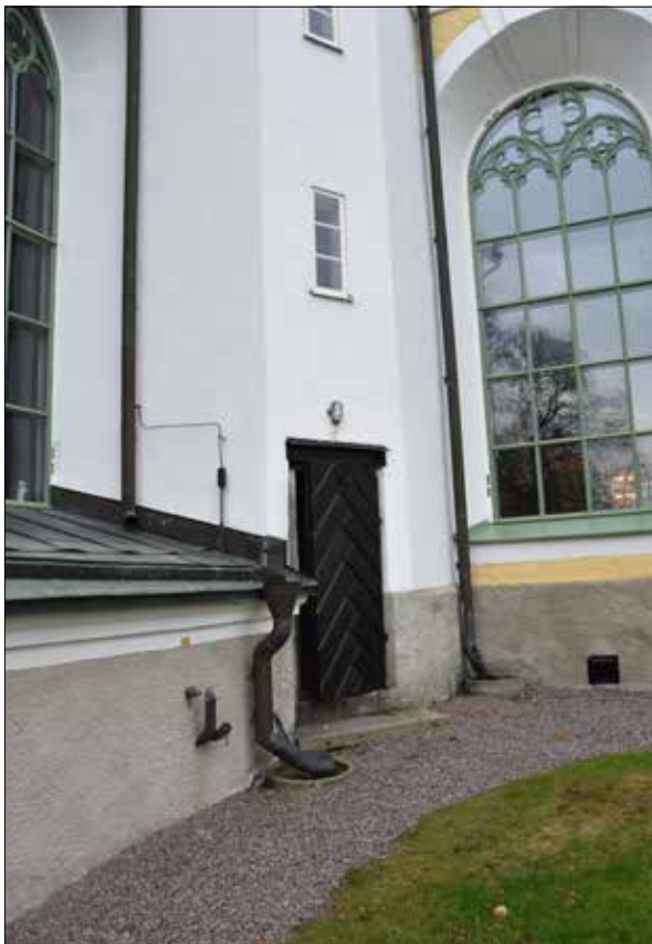
Figur 42. Nymålade fönster, dörr in till vindstrappan samt nymålade lucka i grund, oktober 2018.
