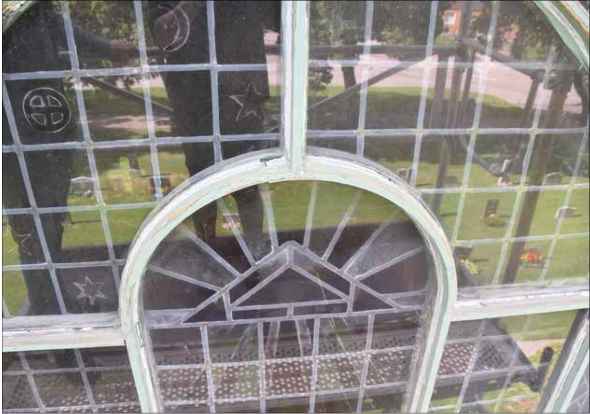
Figur 7. Korffönstret sett från utsidan, före renovering i augusti 2018.
