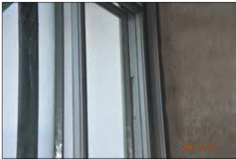
Figur 27. Pågående arbete ventilation, insida fönster.
