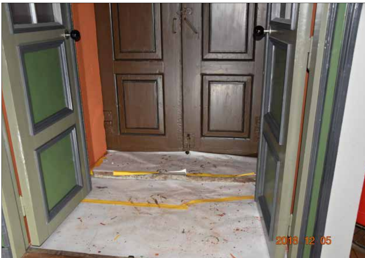
Figur 16. December 2018. Bättringsmålning av dörrpartier i norra vindfånget har färdigställts. Väggarna i vindfånget har också fått en uppfräschning med brunorange emulsionsfärg i kulör NCS S 3050-Y60R.
