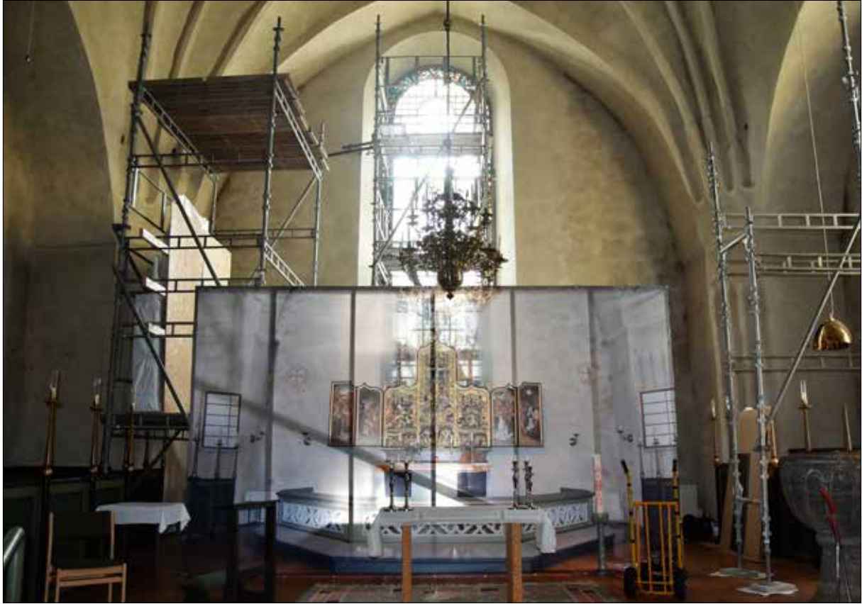
Figur 39. Under tiden som östra korfönstret restaurerades och altarskåpet tillfälligt hade flyttats löste man situationen med en skärm föreställande altarpupsatsen.
