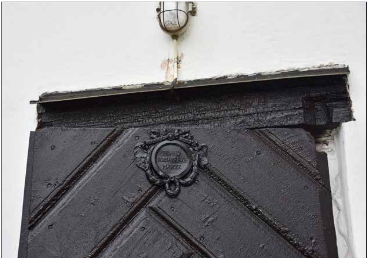
Figur 48. Detalj av rengjord och målad brandförsäkringsskylt som åter monterats på dörren till trapptornet.
