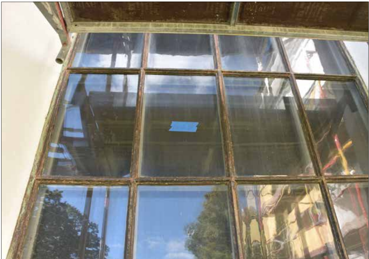
Figur 3. Detalj av rengjorda och skrapade gjutjärnsfönster.
