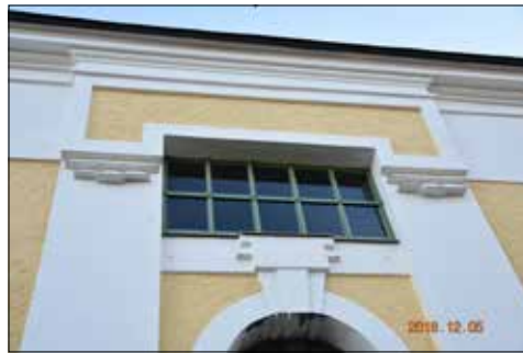
Figur 26. Detalj av nyrenoverade överljus, västra entrén.
