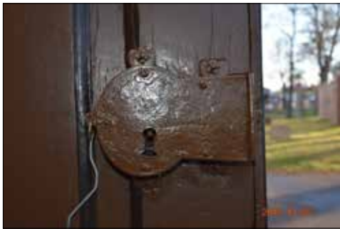
Figur 25. Detalj av nyrenoverat lås.
