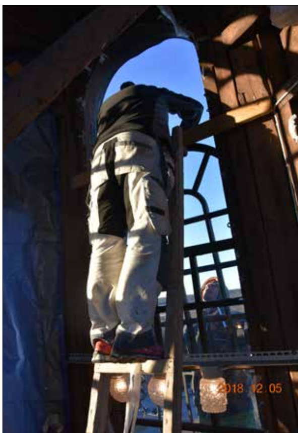
Figur 22. Fönstren i lanterninen är målade med linoljefärg i mörkbrun kulör NCS S 8505-G80Y.
