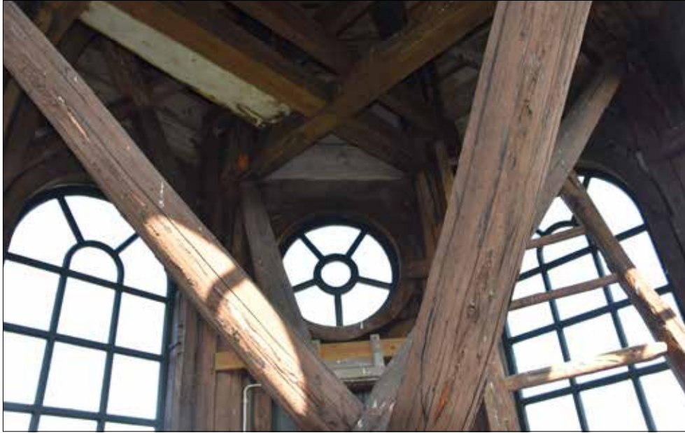
Figur 24. Nyrenoverade fönster åter på plats i tornets lanternin.
