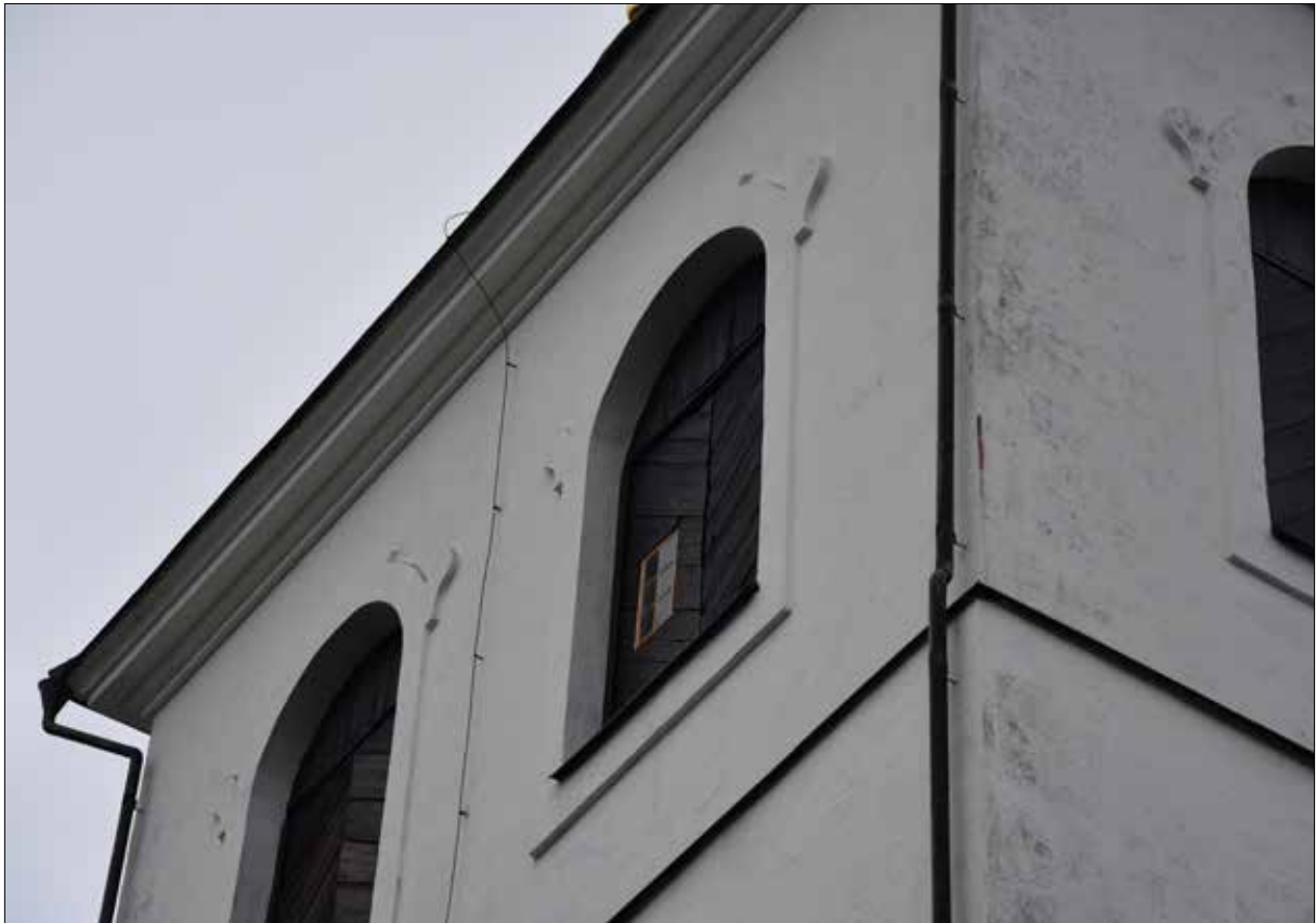
Figur 47. Nyttillverkat fönster på plats, oktober 2019.
