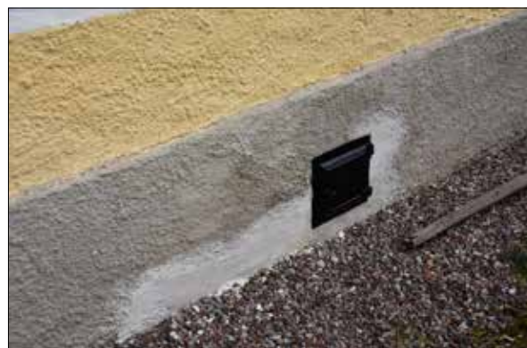
Figur 54. Nyrenoverad ventilationslucka. Sockeln måste på sikt åtgärdas, men det är ett kommande projekt.
