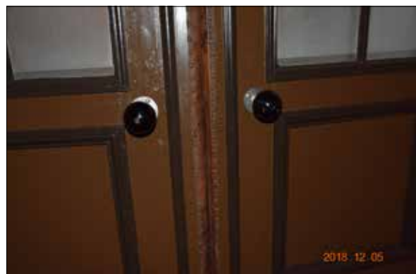
Figur 18. Samma dörrpar som i figur 17, detalj av insidan (vingfånget).
