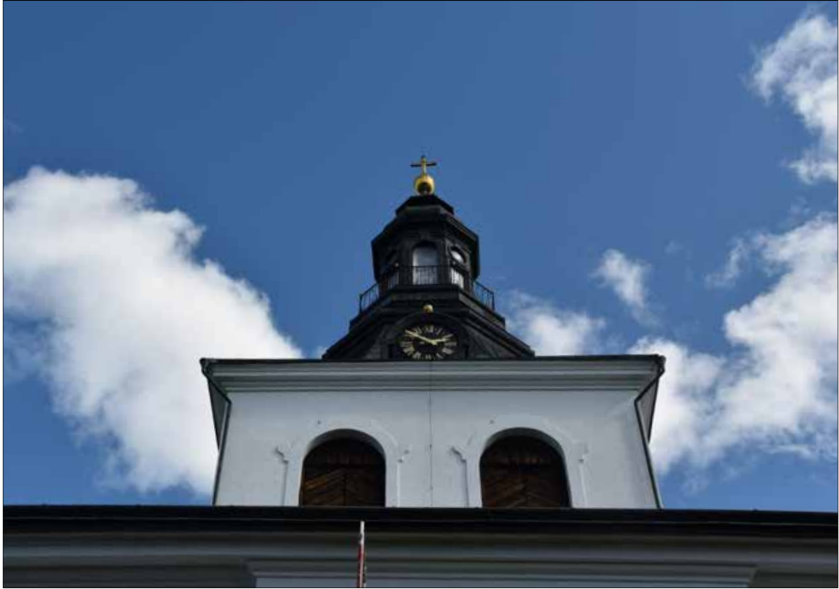
Figur 12. Torn med tjärade luckor före renovering i augusti 2018. Lanterninens fönster har tagits ner för renovering på verkstad.
