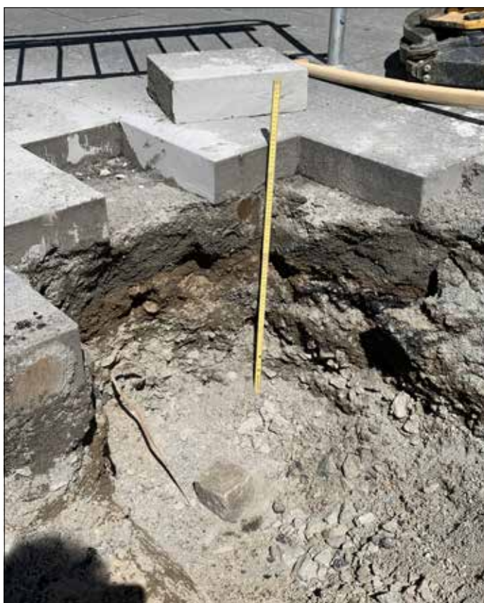
Figur 7. Schakt 2 vid Skvallertorget. Foto från sydväst av Mattias Johansson.
