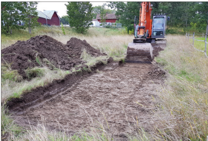
Figur 6. Schaktning inom delområde 2. Foto från norr.
