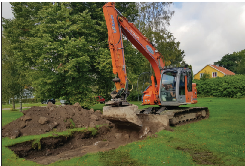
Figur 5. Schaktning inom delområde 1. Foto från sydöst.
