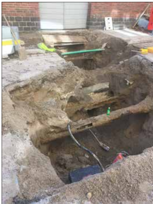
Figur 5. Schakt 2. Foto från norr.
