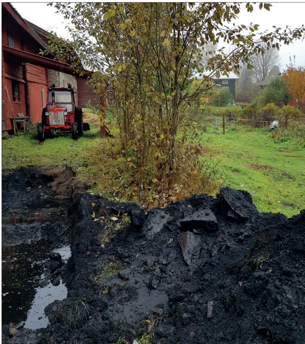
Figur 2. Schaktning pågår inom schakt 3. Foto från väster.
