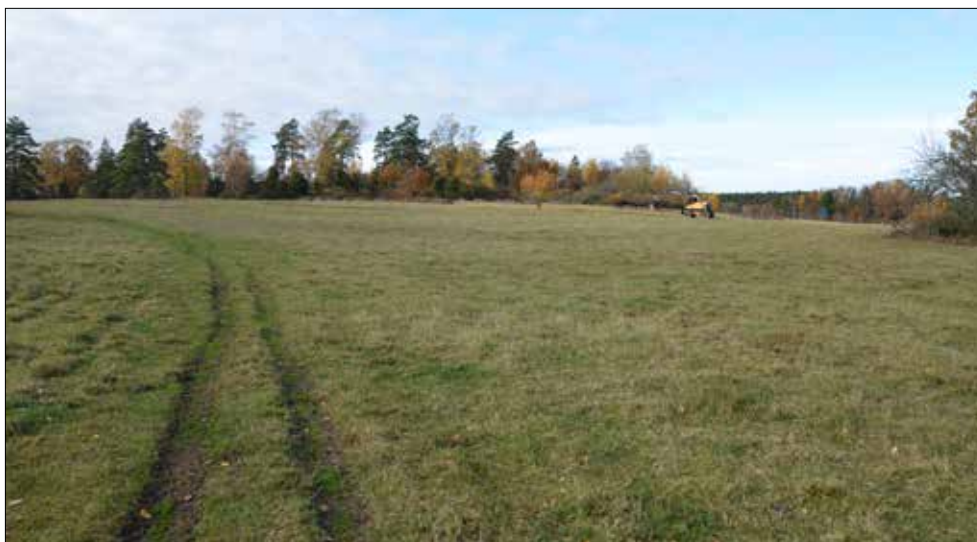
Figur 3. Igenläggning av schakt vid Sweco 008 (Eke gård). Foto från sydöst.
