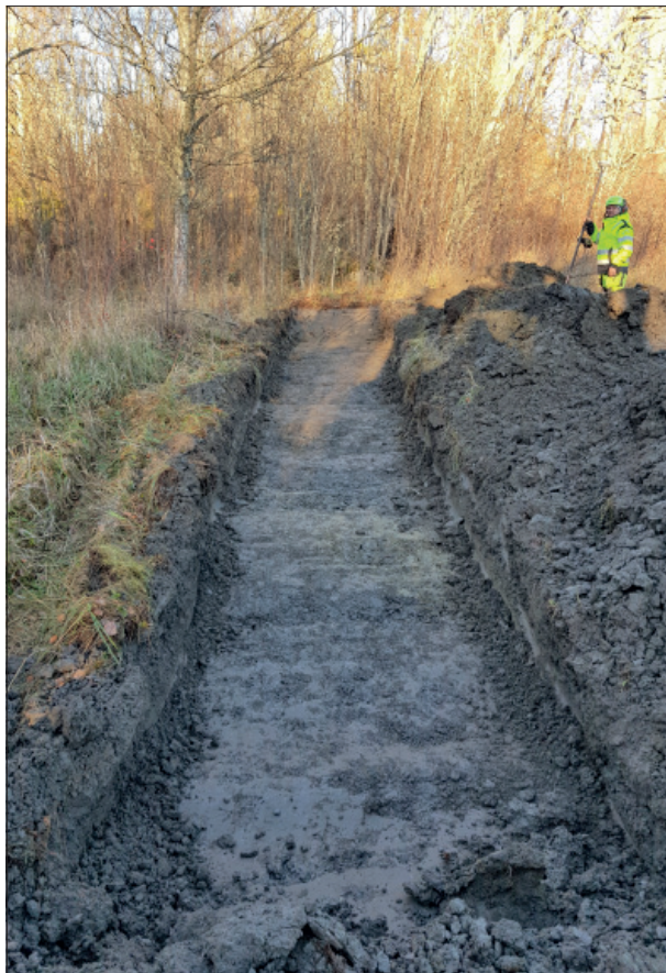
Figur 12. Schakt 10. Foto från väster.
