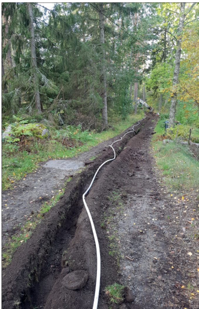
Figur 4. Ett parti av schaktets avsnitt A. Foto från öster.
