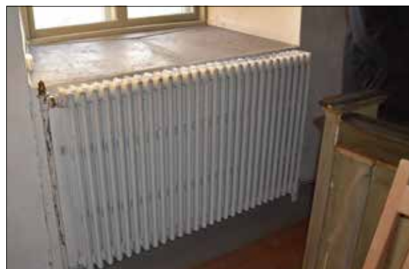
Figur 9. Detalj av radiator, som kom på plats vid renovering 1931. Före renovering nedsmutsad och med slagad färg.
