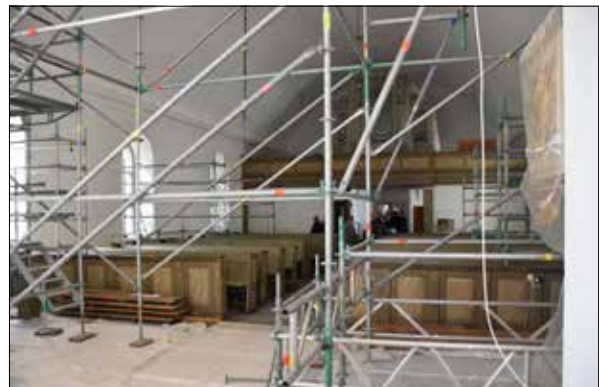
Figur 38. Den stora ställningen nedmonteras. Tak- och väggar helt klara. Fönsterrenovering pågår fortfarande i maj 2019.
