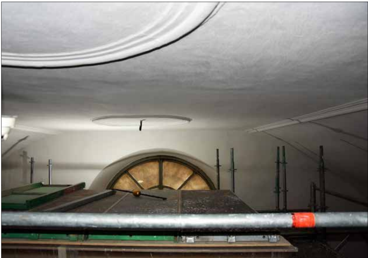
Figur 33. Ansynning av kyrkans tak före nedplockning av ställning, april 2019.
