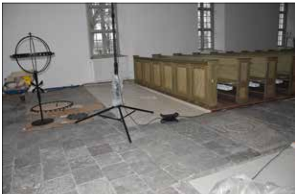
Figur 60. Plankgolvet längst fram i kyrkorummet har målats i grå kulör för att harmonisera med stengolvet.
