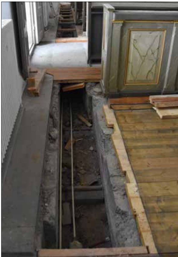
Figur 35. Pågående arbete med att byta ut ledningar under golvet, maj 2019.
