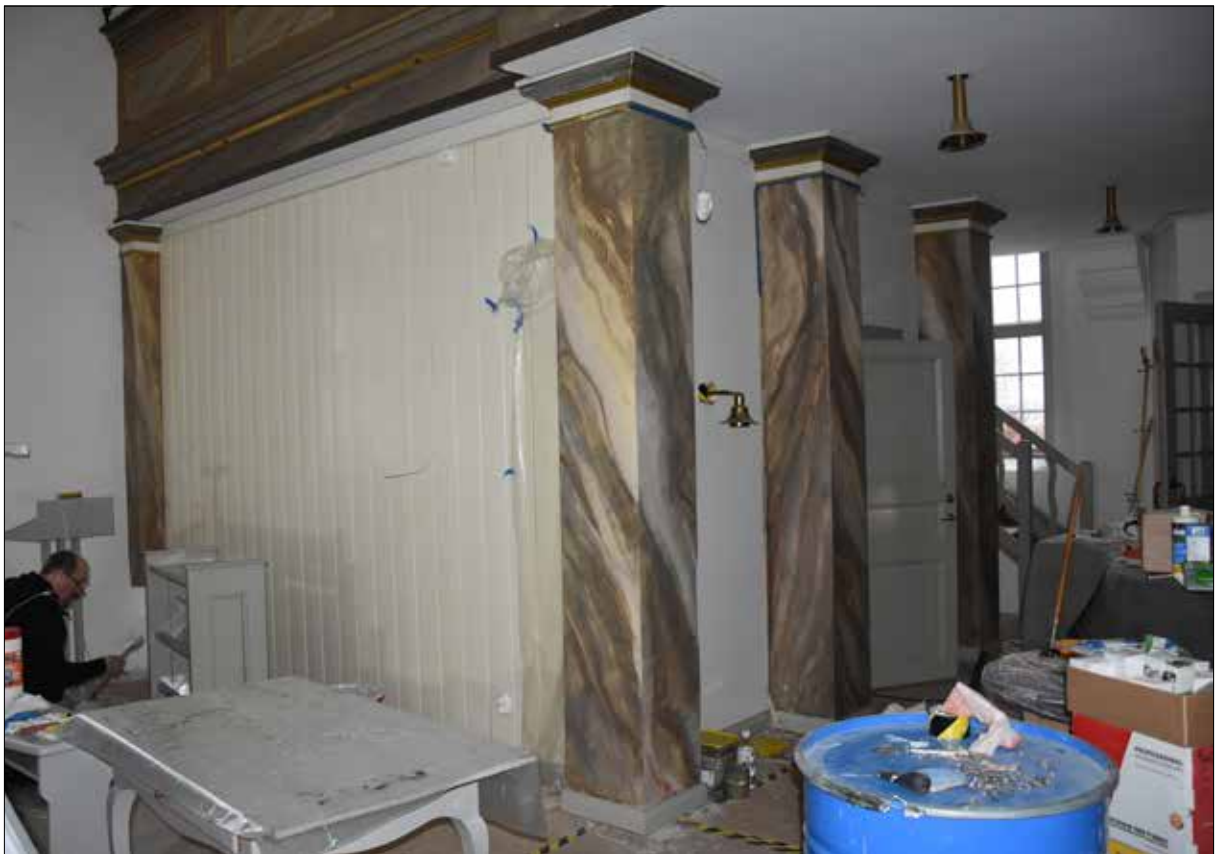
Figur 57. Arbete pågår med marmorering av pelare, målning av väggar- och möbler, november 2019.
