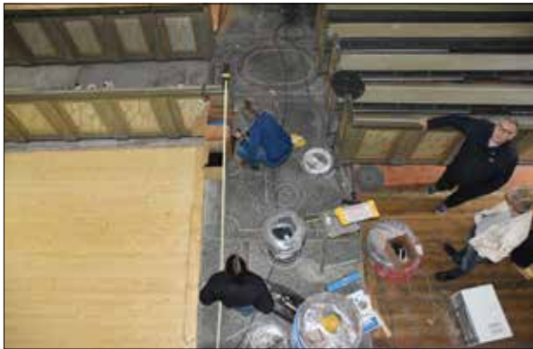
Figur 52. Kontrast mellan nyslipat och ännu inte slipat golv. Utblick från läktaren.
