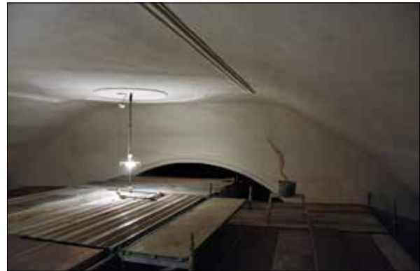
Figur 19. Utblick mot öster, lagning av spricka pågår.
