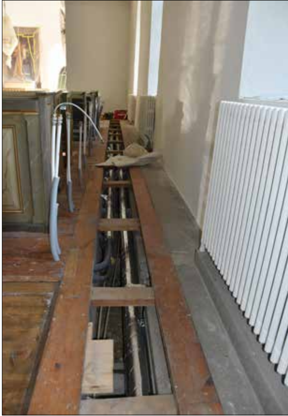
Figur 42. Nya rör monterade under golvet.
