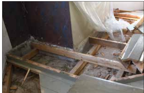
Figur 37. Upptaget trägolv i koret.
