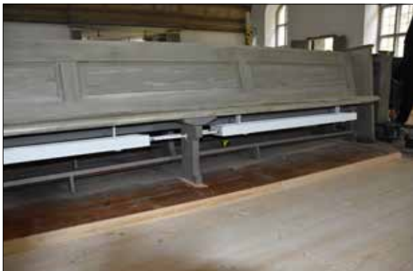
Figur 54. Detalj av bänkarnas nya uppvärmning på plats.
