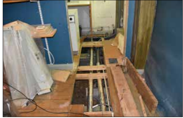
Figur 44. Ny rördragning under golv i köket.
