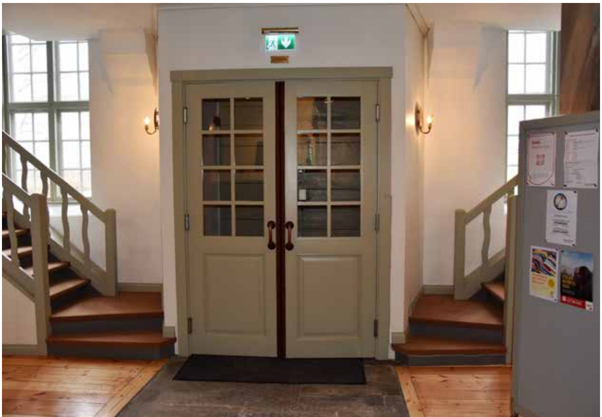
Figur 76. Pardörren har fått ny läderskoning (Tärnsjö 8680) och målats med linoljefärg i NCS S 3005- G80Y. Se även ny utrymningsskylt ovan dörren och nymålade trappträcken samt nyslipat golv som behandlats med hårdvaxolja.
