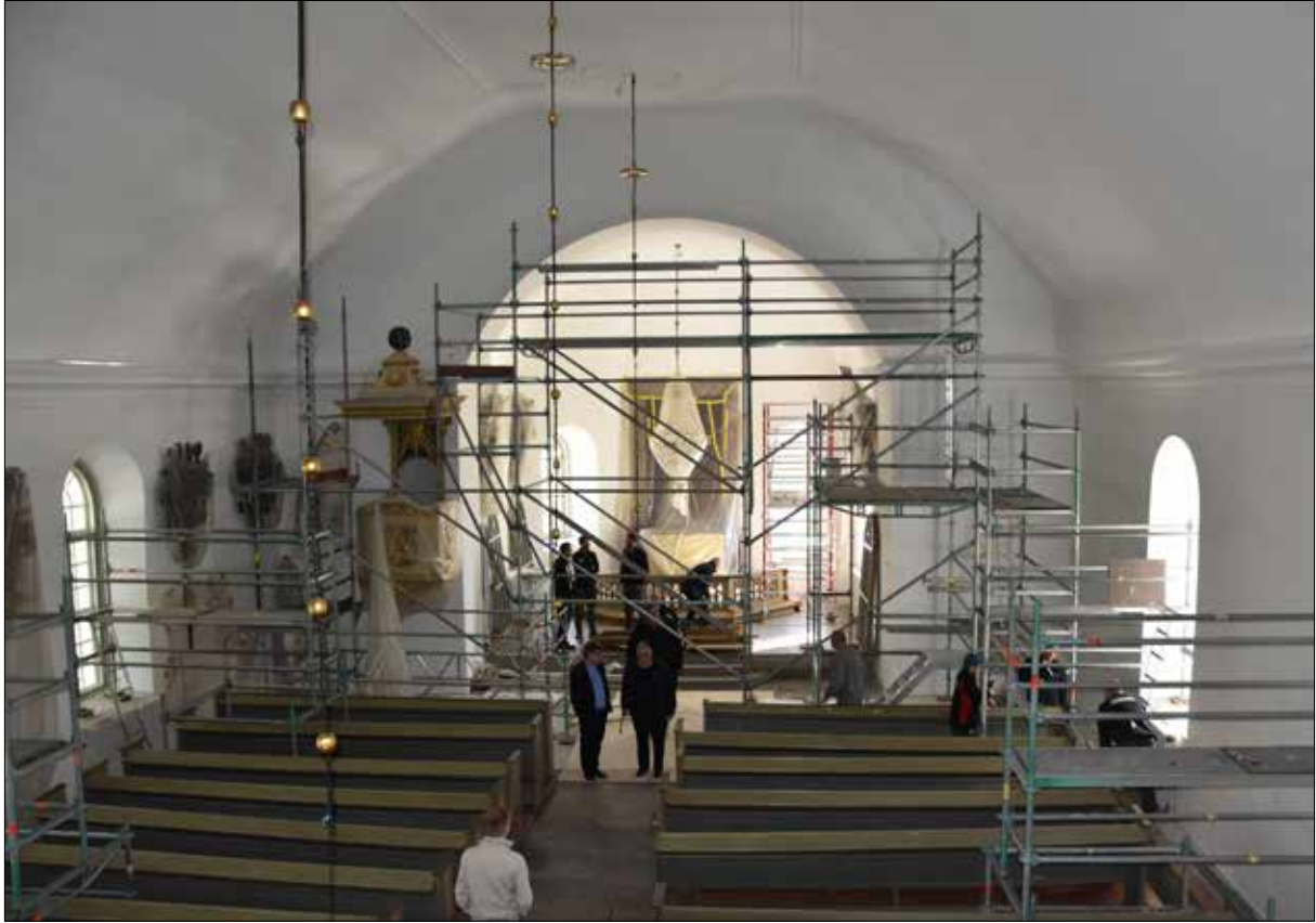
Figur 40. Kyrkorummet sett från läktaren i maj 2019. Vid besök pågår fönstermåning och dragning av ledningar under golvet i sidogångarna.
