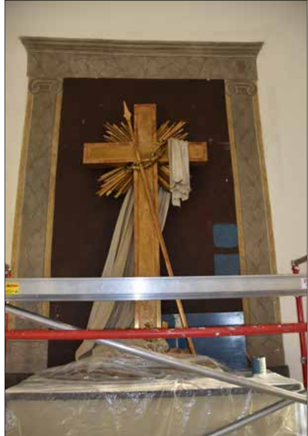
Figur 51. Dags att ta beslut om ny färgsättning av altarpappsatsen, september 2019.
