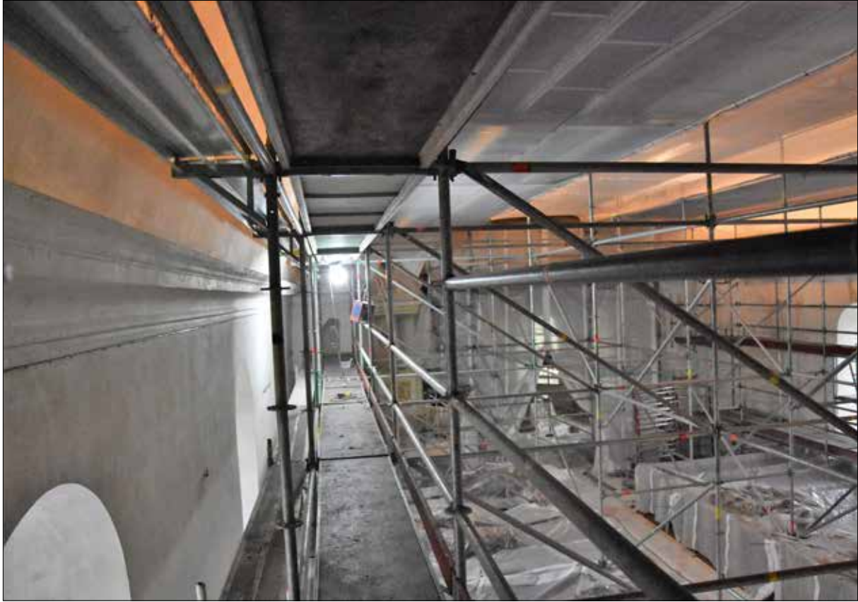
Figur 22. Ställningen upptar hela kyrkan, bilden visar kyrkans norra vägg. Lägg märke till den skulpturalt utformade gesimsen som förmedlar övergången mellan vägg och tak.
