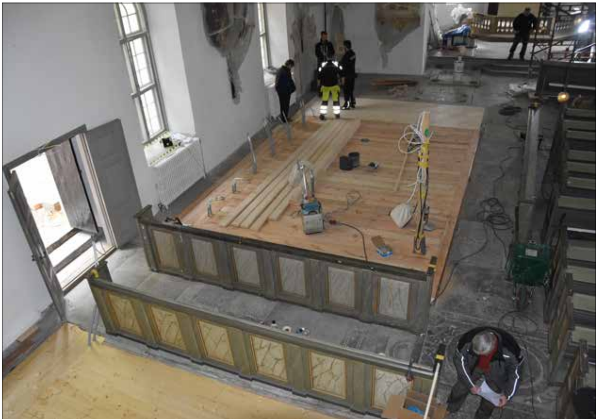
Figur 49. Utsikt från läktaren i september 2019. Kyrkbänkar bortplockade på norra sidan av kyrkorummet. Slipning av golv pågår.
