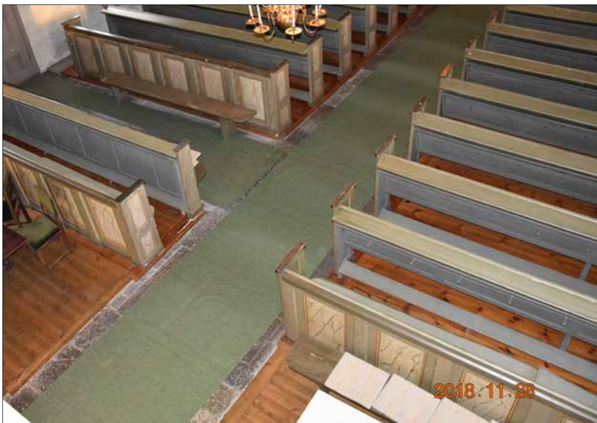
Figur 12. Utsikt från läktaren, lägg märke till golvplanken som var i behov av slipning.
