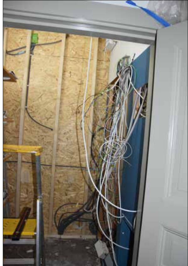
Figur 59. Fortfarande mycket arbete kvar att göra med eldragning. Utsikt in mot teknikrummet under läktaren.
