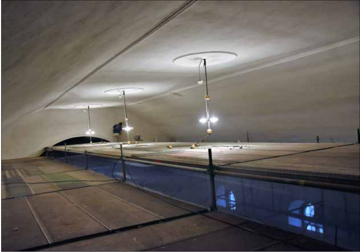
Figur 17. Mars 2019, ställningen är på plats och taket rengjort och alla sprickor lagade. Kalkavfärgning pågår en gång återstår.
