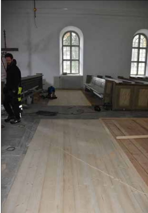
Figur 50. Nyslipat golv i den främre delen av kyrkorummet.
