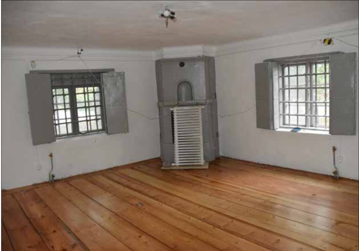
Figur 48. Sakristian (kyrkomuseum), golvet slipat och behandlat med hårdvaxolja. Lägg märke till utbytta brädor i nära anslutning till fönstret, till höger i bild. Även på motsstående sida behövde några brädor bytas ut.
