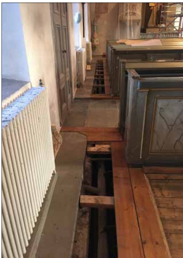
Figur 13. Trägolvet upptaget för inspektion av äldre rördragnings, norra sidan.
