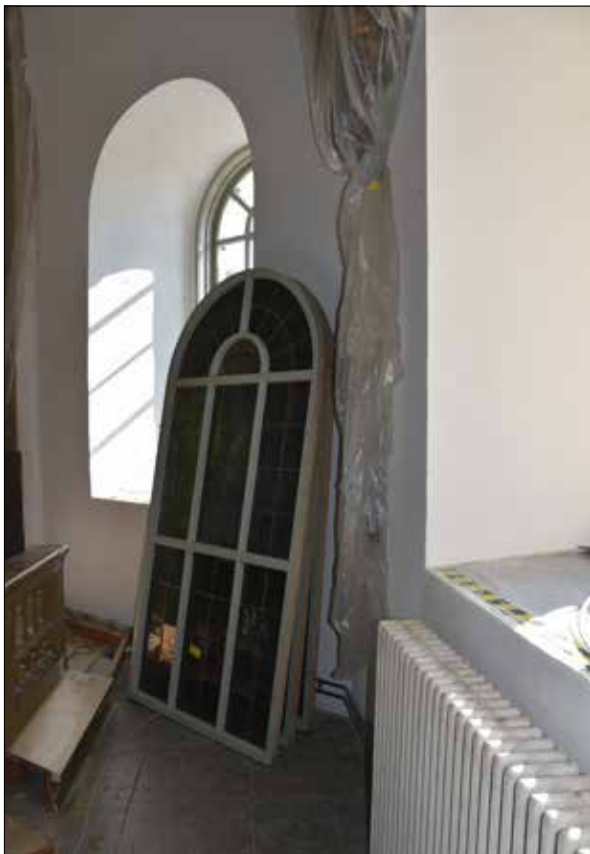
Figur 43. Nymålade fönster före montering i koret.
