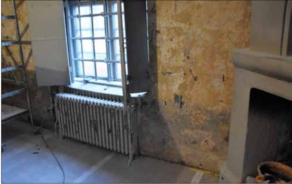
Figur 25. Sakristian, numera kallat kyrkomuseum, arbete pågår. Lägg märke till den äldre bröstmålningen med bård som påträffades. Möjligen är det en rest av Agi Lindgrens renovering som genomfördes 1901.
