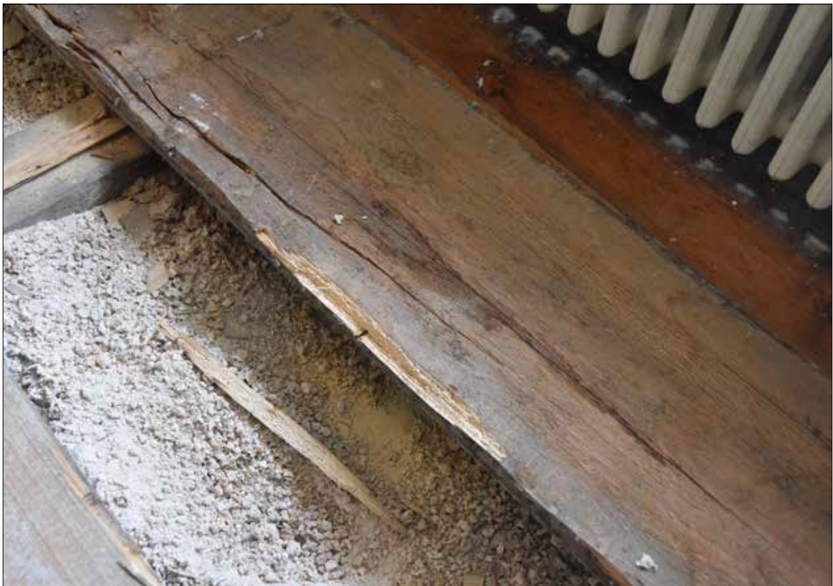
Figur 41. Detalj av golvplank i sakristian (kyrkomuseum) som visar sig vara angripet av svamp.
