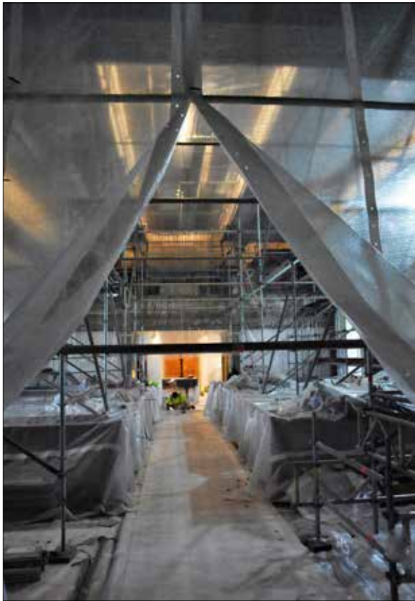
Figur 23. Kyrkans mittgång utsikt mot väster. Alla kyrkbänkar och gohytor är väl inplastade.
