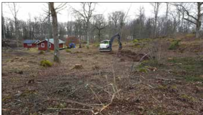
Figur 3. Sökschaktning inom objekt 11. Foto från norr.
