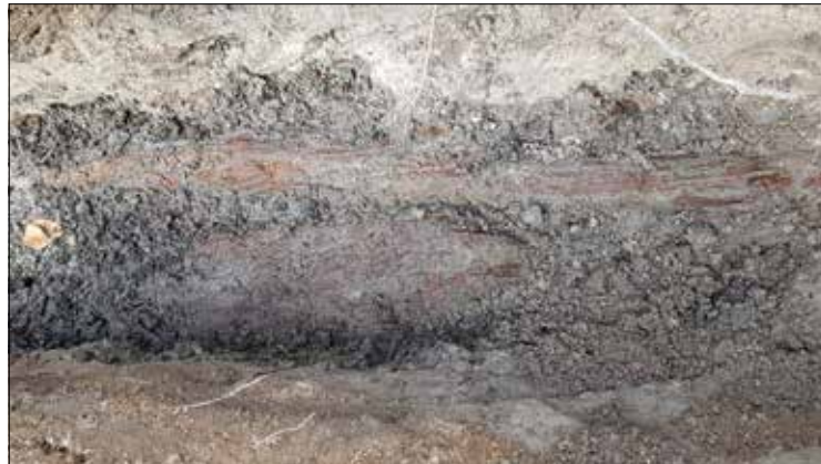
Figur 3. Träkonstruktion K11. Foto mot nordväst.
