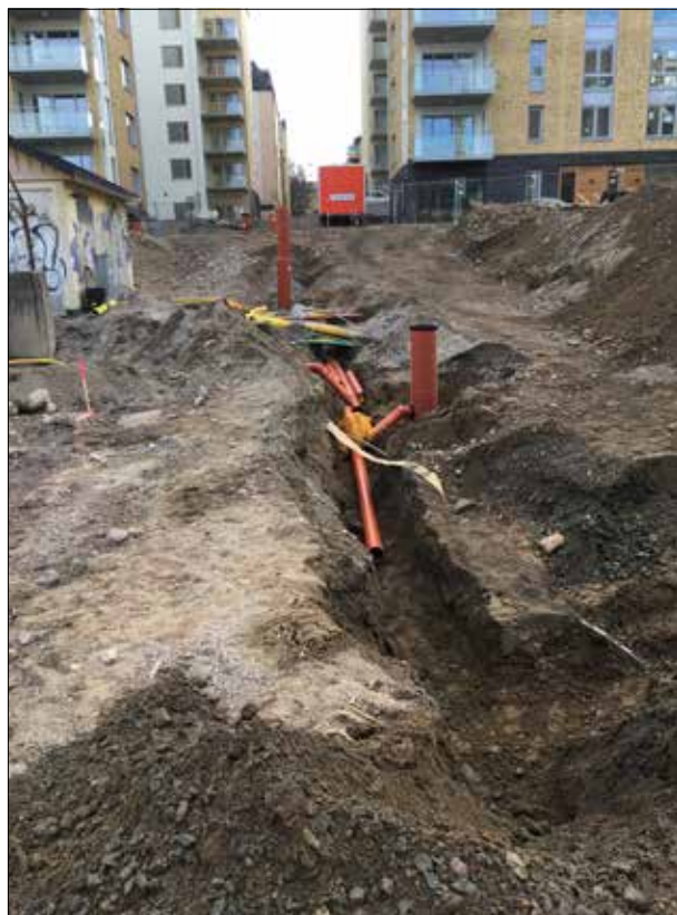
Figur 4. Schakt O300 från norr. Notera höjdskillnaden i terrängen.
