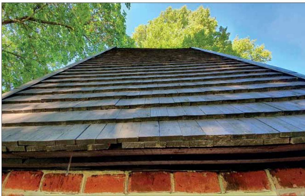
Bro kyrka, stiglucka. Sydvästra takfallet med sågade brädlappar.
