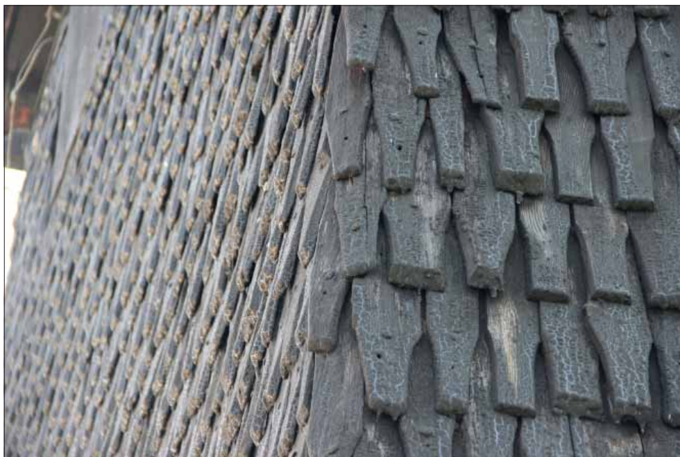
Svedvi klockstapel. Närbild på nordvästra fasadhörn. Lägningstekniken som använts skapar lätt rundade hörn vilket har stor betydelse i utseendet.
