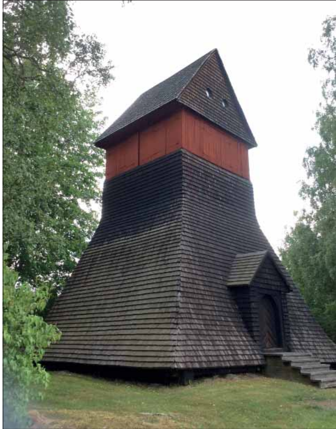
Hällefors klockstapel sedd från sydväst. Fasadspånen är raka och huvens takspån rundade.
