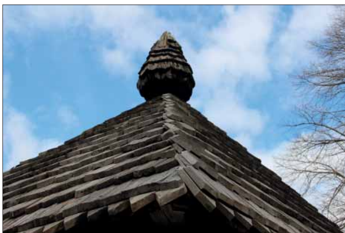
Tillberga kyrka. Närbild på snednockens avtäckning på västra stigluckan.
