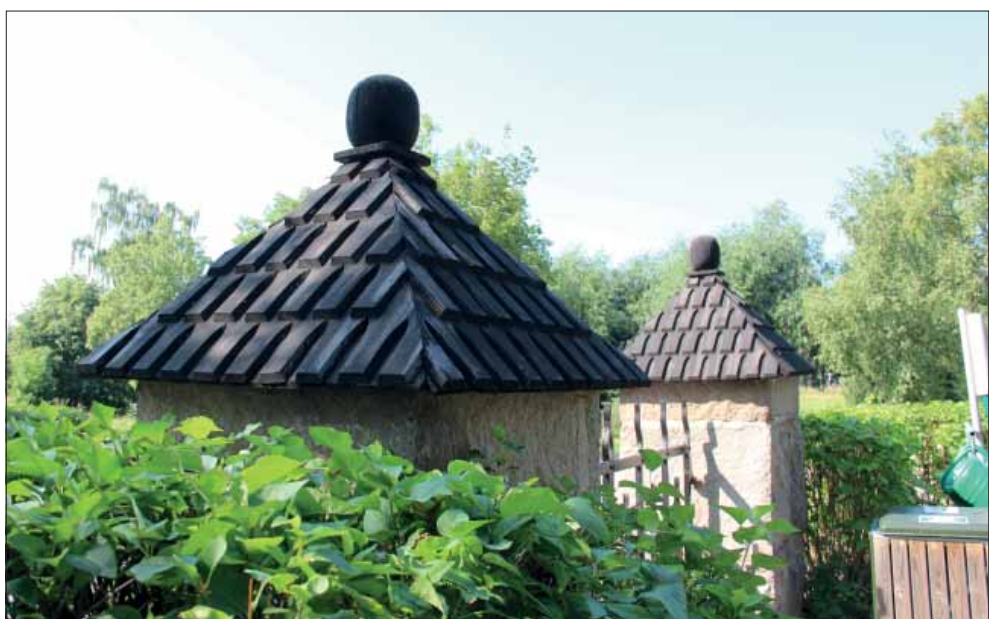
Svedvi kyrka. Grindstolpe i södra kyrkogårdsmuren, spånen liknar de som finns på klockstapelns södra och östra fasader.
