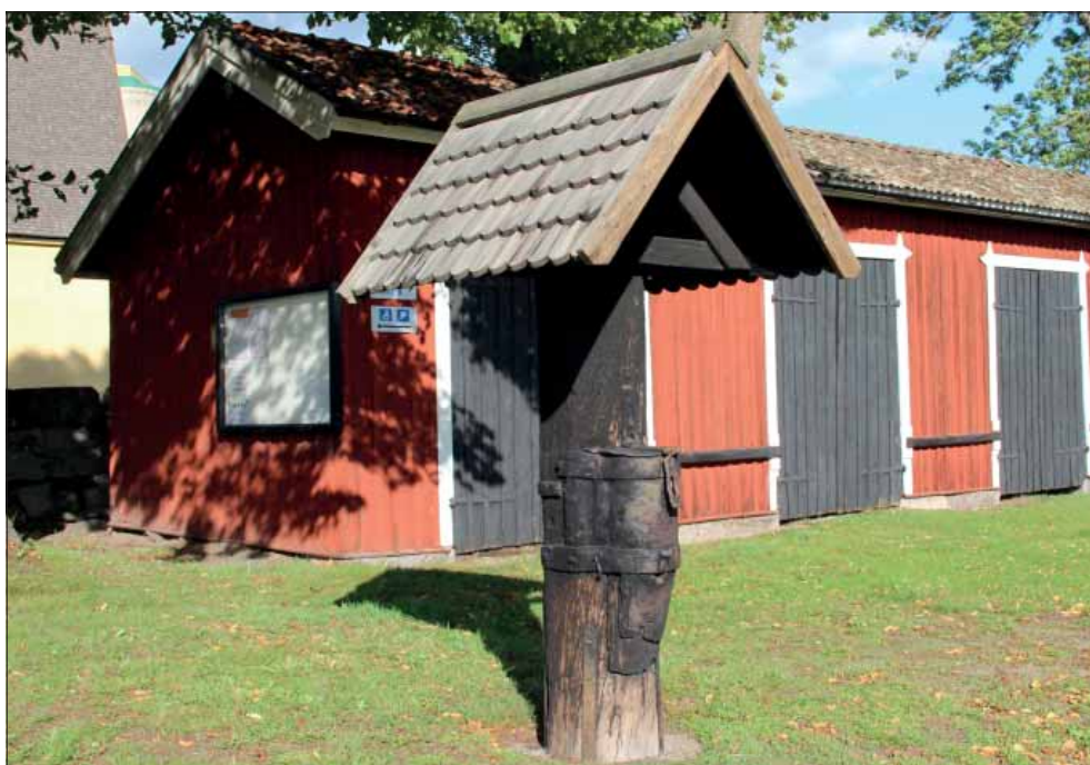
Sala sockenkyrka. Utanför kyrkogårdsmuren i söder finns en gammal fattighösa som har ett skärmtak av sågade spån eller brädlappar.
