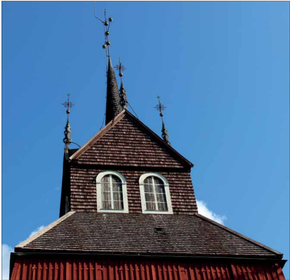
Möklinta klockstapel. Tak och fasad från väster.
