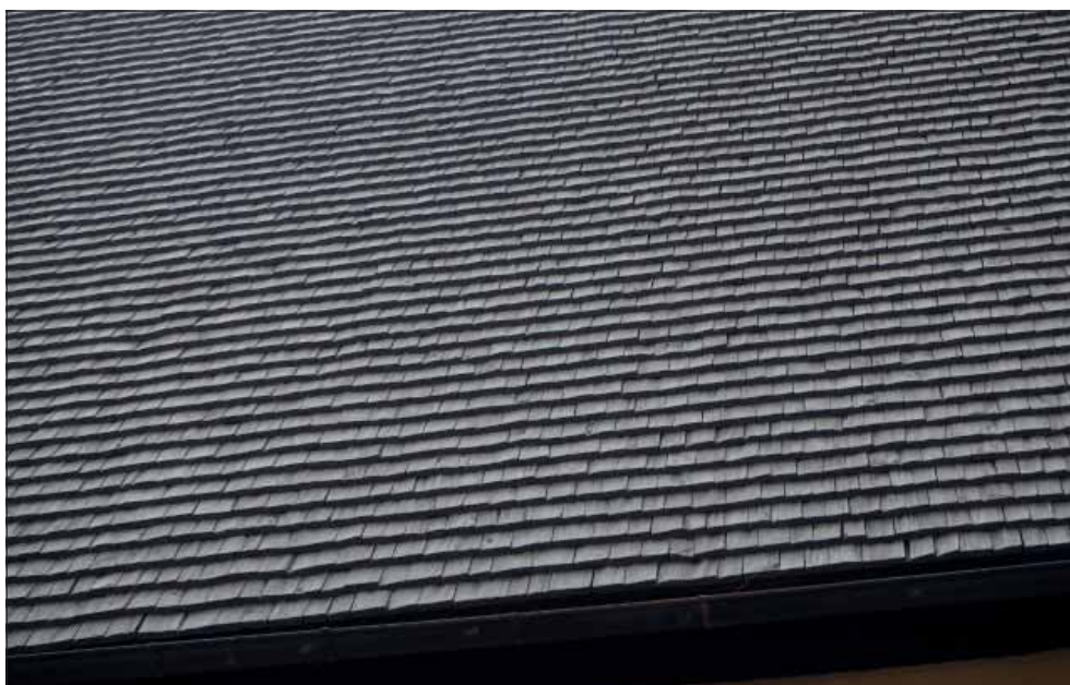
Kumla kyrka. Långhusets norra takfall.
