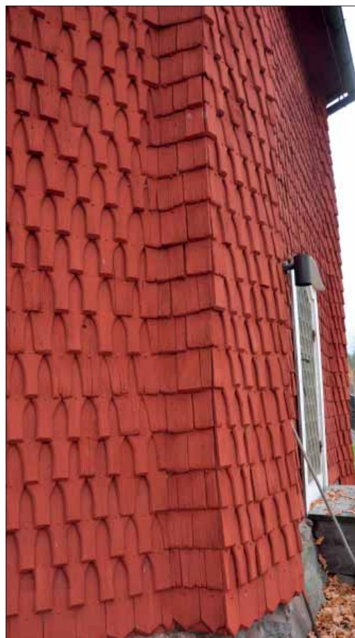
Sundborns kyrka. Fasadspånen är genomgående näbbformade, med undantag för knutbrädornas insidor där spånen har rak form med fasad kant. Det nedersta spånvarvet är spetsformat runt hela kyrkobyggnaden.
