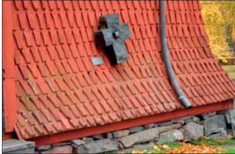
Sundborns klockstapel. Längst ner, på stapelns norra utkrågning, förekommer tryckimpregnerade sågade spån, med stor sannolikhet från 1970-talets renovering. Högre upp skymtar äldre, handbearbetade spån.
