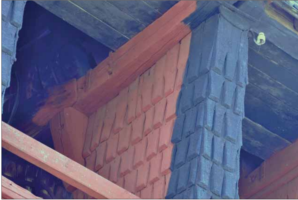
Ljusnarsbergs klockstapel. Spänklädda ljudöppningar i klockhuv.
