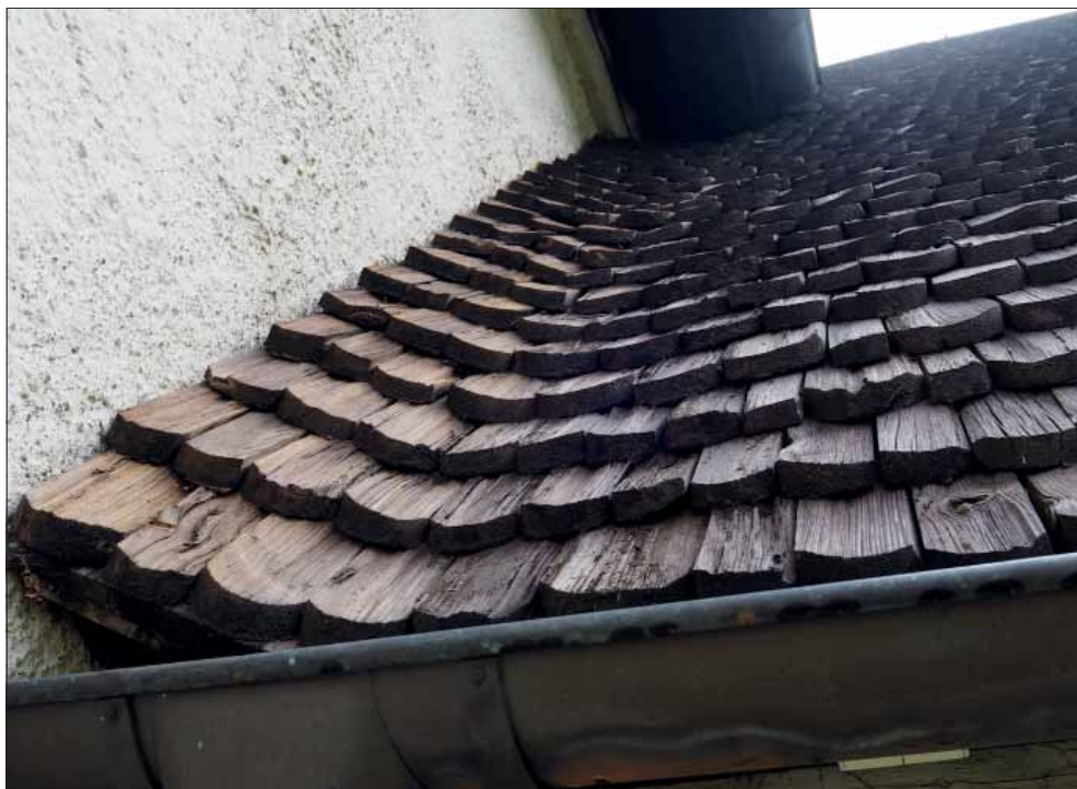
Kärbo kyrka. Vapenhusets västra takfall.
