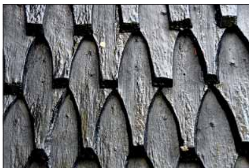
Särna gammelkyrka. Detalj av tornets nordfasad med näbbformade och huggna spån. Aldern uppskattas till 1800-tal.
