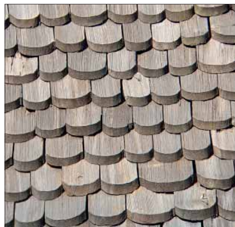
Sala sockenkyrka. Kikarbild på långhusets spån, södra takfallet.
