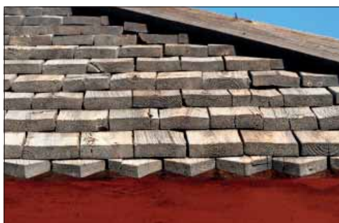
Amsbergs bårhus/gravkapell. På boden ligger, liksom på delar av klockstapeln, sågade spån från 1900-talets andra halva.
