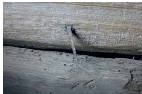
Äldre typ av spånspik som fotograferats från klockstapelns insida (av Bengt Bygdén). Spiken har rektangulär lägg och spetsig udd. Den rektangulära läggen gör att spiken inte splittrar virket när den vänds tvärs mot träets fiberriktning som bilden visar.
