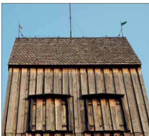
Kärro klockstapels södra takfall.
