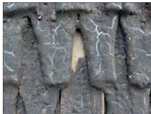
Kungs-Barkarö kyrka. Tornets övre fasad från sydväst. Kring ljudluckorna sitter spån med rak bas. Tornet spånslogs av ryttaren Petter Forsberg år 1784. Spikhål i flera spån tyder på återanvändning så möjligen finns äldre spån.
