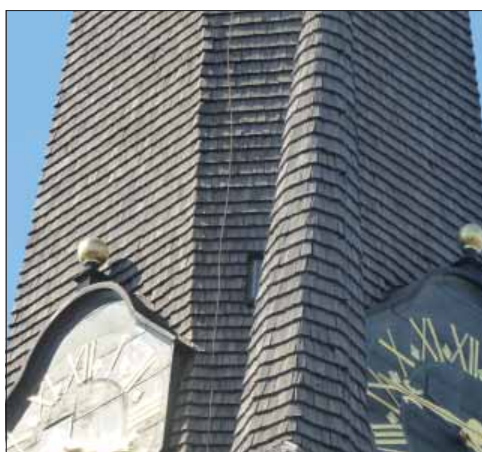
Heliga Trefaldighets kyrka, Arboga. Spåntäckning i närbild.
