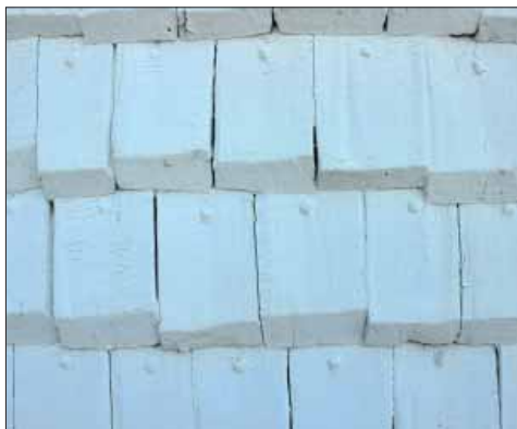
Mockfjärds kyrka. Tornets fasad sedd från söder. Spånen har synlig infästning och är målade med vit oljefärg.
