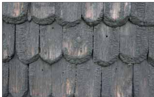
Odensvi kyrka. Fasadspånen är rundade med fasad kant och i sin helhet huggna. Virket är tätvuxet och kvistfritt. Infästningen med smidd spik är synlig och spikhålen tyder på återanvända spån. Ytbehandlingen är tjära. Spår av rött skikt finns i botten, närmst träet, är av hög ålder, eventuellt från 1770-talet eller är äldre än så.
