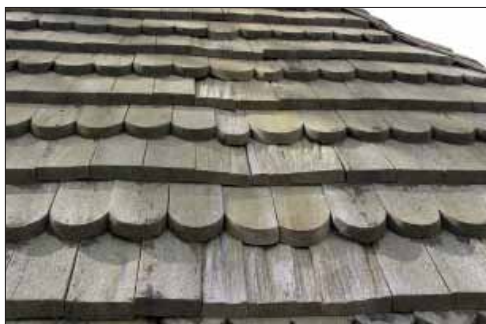
Tillberga kyrka. Sågade spån med ilagningar av kluvna, västra sticluckan.
