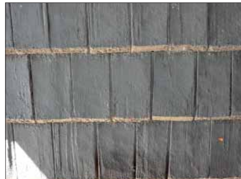
Hosjö kyrka. Detalj av spåntäckningen på den äldre inälgående kyrkporten. Den är klädd med raka spån med fasad kant och huggen ovansida.
