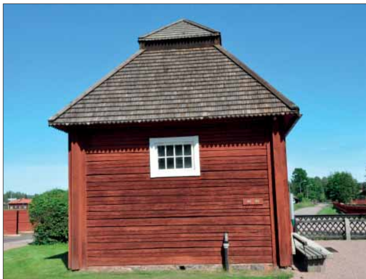
Amsbergs bårhus/ gravkapell med säteritak. Det nedersta spånvarvet är spetsformigt liksom på samtliga spånklädda takfall i Amsberg
