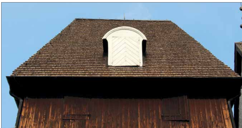
Säby klockstapel. Sägade ekspån på klockstapelns södra takfall, de kan vara lagda 1947.
