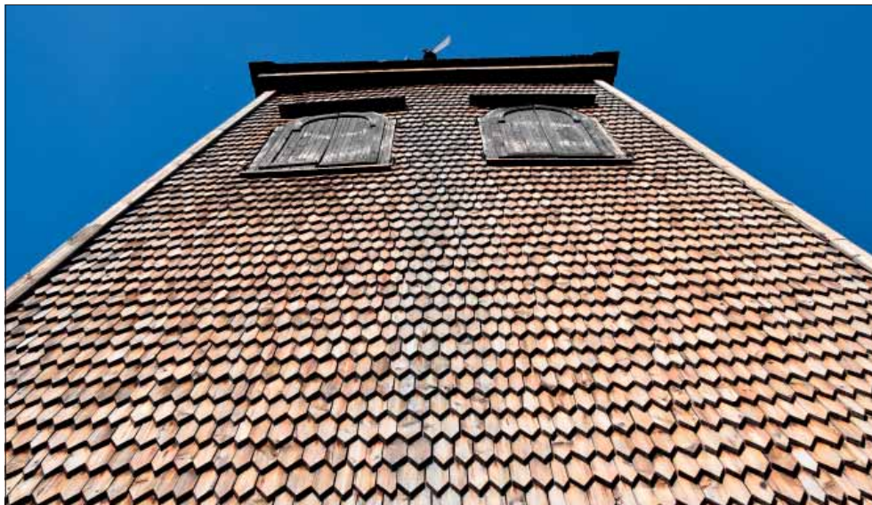
Sälsnäs klockstapel. Fasaden sedd nerifrån marken
