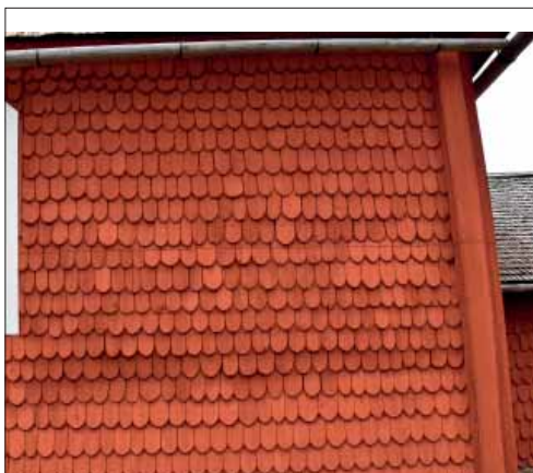
Envikens gamla kyrka. De nyare, sågade spånen avtecknar sig som ljusa i fasaden.
