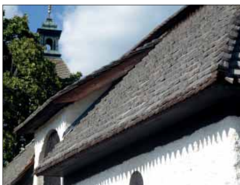
Götlanda kyrka. Detalj av spåntak på sockenmagasinet, i bakgrunden skymtar kyrktornet.
