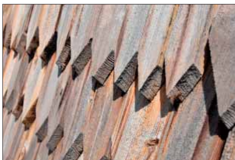
Säfsnäs klockstapel. Baser och kanter är sågade på samtliga spån.
