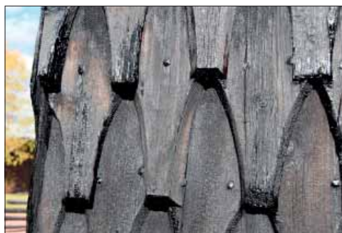
Särna gammelkyrka. Detalj av tornets sydfasad. Näbbspånens infästning är synlig och fasaden helt nytjärad.
