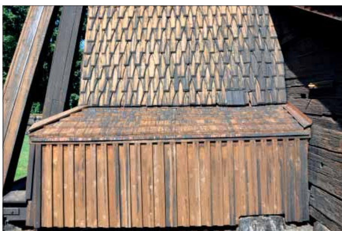
Torsångs klockstapel. Spåntäckningen på södra kragen består av maskin- hyvlade bräder, lagda efter 2015.
