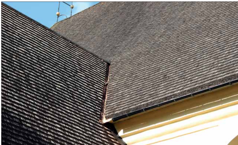
Möklinta kyrka. Rännal med kopparplåt och långhusets södra takfall samt vapenhusets östra takfall.
