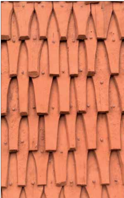
Hällefors kyrka. Fasadspänen är mycket gamla och välbevarade på i stort sett hela kyrkobyggnaden.
