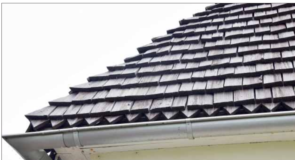
Folkärna bårhus. Spåntäckningen på norra bårhuset utgörs av kluvna raka spån, nedtill kantat med en rad spetsspån.
