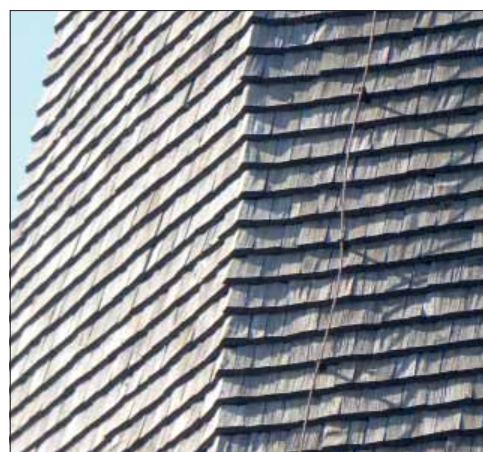
Heliga Trefaldighets kyrka, Arboga. Detalj av torntakets spån.
