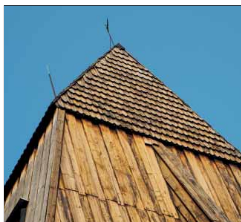
Kärro klockstapel. Huvens östra fasad, sedd från sydöst.
