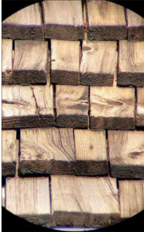
Säby klockstapel. Kikarbild på de sågade ekspånen.
