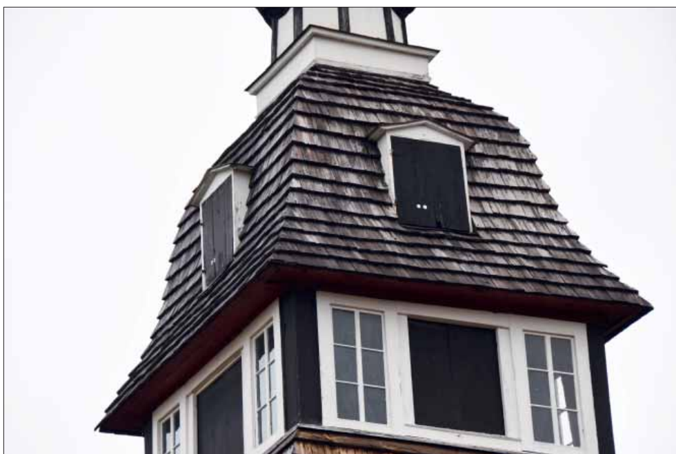
Bingsjö kapell. Tornet med klyvda spån på huvan. Dessa spån har silvriga utfällningar i tjäran.
