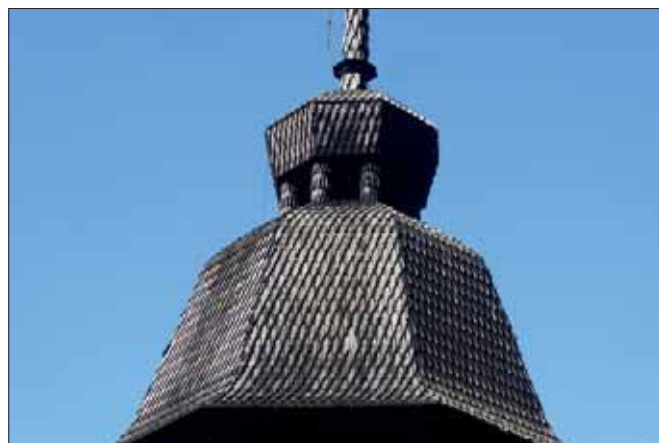
Klockhuv och lanternin. Foto: Bengt Bygdén.
