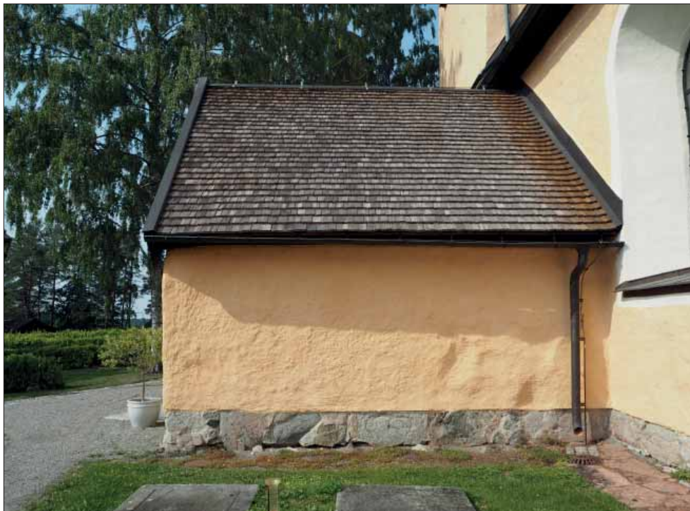
Kumla kyrka. Vapenhusets östra takfall.
