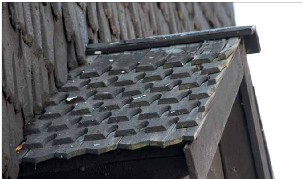
Svedvi klockstapel, sågade spån på entrétaket mot norr.
