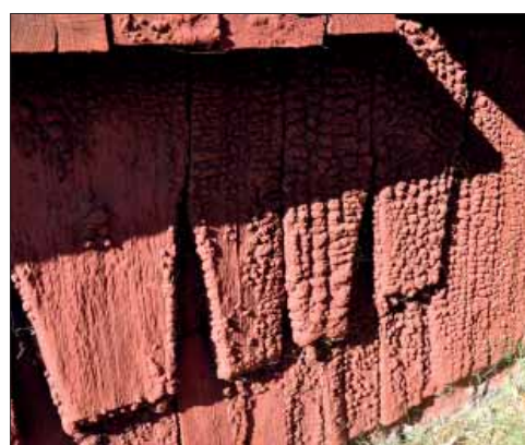
Djura klockstapel. Bild av huggna spån i mycket breda dimensioner. Troligen några av de äldsta kvarvarande spånen på Djura klockstapel. Återfinns långt ner, mot mötande fasader.
