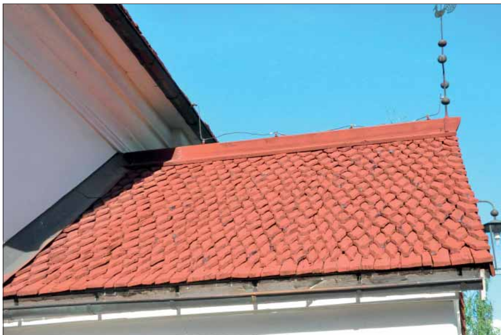
Djura kyrka. Näbbformade, rödtjärade spån är karakteriserande för Djura kyrka. Här på västra vapenhusstakfallet.
