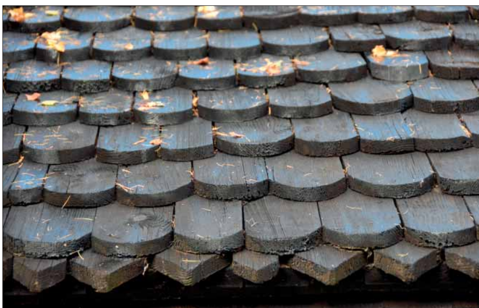
Särna gammelkyrka. Långhusets och sakristians tak har rundade spån, nedtill kantat med spetsspån.
