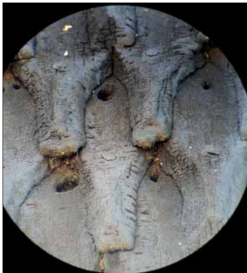
Svedvi klockstapel, sågade spån på östra fasaden.
