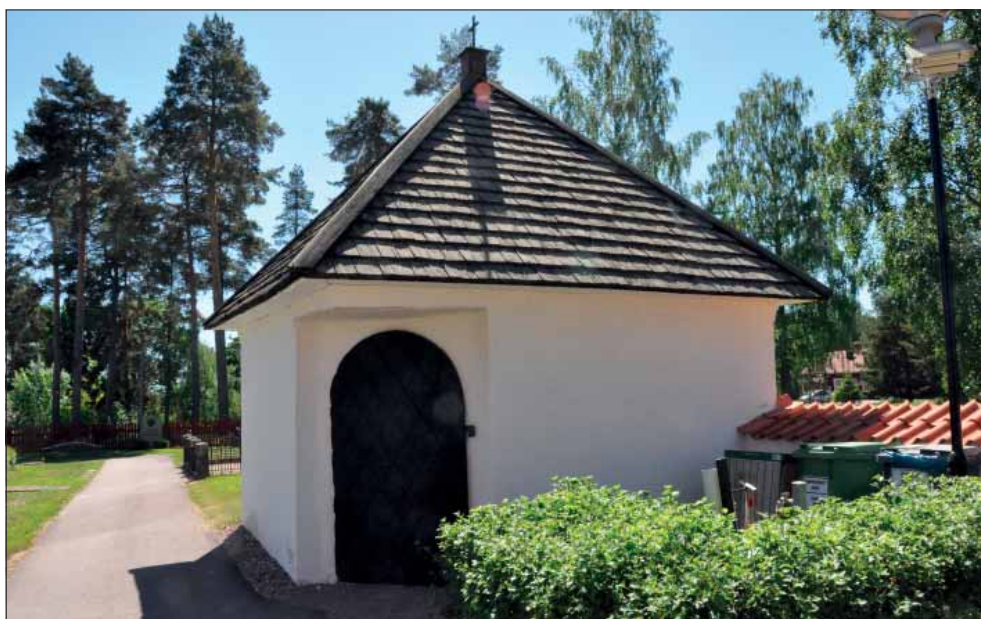
Hosjö bårhus. Bårhusets tälttak är täckt med raka spån med brädnockar.
