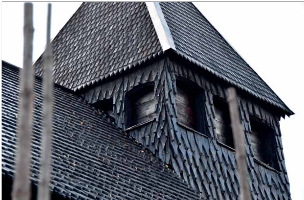
Särna gammelkyrka. Torntaket täcks av näbbspån som i sin helhet är sågade.
