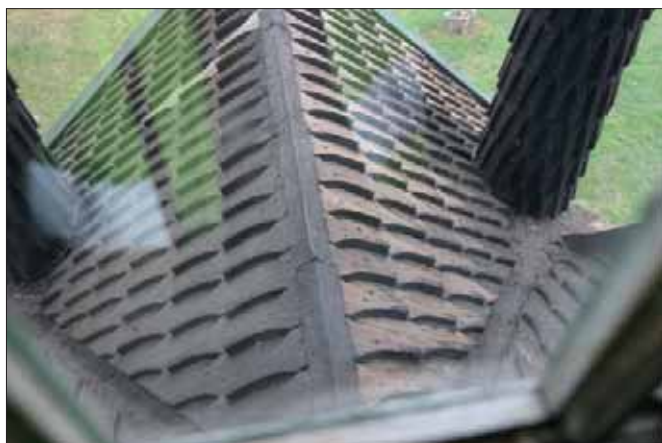
Takfall över stenfoten mot öster. Foto taget genom fönster. Över nock och i rännedal ligger plåt. Foto: Lisa Skanser.
