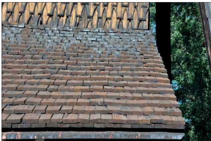
Torsångs klockstapel. Entrétakets spån är senare tillkomna. De är klyvda med sågade kanter och baser.
