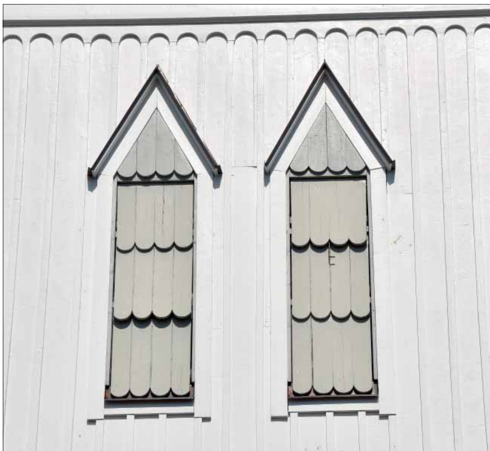
Äppelbo kyrka. Tornets ljudluckor består av rader med vinklinsbara, rundformade spån.
