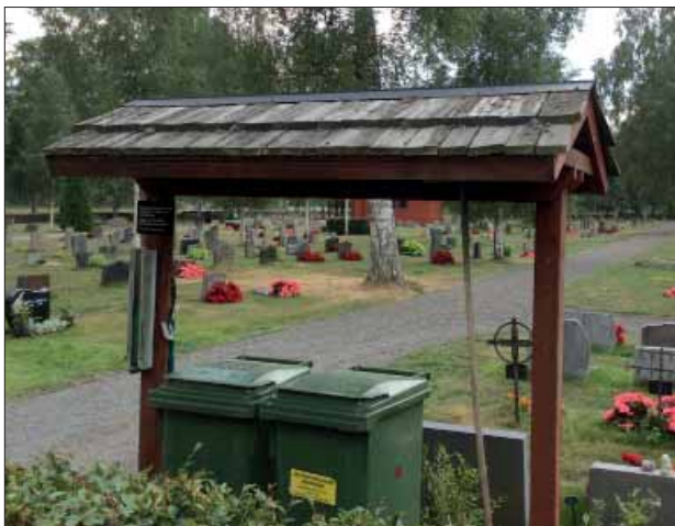
Hällefors gravkapell har raka takspån och näbbformade fasadspån.
