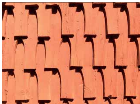
Ljusnarsbergs kyrka. Näbbformade spån med rak kant på kyrkans söderfasad. Spånen är i grunden sågade men spår efter hyvel och yxa förekommer.
