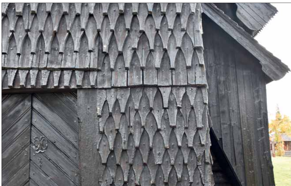
Särna gammelkyrka. Ovanför västportalen finns ett parti med raka spån. Södra, östra och västra tornfasadernas huggna näbbspån bedöms vara från 1700-talet.
