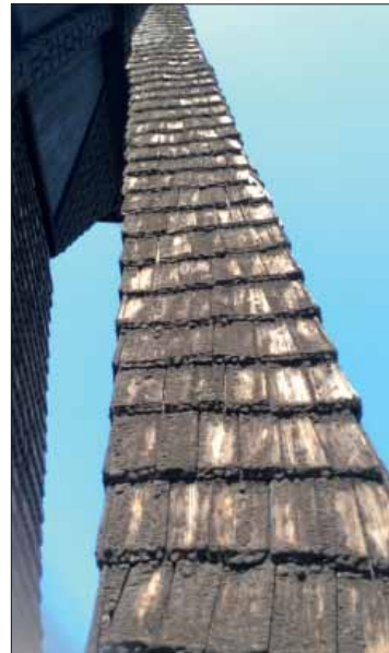
Ljusnarsbergs klockstapel. Närbild på raka spån, nedre delen av klockstapelns östra sträva. Foto från söder.
