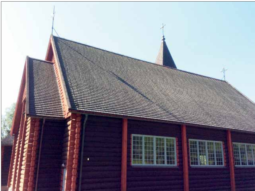
Hörkens kyrka. Kyrkans norra takfall. Spånen är rundade och nedtill finns mönsterläggning med spetspån och raka spån.
