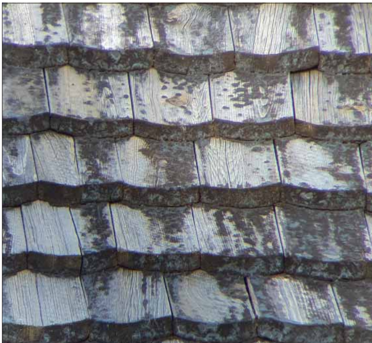
Sala sockenkyrka. Närbild på spån på långhusets norra takfall, troligen från 1961–1962.
