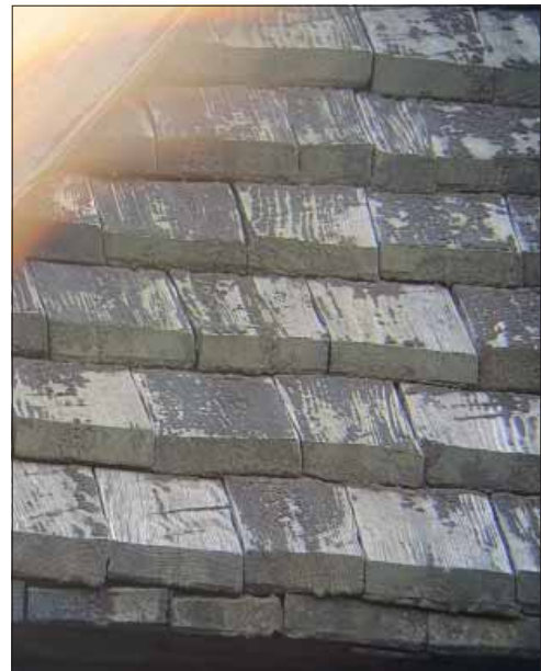
Möklinta klockstapels nedre takfall mot norr, detaljbild på huggna spån
