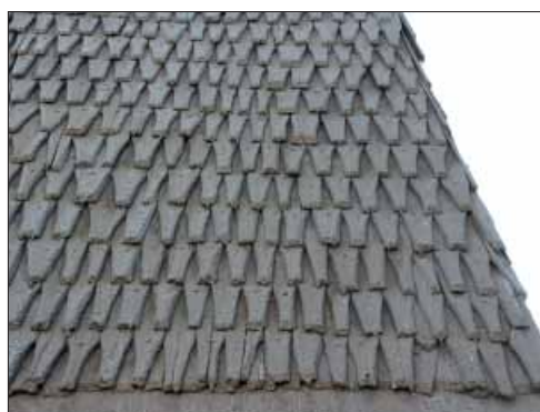
Svedvi klockstapel. Olika spån-generationer förekommer. Ålderdomliga spån finns på norra och västra fasaden medan södra och östra är klädda med sågade spån, eventuellt från sent 1980-tal.
