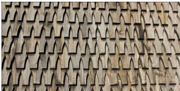
Malma kyrka. Spån på västra fasaden.
