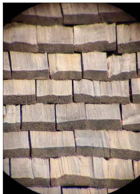
Säby kyrka. Kikarbild på långhusets klivna spån, södra takfallet.
