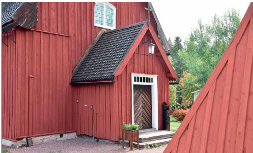
Evertsbergs kapell. Vy mot vapenhuset. Takytan är homogen med sågade spån i lika dimensioner.
