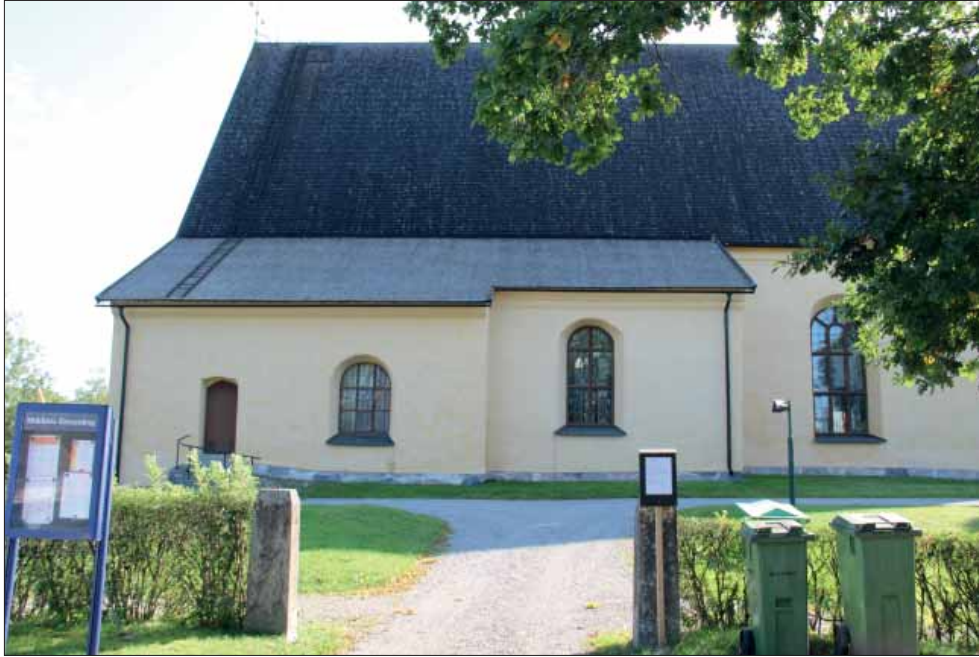
Möklinta kyrka. Kyrkan med sakristian utmed långhusets norra fasad.
