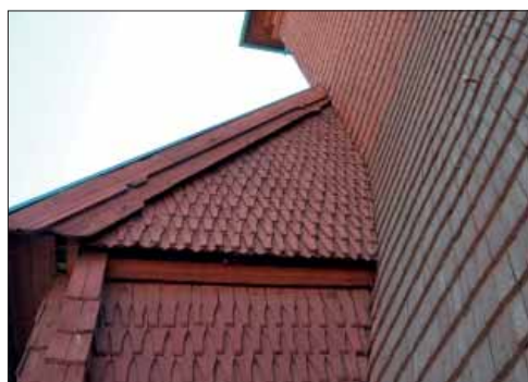
Hosjö kyrka. Fasaden åt väster bevarar äldre näbbformade spån, som möjligen härrör från 1700-talet.
