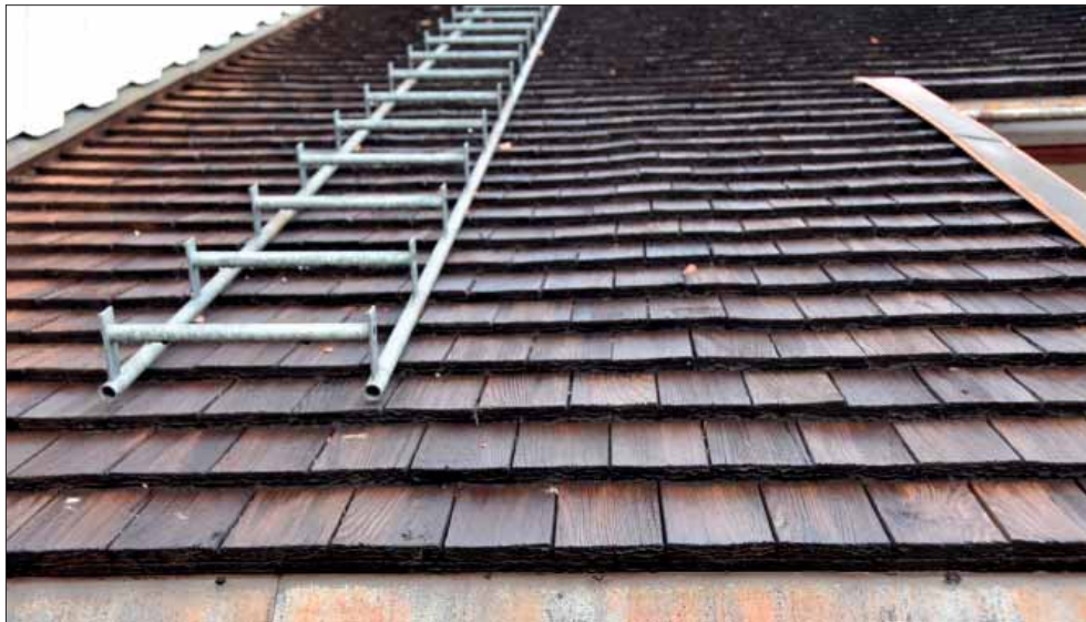
Bingsjö kapell. De sågade spänen på långhus och sakristia är vända "upp-och-ner".
