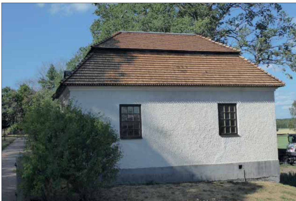
Götlanda kyrka. Bårhusets tak har raka spån med en kant av spetspån.
