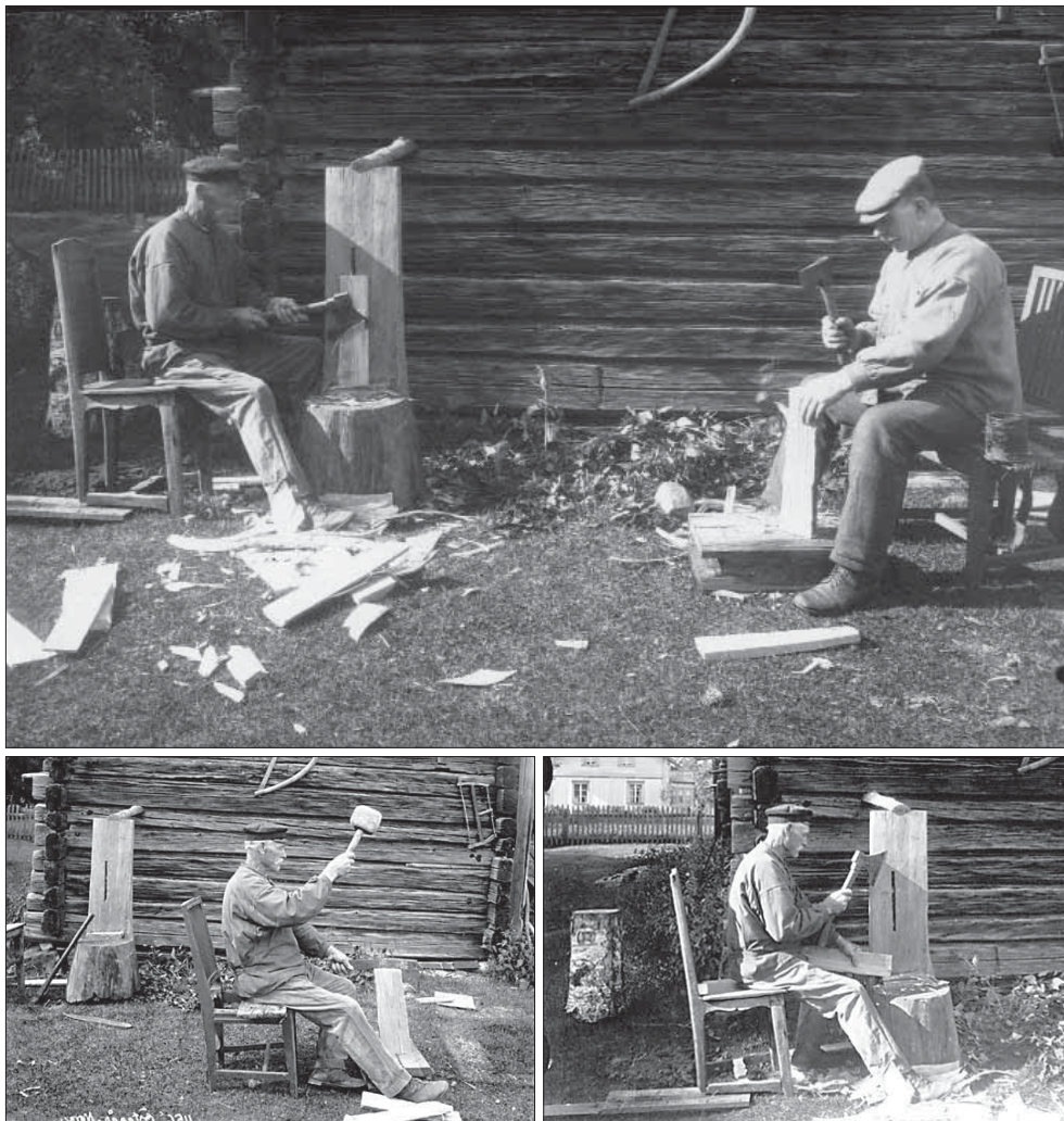
Figur 14–16. Bildsvit på spåntillverkning. Bilderna är tagna 1924 av Sven T. Kjellberg och platsen är Östanäs i Nora socken i Uppland. Bildkälla Västmanlands läns museum, figur 14 neg. nr A-1155, figur 15 neg. nr A-1156, figur 16 neg. nr A-1157.
