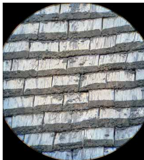
Möklinta kyrka. Kikarbild på långhusets södra takfall. Spånen är lokalt tillverkade 1931 av virke ur prästgårdsskogen.
