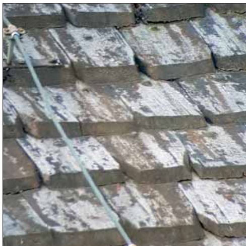
Rättviks kyrka. På kyrkans långhustakfall, nära koret mot norr, finns äldre, handbearbetade spån. Baserna är lätt näbbformade. Lägg märke till spåren av rödtjär. Spånen hör till några av kyrkans äldsta kvarvarande spån och utgör viktigt referensmaterial inför underhållsarbeten på kyrktaket.
