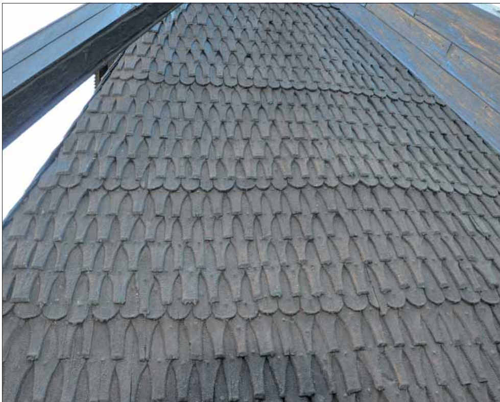
Torsångs klockstapel. Mönsterläggning på västra fasaden.
