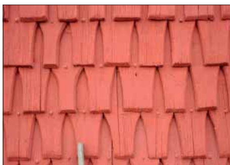
Sundborns kyrka. Spån med huggna bleken på östra korsarmens södra sida tillsammans med enstaka senare, sågade, kompletteringar.
