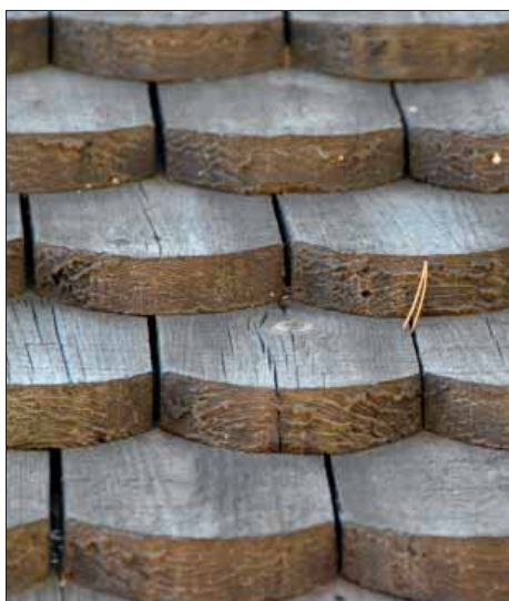
Lumshedens kapell. Den sågade spåntäckningen på klockstapelns tak. Märk de liggande årsringarna samt kvistförekomsten.
