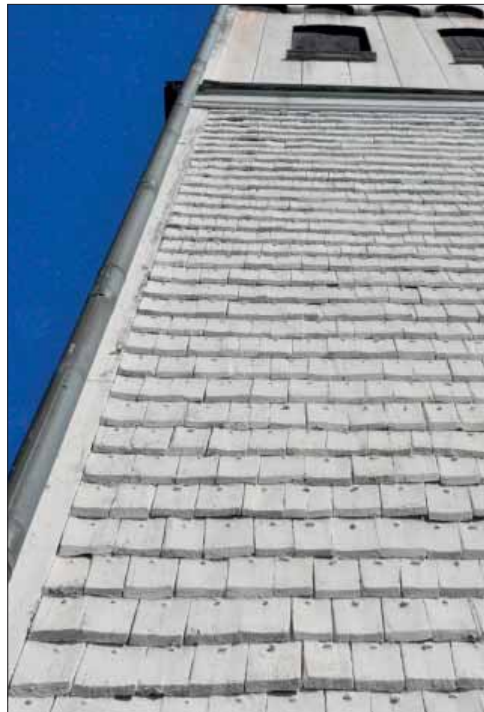
Mockfjärds kyrka. Tornets fasad sedd från söder. Spånen har synlig infästning och är målade med vit oljefärg.
