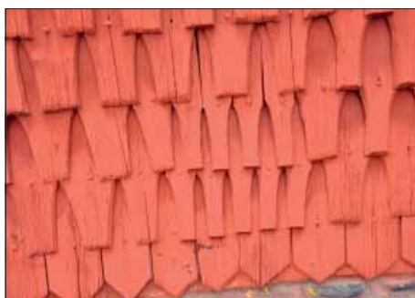
Sundborns kyrka. Klyvda spån på västra korsarmens sydfasad. Troligen tillkomna efter att 1970-talets tryckimpregnerade spån tagits bort.
