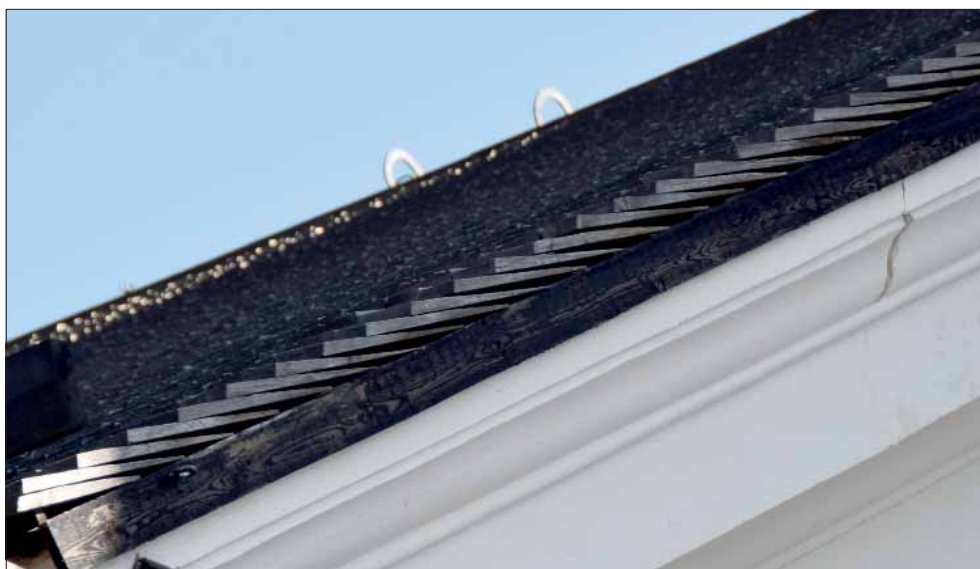
Siljansnäs kyrka. De klyvda spånen på norra långhustakfallet sedda från gaveln.
