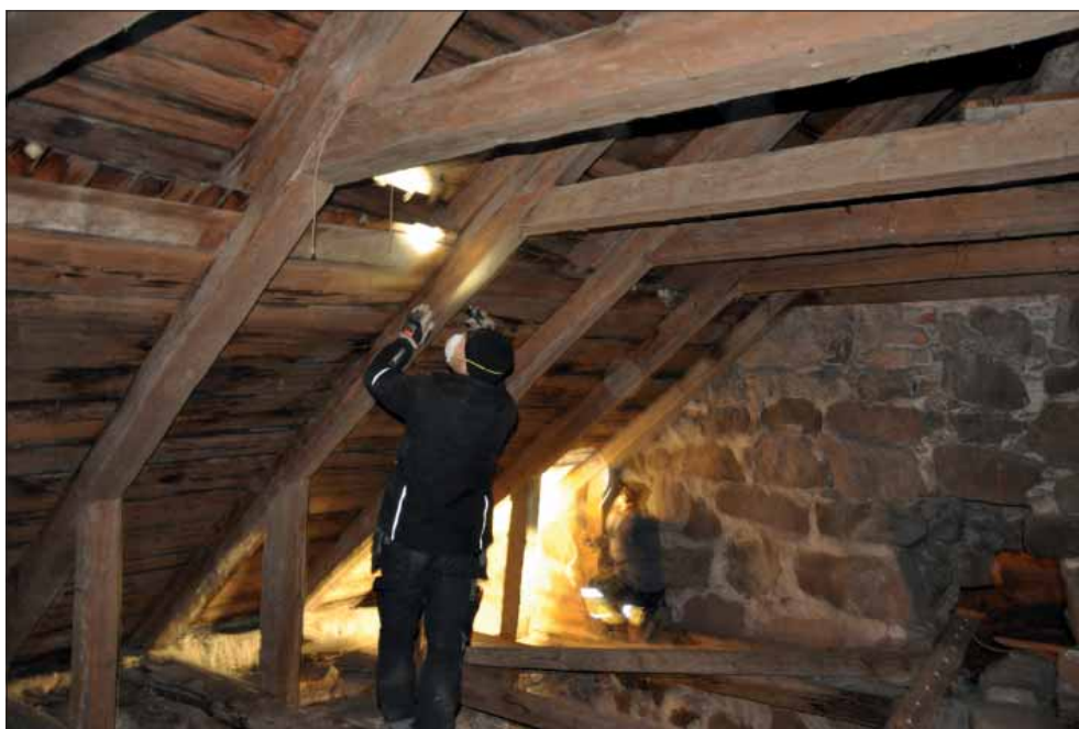
Figur 56. Daniel Eriksson och Lisa Skanser undersöker korets södra sida från vinden i november 2018. Undertaksbrädorna uppvisade två generationer spikhål vid en nära granskning. Foto Lars Jönnes.
