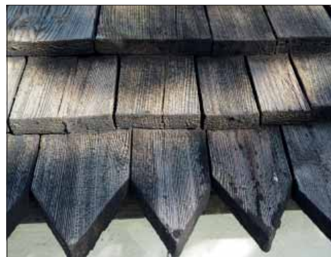
Rytterne bårhus, södra takfallet.
