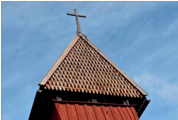
Evertsbergs klockstapel med de näbbformade spånen på gavelpartierna i öst och väst.
