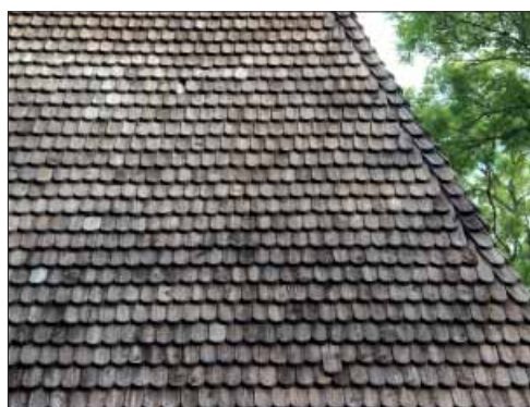
Torpa klockstapel. Södra fasadens spånläggning.
