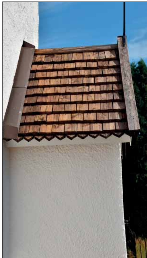
Äppelbo kyrka. Sägade spån på den södra korentréns takfall.
