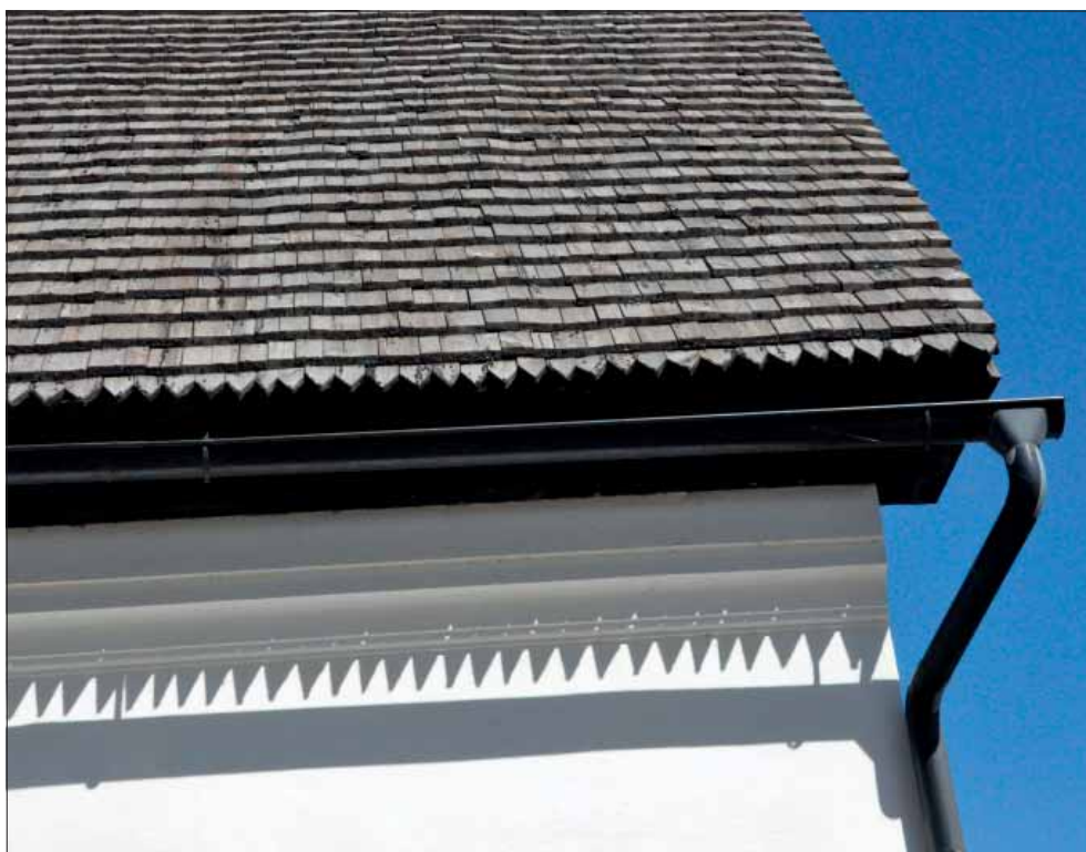
Vika kyrka. Södra takfallet med det genomgående spetsformade spånvarvet nedtill.
