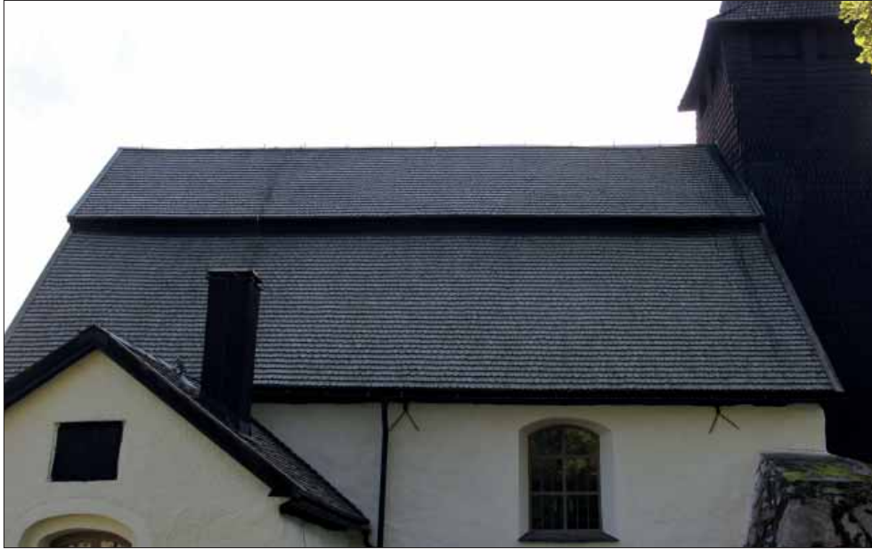
Kungs-Barkarö kyrka. Långhusetets södra takfall med klyvda och tjärddoppade spån från 1990.
