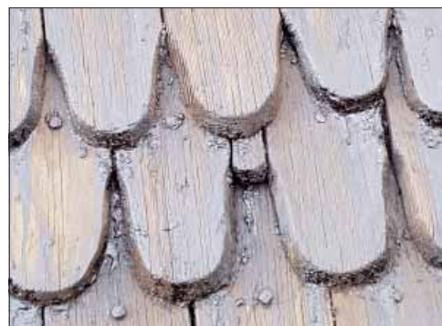
Sakristian spån på västra takfallet, notera den lilla rundade spånkilen.
