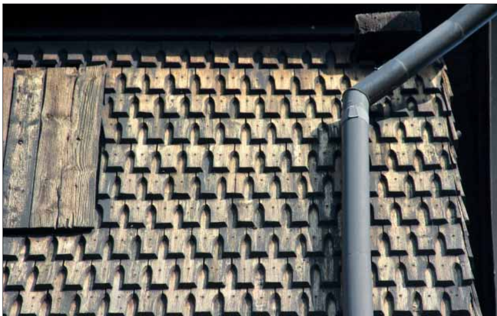
Svedvi klockstapel, sågade spån på södra fasaden.
