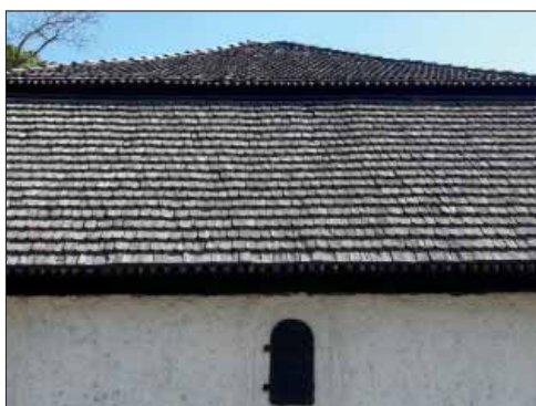
Götlanda kyrka. Sockenmagasinet spåntak från norr.
