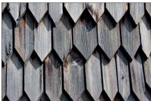
Säfsnäs klockstapel. Spån på nordfasaden. Här syns spåren efter sågen tydligt, liksom de många kvistar som förekommer i virket.
