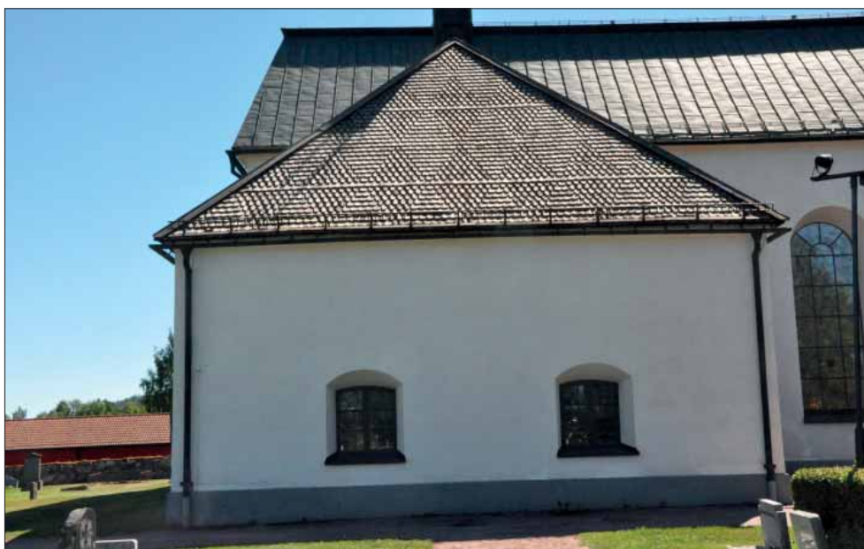
Gagnefs kyrka. Sakristian med rombmönstrad spåntäckning
