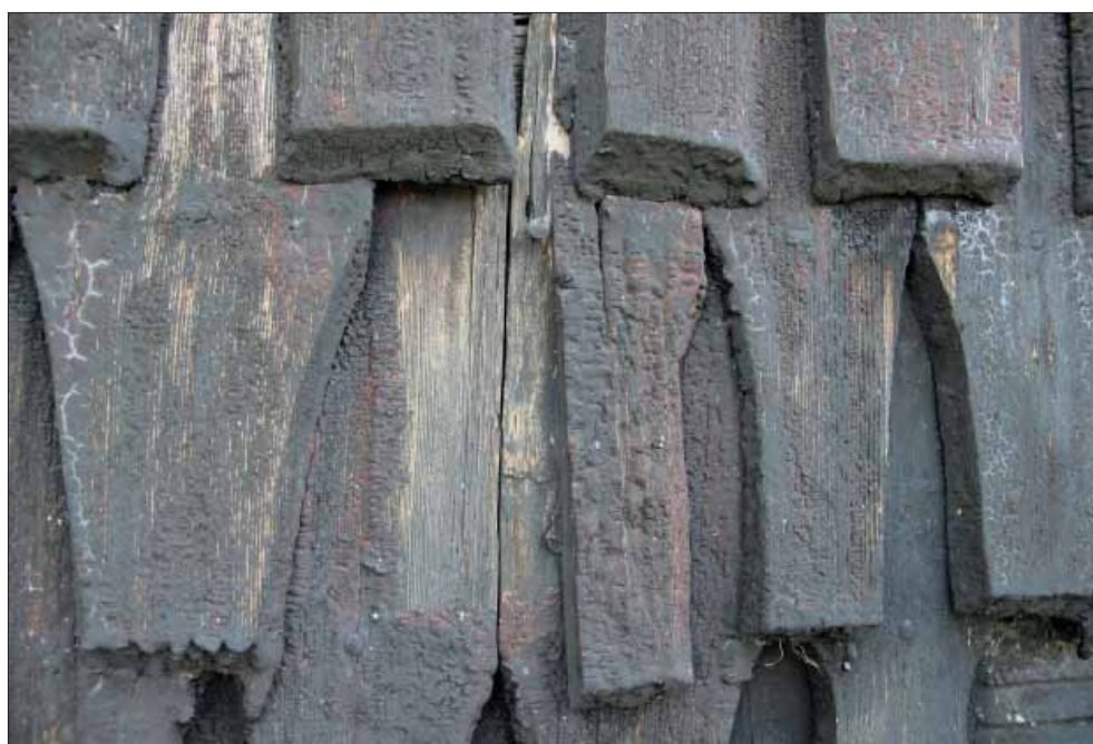
Figur 38. Av Sura gamla kyrka i Västerås stift återstår sakristian som numer utgör kapell och minnesplats. Stavspånen på västra fasaden uppskattats vara från 1600-talet. Spår efter röda pigment finns i underliggande tjärsikt. Foto Lisa Skanser.
