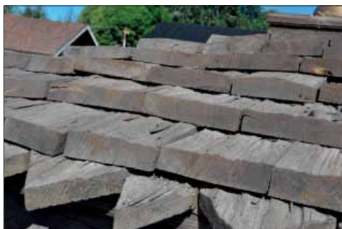
Dala-Floda kyrka. Grindstolpar avtäckta med spån.
