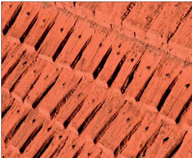
Leksands kyrka. Spån på lökkupolen, sentida klyvda på ovandelen och huggna 1700-talsspån på nedre delen.
