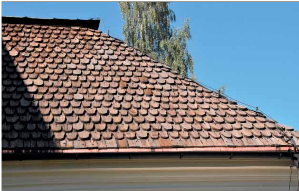
Orsa kyrka. På sakristian förekommer en spåntyp med ovanlig form. På det östra takfallet finns sentida lagningsspån som anpassats i formen till de äldre bevarade spånen..
