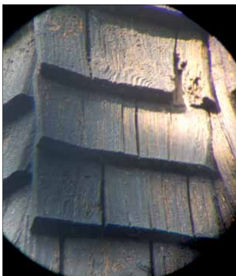
Kvarnsvedens klockstapel. De sågade spänen på tornspiran.
