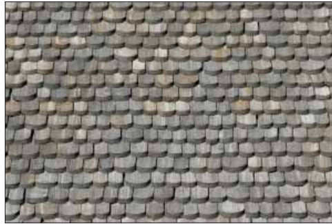
Kungs-Barkarö kyrka. Långhusetets norra takfall med spån från 1990.
