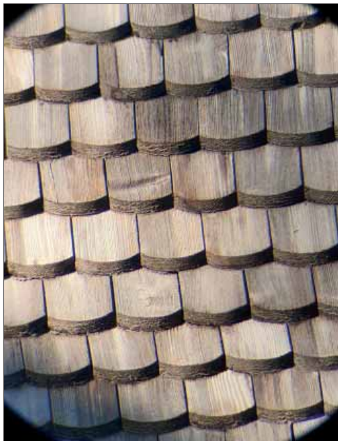
Sala sockenkyrka. På korsarmens nedre östra takfall ligger sågade spån. Virket är relativt fritt från kvistar, har stående årsringar och är överlag tätvuxet.
