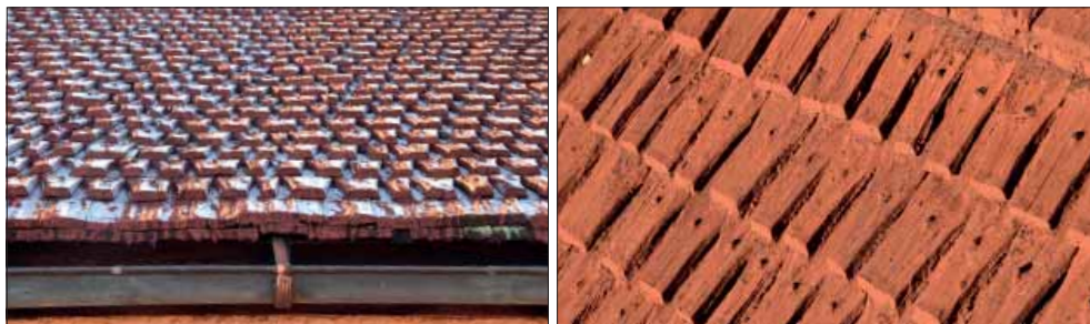
Figur 55. Spåntäckning med ett utskjutande fotskift av raka spån (t.v.). Spån på korets nedre takfall mot söder (t.h.). Deras näbbform skiljer sig från den spånen åt nordöst har. Foto Sanna Svensson.
