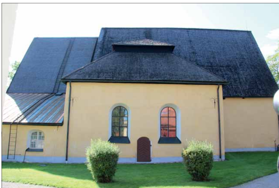
Sala sockenkyrka. Kyrkan sedd från norr. Sex olika spåntyper bedöms förekomma på olika takfall, fyra av dem har registrerats på korsarmens sex olika takfall. Långhusets och korsarmens spåntäckning uppvisar ojämnheter och rötskador.
