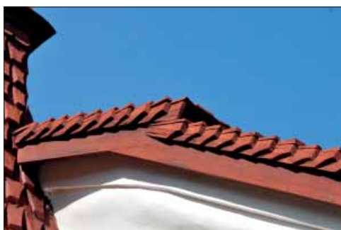
Djura kyrka. De särskilt utformade vindskivespån på kapellets samtliga gavlar.
