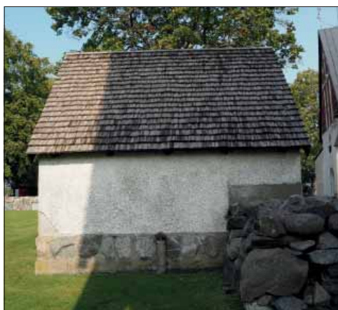
Hubbo kyrka. Bårhusets södra fasad.
