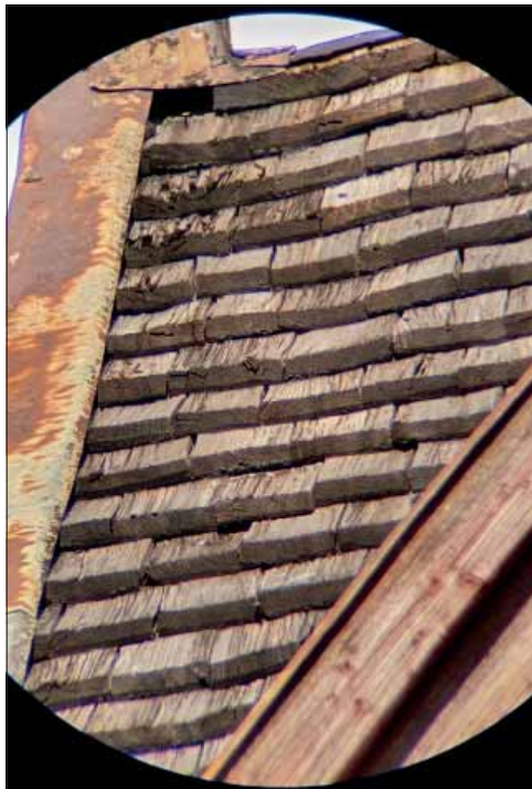
Möklinta klockstapel. Ett av klockstapelns övre takfall åt väster, foto från söder. Likadana spån som på kyrkans takfall.
