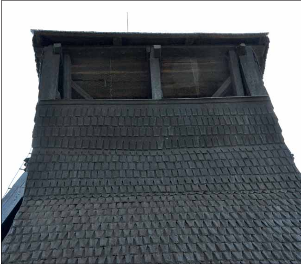
Torsångs klockstapel, nordfasaden. Spån på klockstapelns övre del. Mycket lika i form och bredd. Sitter därtill i mycket skyddat läge i och med klockkammarens lutning från fasaden.
