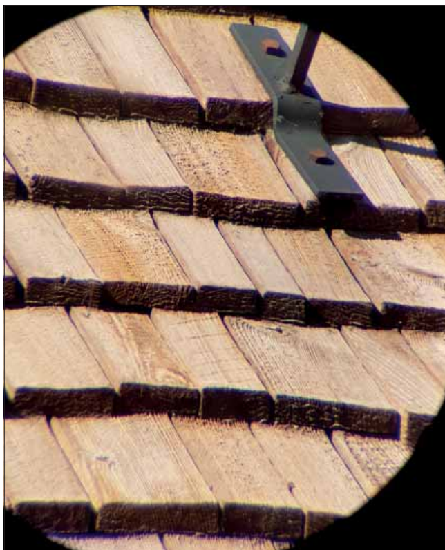
Vika kyrka. Närbild, sågade spån på södra takfallet.
