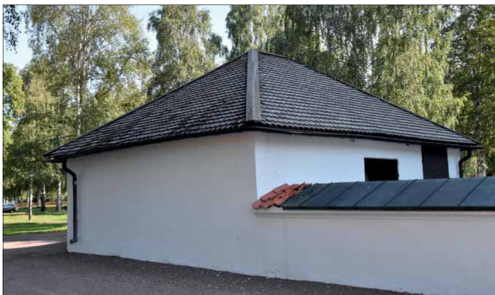
Orsa kyrka. Bisättningshuset från sydväst. Den södra takytan omlades på 2000-talet, medan det på västra takfallet förekommer partier av senare tillkomna lappningar.
