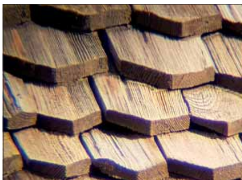
Orsa kyrka. Sågade, spetsformiga spån på långhusets södra takfall.
