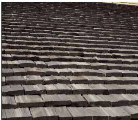
Kumla kyrka. Detalj av vapenhusets östra takfall.
