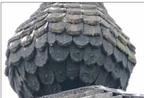
Tillberga kyrka. Närbild på äldre bevarade huggna spån på takdekorationens undersida, där finns även spår av röd nyans. Norra sticluckan.
