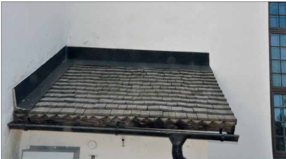
Vika kyrka. Entrétaket med sågade spån.
