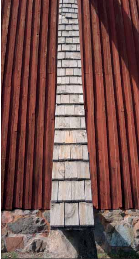
Aspeboda klockstapel. Sågade spån på den norra strävan.
