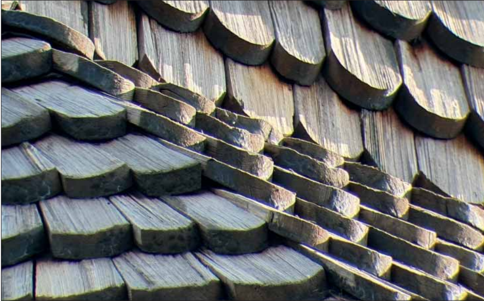
Medåkers kyrka. Kikarbild på tornkransen från sydväst, senaste omläggningen gjordes 1984.
