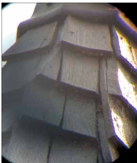
Kvarnsvedens klockstapel. Högre upp på spiran är spänen formhuggna i kanterna.
