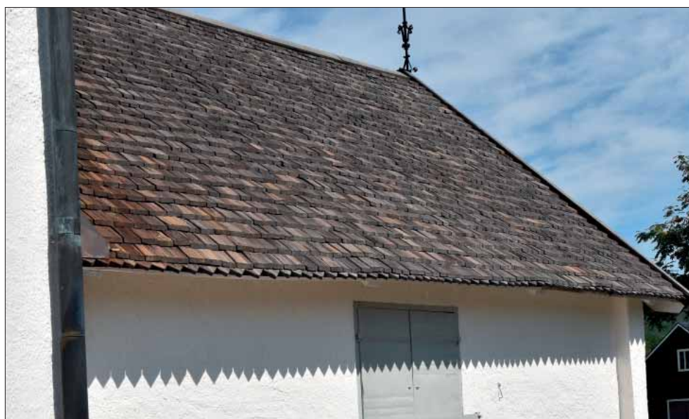
Äppelbo kyrka. På långhustaket och sakristian återfinns klyvda furuspån från omläggningar 1997, 2012 respektive 2015.
