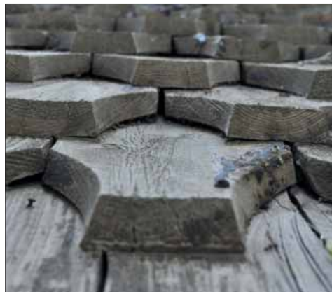
Gagnefs kyrka. Bårhusets sågade, näbbformade spån.
