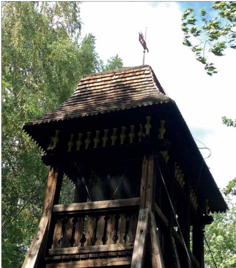
Vedevågs klockstapel. På den svängda huven ligger raka spån med fasad kant.
