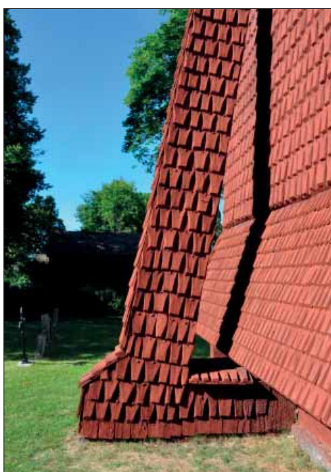
Djura kyrka. De särskilt utformade vindskivespån på kapellets samtliga gavlar.
