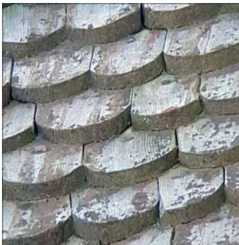
Rättviks kyrka. På kyrkans norra långhustak, närmast tornet, förekommer sågade runda spån. På äldre målningar framkommer att kyrkan tidigare haft runda spån på åtminstone koret och tornet. Kanske har den ursprungliga formen dröjt sig kvar på detta takfall? Även här finns rester av rödtjäräsödra korsarmen.
