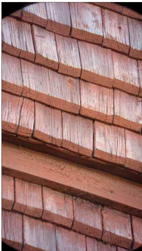
Möklinta klockstapel. Fasadspån på klockstapelns norrfasad med spår efter bearbetning med yxa.
