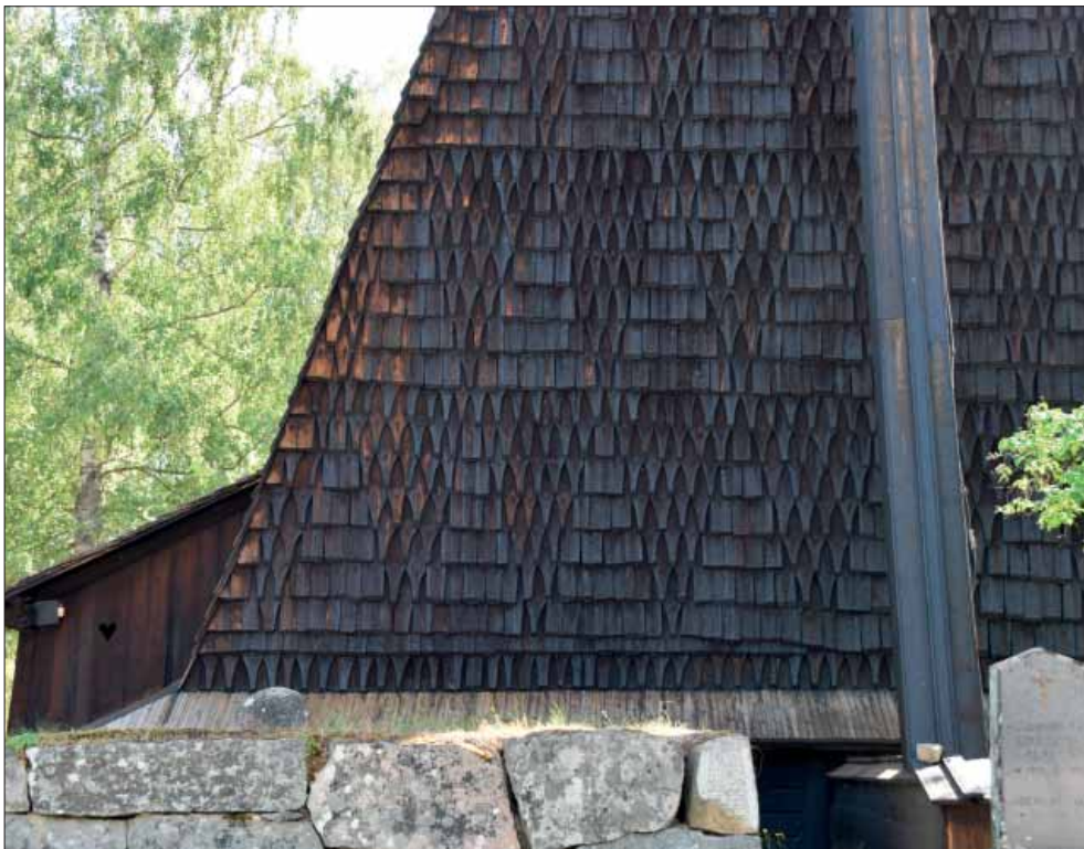
Leksands klockstapel. Klockstapelns fasader med triangelmönster om växelvis raka och näbbformade spån. Här syns västfasaden.
