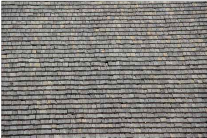
Säby kyrka. Spånen på kyrkans samtliga takfall är från en omläggning 2004–2005.
