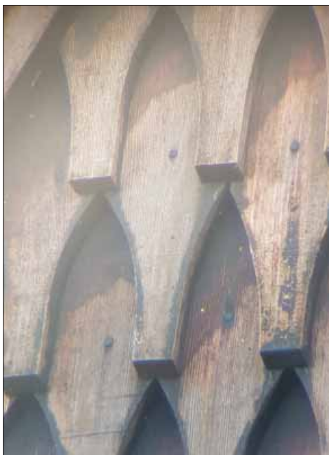
Evertsbergs klockstapel. De nåbbformade spånen är sågade och liksom övriga takfall infästa med synlig trädspik.
