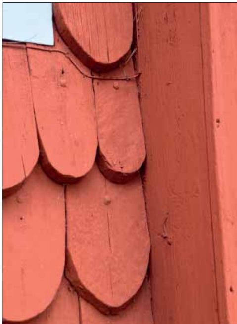
Envikens gamla kyrka Spån från omläggnigen 2015 på södra långhustfasaden med huggna bleken.
