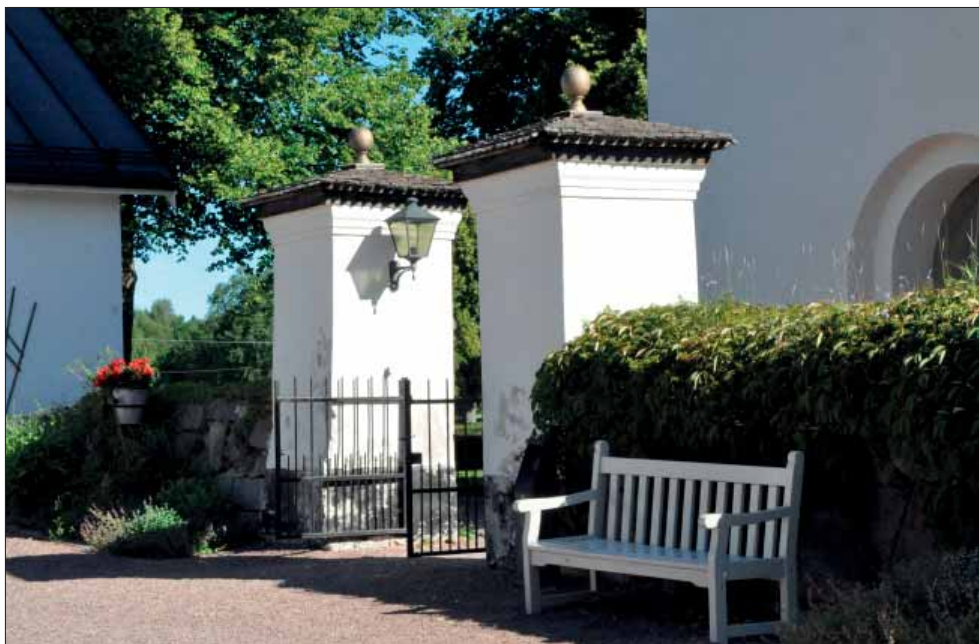
Dala-Floda kyrka. Grindstolpar avtäckta med spån.
