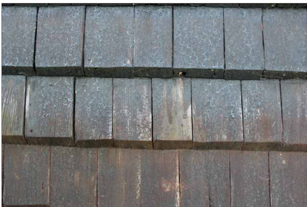
Möklinta klockstapel. Kreosotbehandlade spån på klockstapelns sockel, foto från norr.
