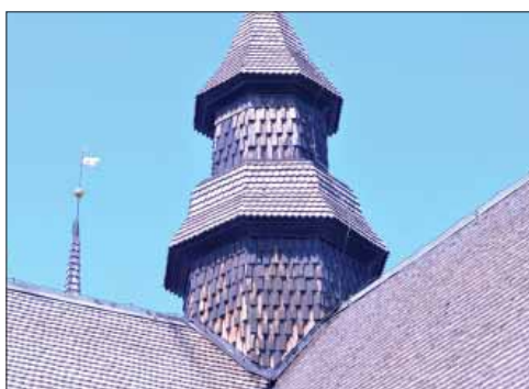
Ljusnarsbergs kyrka. Kyrkans takryttare sedd från sydost.
