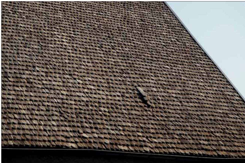
Kärro kyrka. Långhusets södra takfall med lösa spån.
