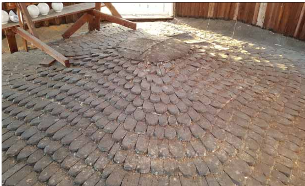
Figur 23. Hedemora kyrka, Västerås stift. Flackt spåntak med inskott av näver mellan spånskiften. Takytan är idag inbyggd och utgör golv i tornets lanternin. Spåntäckningen tillkom innan 1773 då lanterninen byggdes efter ritningar från 1750 av Carl Hårleman. Foto Lisa Skanser.
