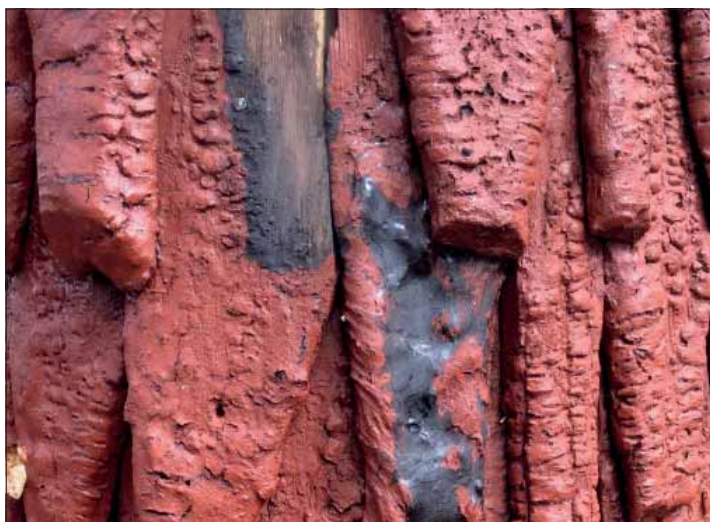
Figur 40. Husby-Oppunda klockstapel, Strängnäs stift. Hjärtstolparnas spån är täckta med tjocka skikt ytbehandling. Foto Karin Myhrberg.
