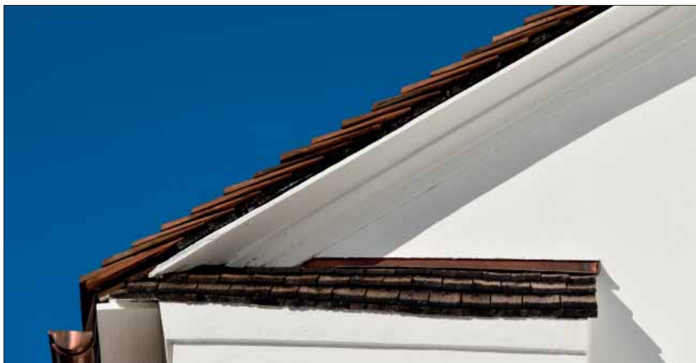
Boda kyrka. Klivna spån på västra långhustakfallet och äldre spåntäckning på södra gavelgesimsen, foto från södra gaveln.
