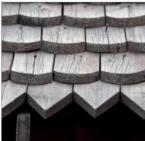
Evertsbergs kapell och klockstapel. Spånen på kapellets och stapelns takfall är genomgående rundformade med lika dimensioner.
