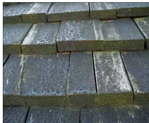
Rytterne bårhus, norra takfallet.
