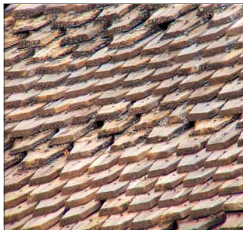
Ore kyrka. På långhuset förekommer framför allt två typer av spån. På denna bild är båda typerna tydligt urskiljbara. En sågad typ, ljusare, troligen tillkommen vid omläggningen 1962. I partier intill ligger en spåntyp med äldre tjärklumpar. Kanske utgör de ursprungliga spån från 1870-talet, eller så har de tillkommit under 1900-talets första del.
