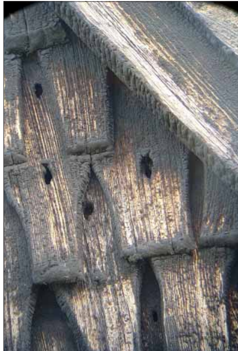
Kung Karls klockstapel. Kikarbild på östra fasadens spån. Hål från tidigare infästning är synliga.
