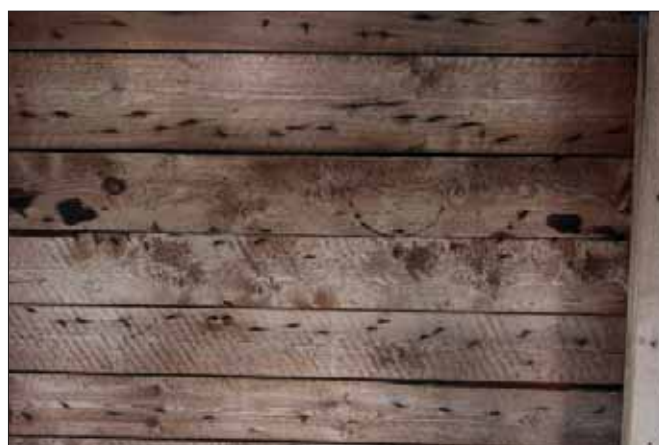
Undertak i klockhuv, två generationer spånsplik. Foto: Lisa Skanser.
