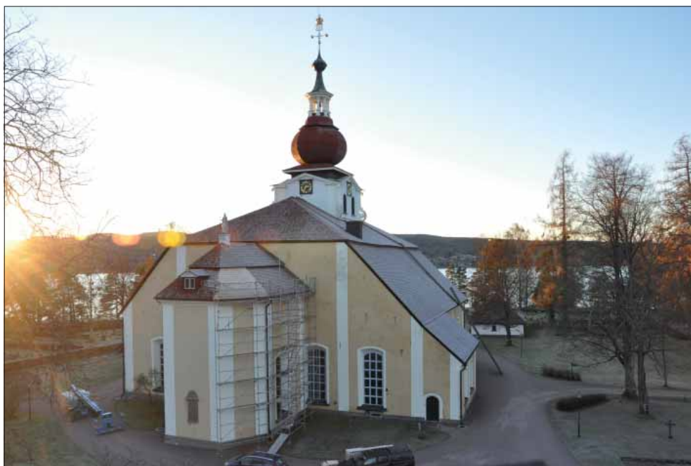
Figur 47. Leksands kyrka. På korets norra sida är en byggnadsställning rest. Bilden är tagen från klockstapeln 2018-11-22. Foto Lars Jönses.
