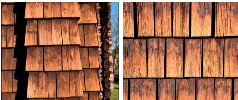
Åsens kapell. Närbild på sågade fasadspån. Spånen har delvis liggande årsringar
