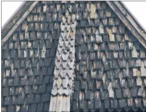
Kung Karls klockstapel. Spån på klockhuvens västra fasad, strävans övre del är klädd med yngre kluvna spån.
