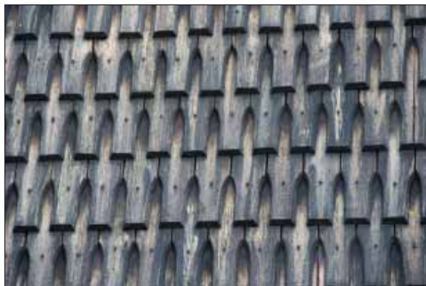
Svedvi klockstapel, sågade spån på östra fasaden.
