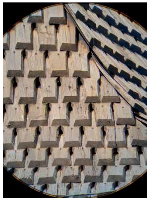
Kungs-Barkarö kyrka. Torntaket takfall åt söder och öster, mycket liggande årsringar.
