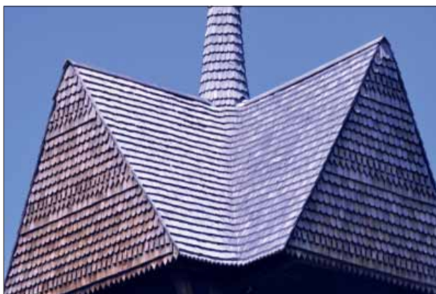
Figur 5. Huv på Kräcklinge klockstapel, Strängnäs stift. Spiran och huvens takfall definieras som tak medan huvens vertikala partier definieras som fasader. Foto Daniel Eriksson.
