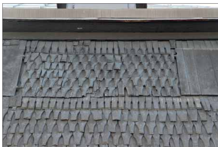
Svedvi klockstapel. Högst upp på norra fasaden i nivå med ljudluckorna finns ett extra intressant parti med olika spån. De näbbformade spånen i jämna dimensioner bedöms ha en högre ålder jämfört med övriga näbbformade spån på norra och västra fasadern. Mellan ljudluckorna och i liv med deras underkant löper ett skift med raka spån som har fasningen inåt. Detta skift kan berätta om en tidigare utformning av stapelns exteriör men en mer noggrann undersökning skulle behöva göras.
