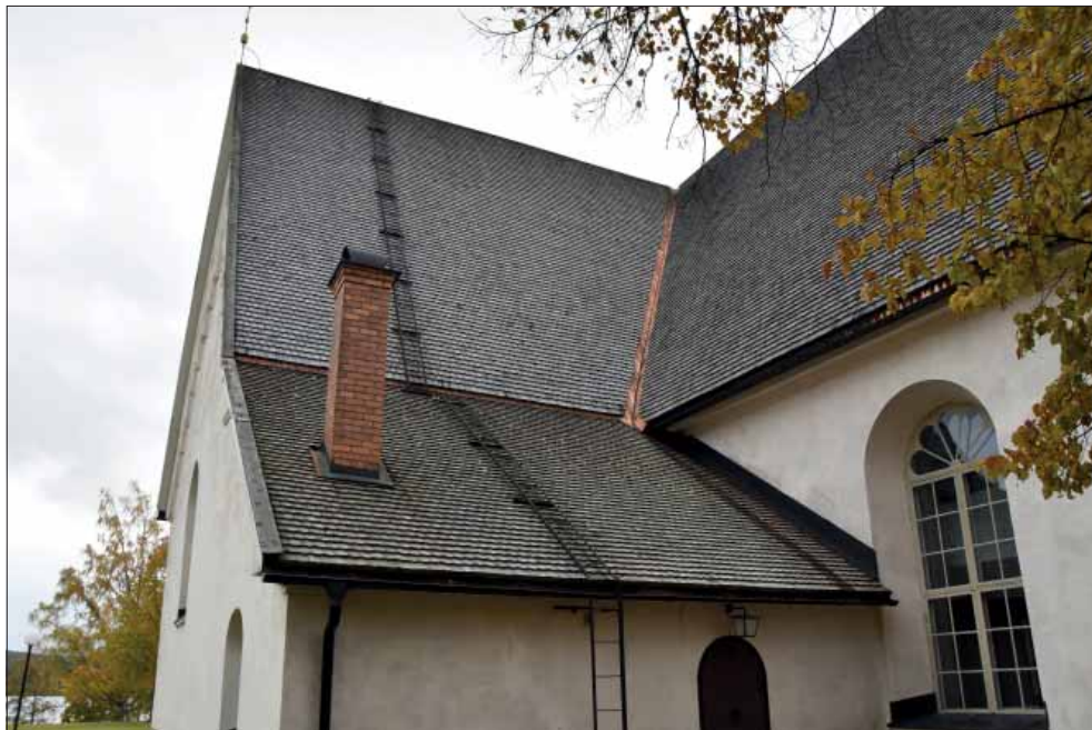
Svärdsjö kyrka. Takfallen sedda från nordost. Notera de olika lutningarna på takfallen samt kopparplåten i ränndalarna.
