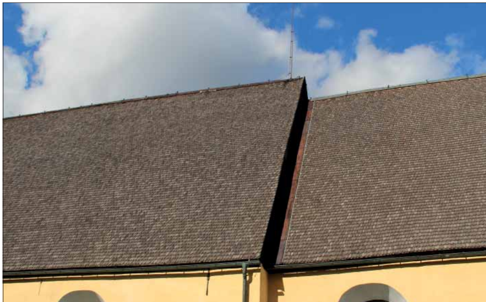
Sala sockenkyrka. På långhusets och korets takfall mot söder ligger klivna spån uppskattningsvis lagda kring 2000.
