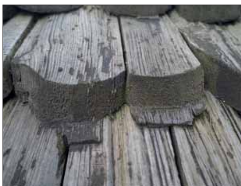
Hovdestalunds begravningsplats. Grindstolpe 1 i söder. Spånens bas har inte sågats ordentligt.
