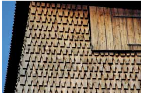
Malma kyrka. Övre delen av tornfasaden mot söder.
