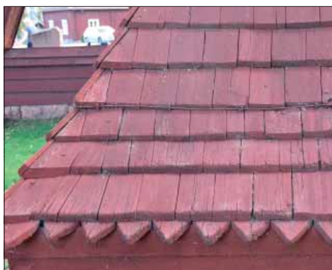
Mora klockstapel. Detalj av nordsidans nedre fasad. Spånen har rak kant och täckningen och avslutas nedtill av spetsspån.
