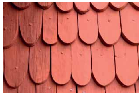
Envikens gamla kyrka Spån från omläggnigen 2015 på södra långhustfasaden med huggna bleken.
