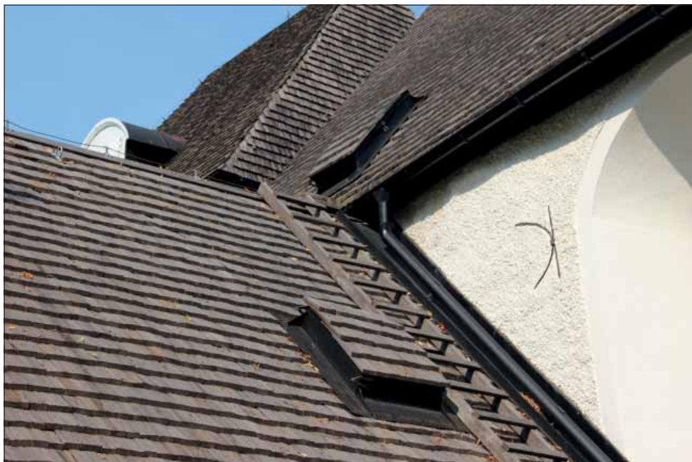
Säby kyrka. Takluckorna av plåt på vapenhus och långhus har täckts med spån, foto från sydöst.
