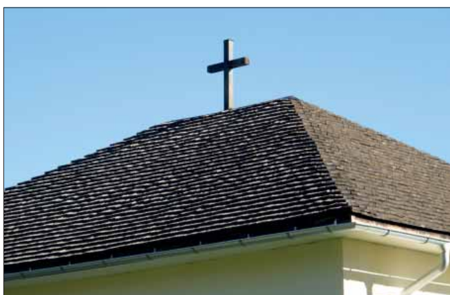
Boda kyrka. Klivna spån på västra långhustakfallet och äldre spåntäckning på södra gavelgesimsen, foto från södra gaveln.
