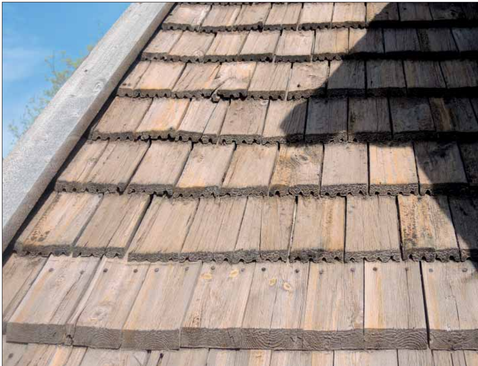
Aspeboda klockstapel. Sågade spån med spårfräst undersida från omläggningen 2013.
