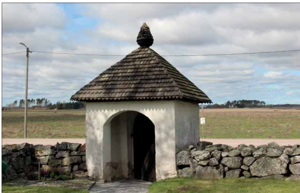
Tillberga kyrka. Västra stigluckan är den äldsta. Spånen på takfallen lades troligen 1982.
