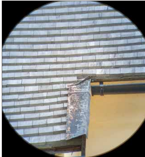
Möklinta kyrka. Sakristian span, eventuellt från 1982 och behandlade med kreosot.
