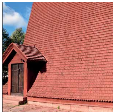
Mora klockstapel. Sydfasaden med spåntäckt entrétak.
