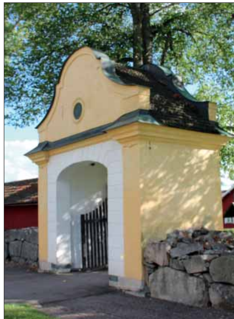
Sala sockenkyrka. Stigluckornas tak är täckta med kluvna rundade spån från omkring år 2000. Bilden visar södra stigluckan.
