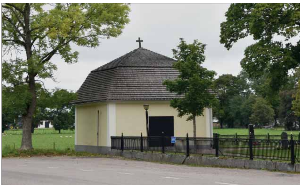
Folkärna kyrka. Två bårhus från 1700-talets slut markerar varsitt hörn på kyrkogården. Taken har en bruten form och själva brytningen i takfallen markeras av spetsspån. Bilden visar det norra bårhuset.
