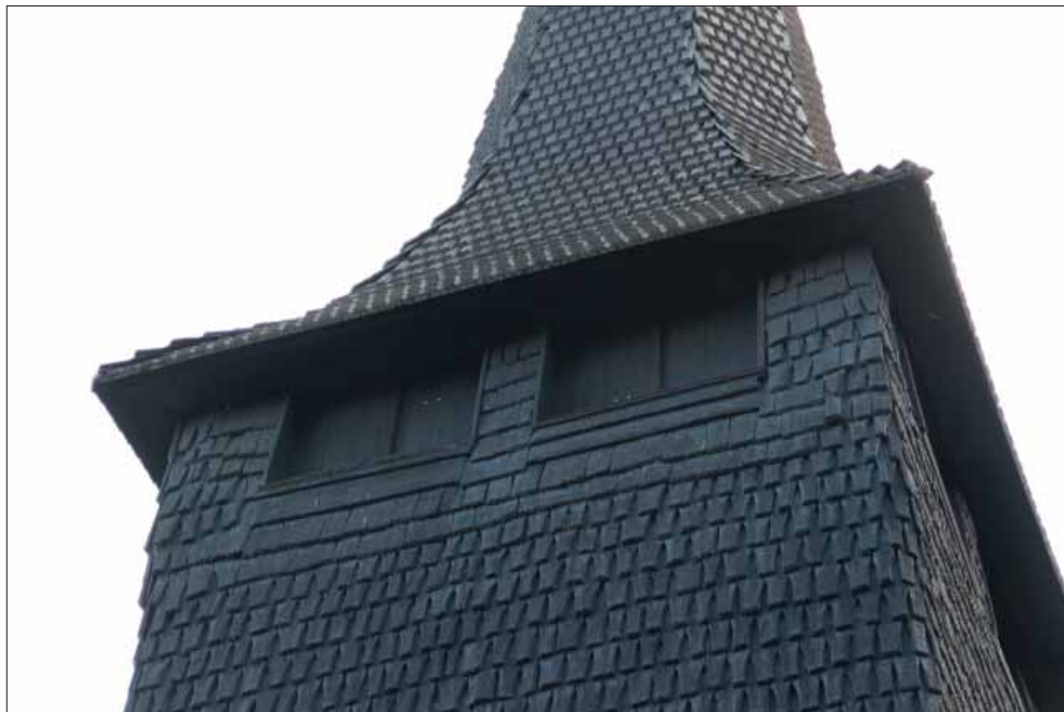
Kungs-Barkarö kyrka. Tornets övre fasad från sydväst. Kring ljudluckorna sitter spån med rak bas. Tornet spånslogs av ryttaren Petter Forsberg år 1784. Spikhål i flera spån tyder på återanvändning så möjligen finns äldre spån.
