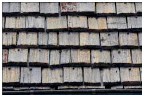
Malungs kyrka. Södra korsarmens spån har stående årsringar och synlig spikning.
