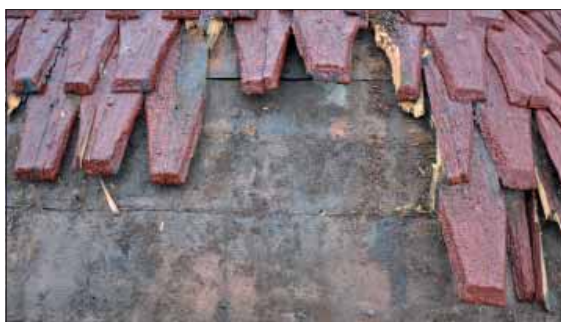
Figur 52. Undertaksbrädorna på takfallen i nordöst visar endast en generation spånspik. Foto Lars Jönnes.
