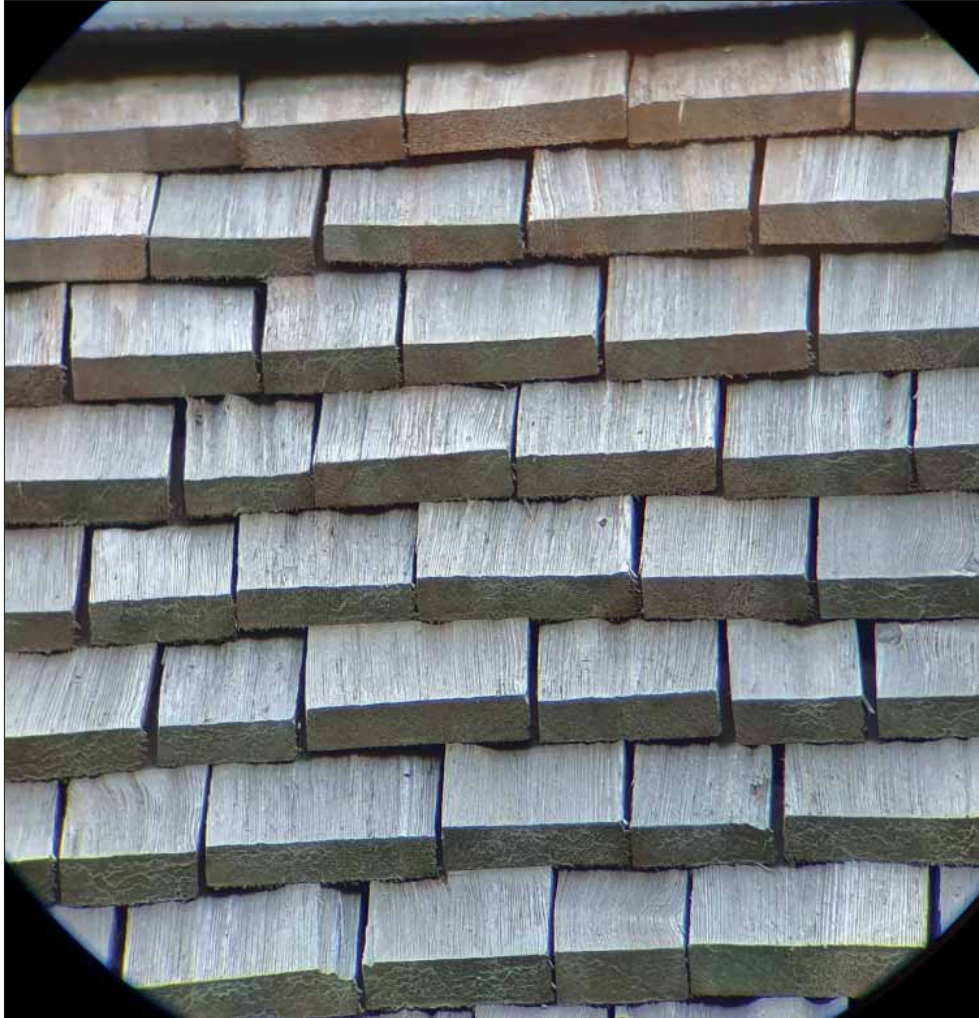
Sala sockenkyrka. Spänen på korets norra takfall lades om i sin helhet 2010. Spänen har klyvd ovsida och rak bas.
