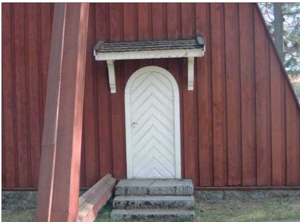
Kvarnsvedens klockstapel. Skärmtaket över entrén med nyare, sågade spån.
