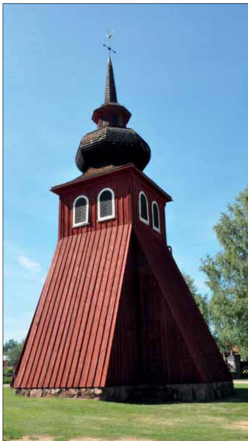
Amsbergs klockstapel. Spåntäckt tak med lökkupol och spira på klockstapel.
