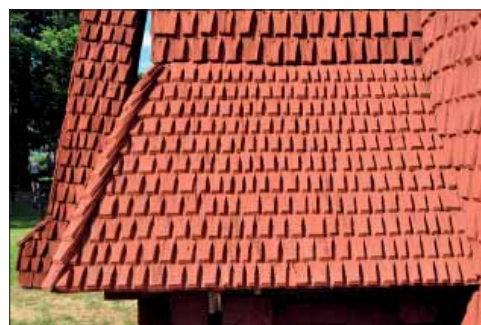
Djura klockstapel. Klyvda spån på tornkransen från omläggningen 1996–1997.
