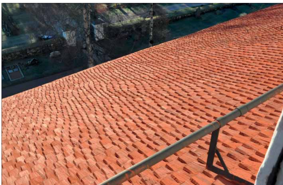
Leksands kyrka. Långhusets södra takfall. I samband med en stor takomläggning 1996 utbyttes spånen på långhusets hela södra takfall, ovensidan på löken samt den därunder liggande tornhuven.
