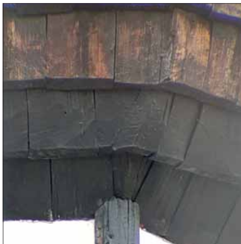
Bingsjö kapell. De sågade spänen på långhus och sakristia är vända "upp-och-ner".
