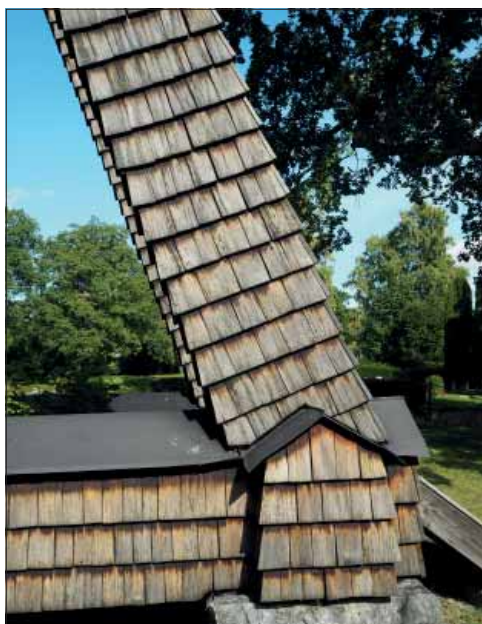
Hovdestalunds klockstapel. Del av klockstapelns syll och strävpelare.
