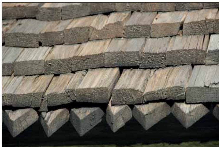
Bergs kyrka, bårhus. Närbild västra takfoten.
