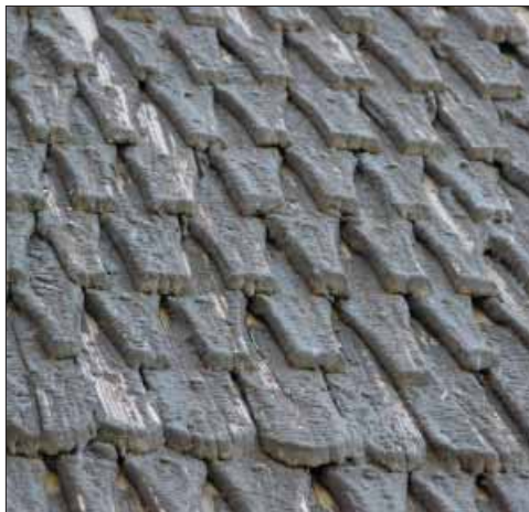
Sala sockenkyrka. På vapenhusets västra takfall ligger huggna näbb- och rundformade spån i mönstertäckning. Taktäckningen är en av de äldsta i Västerås stift och kan vara 1600–1700-tal. Takspån av så hög ålder är unikt.
