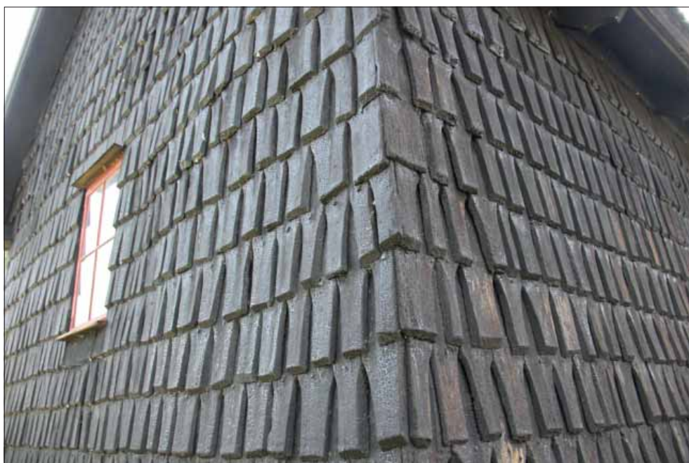
Sura gamla kyrka. Norra och västra fasaderna med äldre bevarade spån, eventuellt från 1600-talet.
