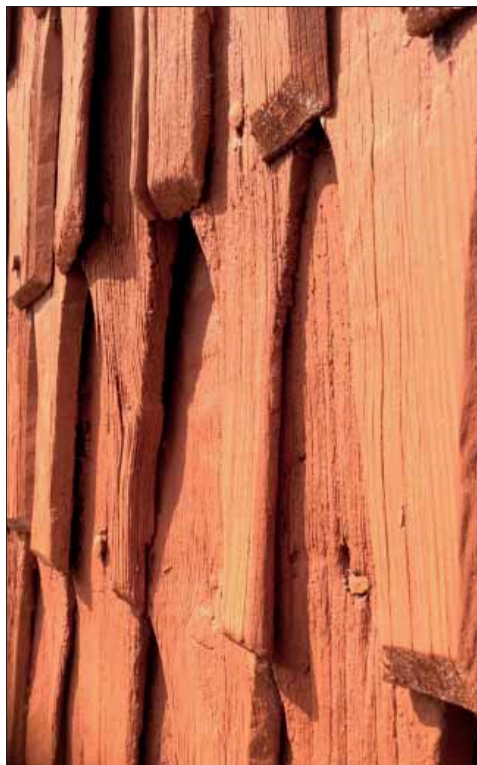
Hällefors kyrka. Vissa spån har eroderat och blivit mycket tunna.
