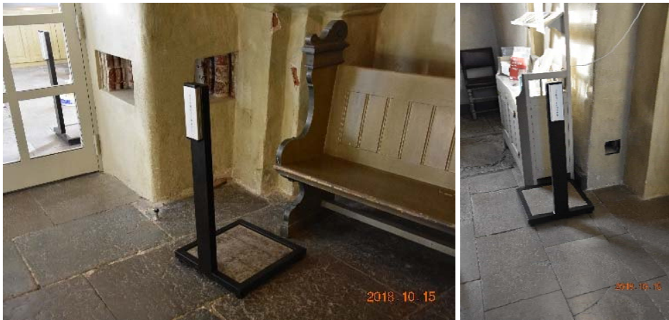
Figur 22 och 23. Armbågskontaktarna har placerats på stolpar för att inte göra åverkan på väggpartierna.
