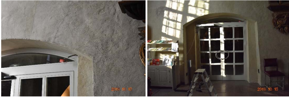
Figur 20. Ny eldrugning till bland annat dörröppnare har kunnat förläggas i den nya karmen. Figur 21. Dörrpartiet sett från långhuset.
