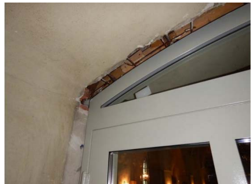
Figur 16. Glipa över nytt dörrparti som senare drevats och putsats igen.
