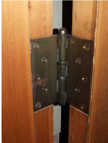
Figur 14. Gångjärn på befintlig dörr.
