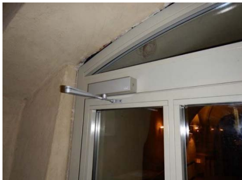
Figur 16. Glipa över nytt dörrparti som senare drevats och putsats igen.
