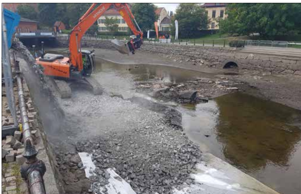
Figur 6. En arbetsväg skapas nere på Svartåns botten inför anläggandet av den nya faunapassagen. Resterna efter dammvallen A1 syns höger om grävmaskinen. Foto från nordöst.
