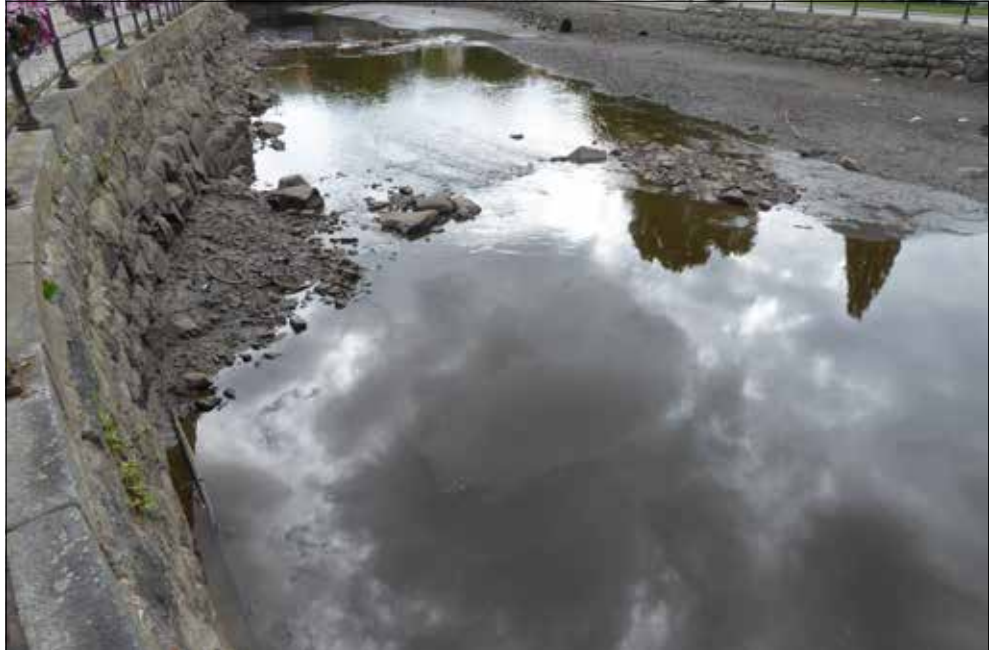
Figur 14. Resterna efter en äldre dammvall (A2) synliga norr om A1. Foto från norr av Duncan Alexander.
