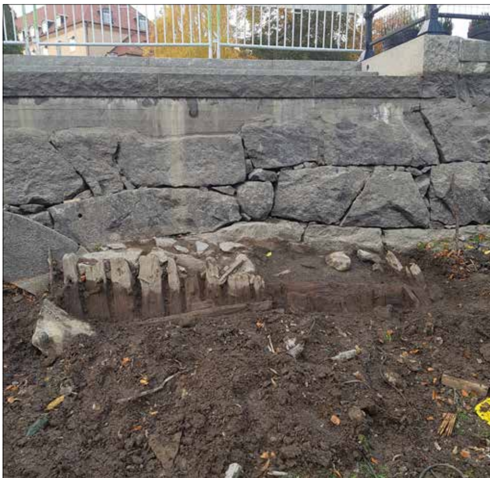
Figur 16. Närbild på A3, sten- och träkonstruktion norr om inflödesporten till Wickholms kvarn. Foto från öster.
