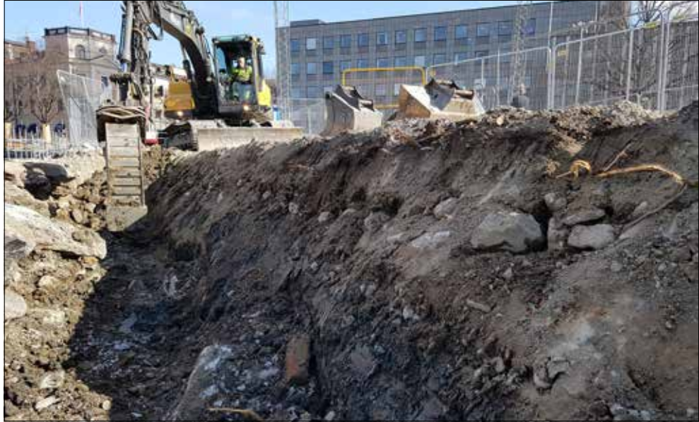
Figur 19. Schaktning för schakt 3 längs med Fiskartorget. I schaktväggen går det att urskilja den stenlagda yta som sannolikt täckt hela Fiskartorget vid någon tidpunkt. Ovanför schaktväggen och till höger om grävmaskinen syns Stadsbuset. Foto från sydväst av Jonas Ros.
