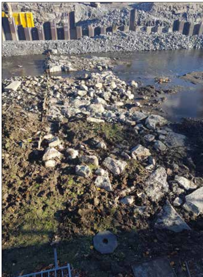
Figur 11. Dammvallen A1 sedd från Stadsparken i väster. Här har östra sidan av dammvallen tagits bort och anläggandet av faunapassagen påbörjats. Träkonstruktionen med stående brädor är synlig längs med dammvallens norra sida (till vänster i bild).
