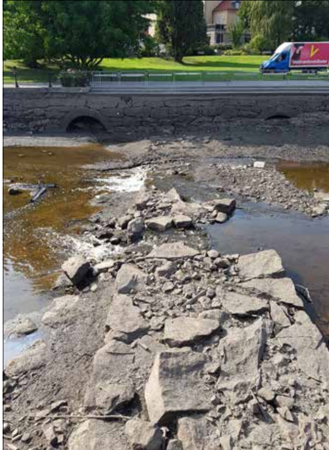
Figur 10. Dammvallen A1 efter Wickholms kvarn sedd från Fiskartorget i öster. Den lummiga gräsmattan i bakgrunden är en del av Stadsparken. Inflödet till kvarnen syns som ett valv till höger om dammvallen, och utflödet är väl synligt på andra sidan.
