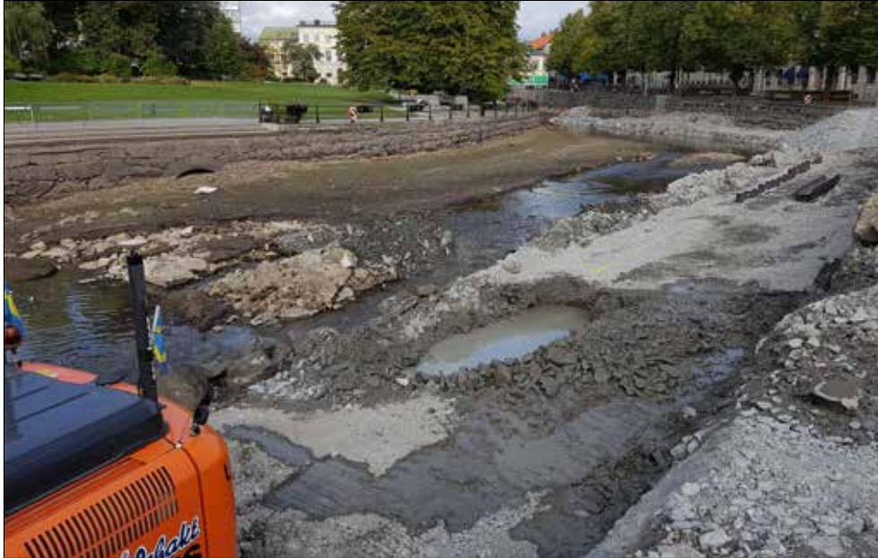
Figur 12. Genom de påförda grusmassorna för arbetsvägen grävdes djupare schakt för att underlätta för spontningen. I det vattenfyllda hålet mitt i grusvägen framkom trästockar i två skikt. Foto från sydöst av Jonas Ros.
