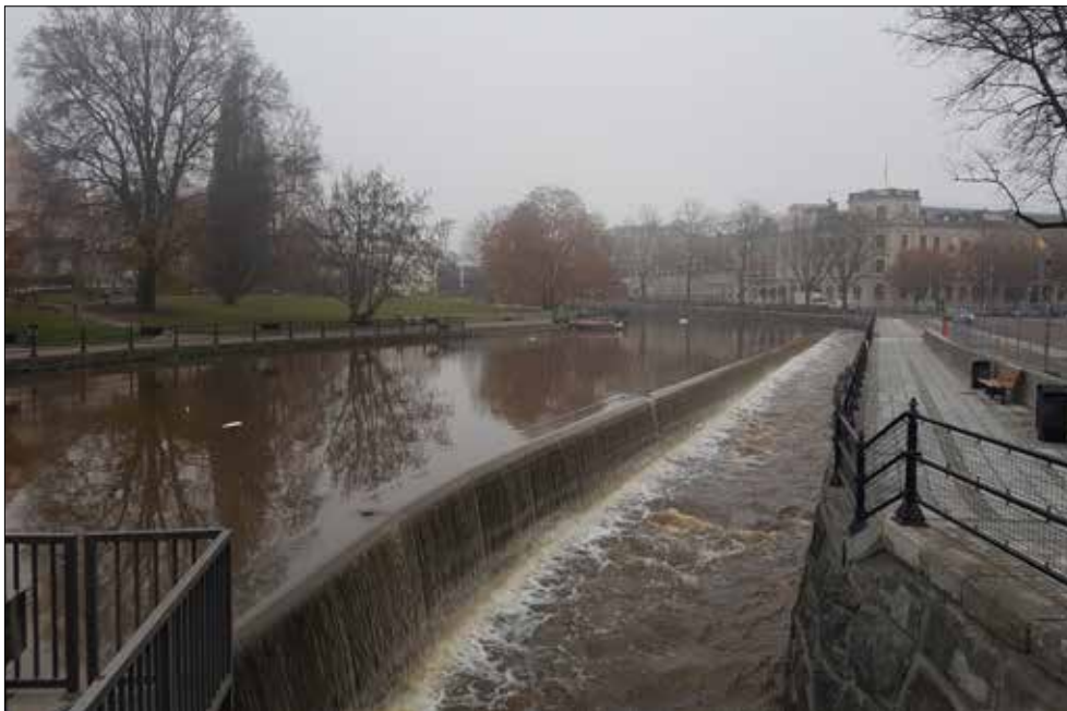
Figur 26. Faunapassagen efter färdigställande. Vy från Turbinbron.
