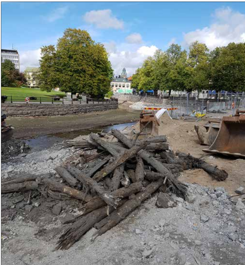
Figur 13. Trästockarna från botten av Svartån. Sannolikt har de utgjort en rustbädd för dammen som byggdes i anslutning till Wickbolms kvarn. Foto Jonas Ros.
