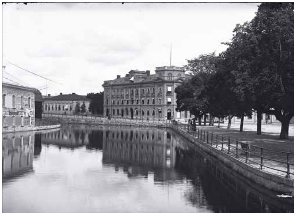
Figur 23. Svartån sedd från söder, 1890-tal. Till vänster syns Wickholms kvarn. Kvarndammen har dock ersatts av dammen vid Turbinbron. Stenskoningen på östra sidan (till höger i bild) är här nyrestaurerad och utrustad med samma gjutjärnstaket som fortfarande används. Utloppet till Lillån har murats igen. Bildkälla Västmanlands läns museum, fotograf Ernst Blom.
