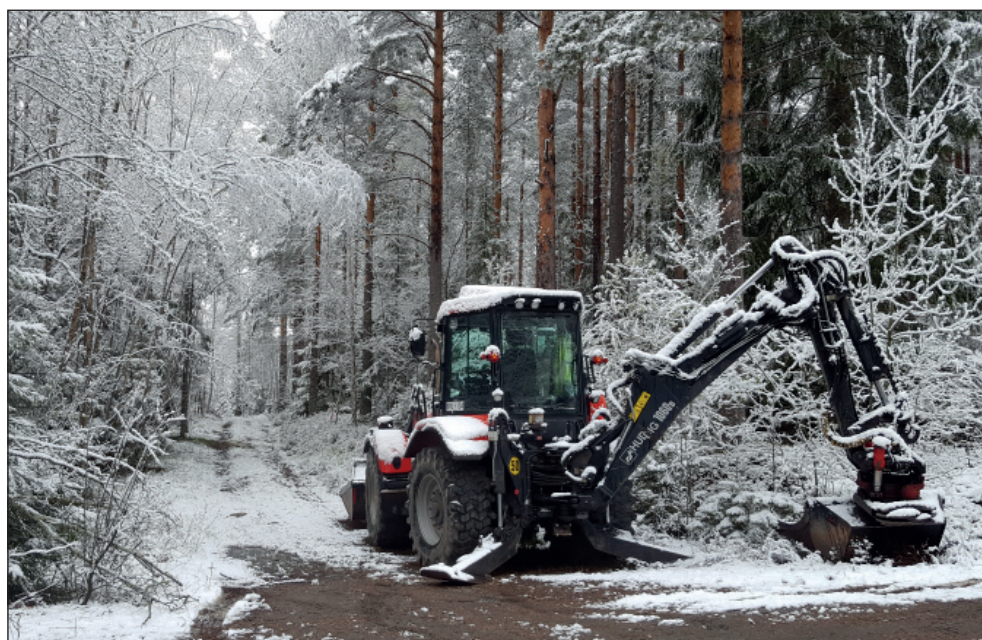
Figur 3. Snö i maj, vid objekt 8, sett från öster.
