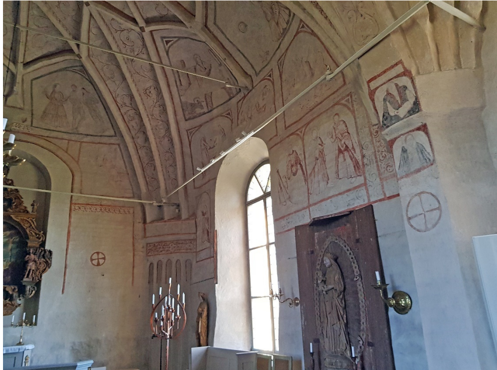
Figur 13. Sydvästra hörnet. Nya spotlights på dragstag. Stående golvlampor borta.
