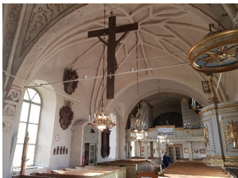
Figur 3. Befintlig spotlightskena på dragstag före åtgärder.
