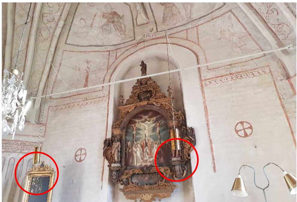
Figur 9. Inringade armaturer har fått ny el. i bildens nedre, högra hörn syns en av de två golvlampor som tidigare användes för belysning av kören.
