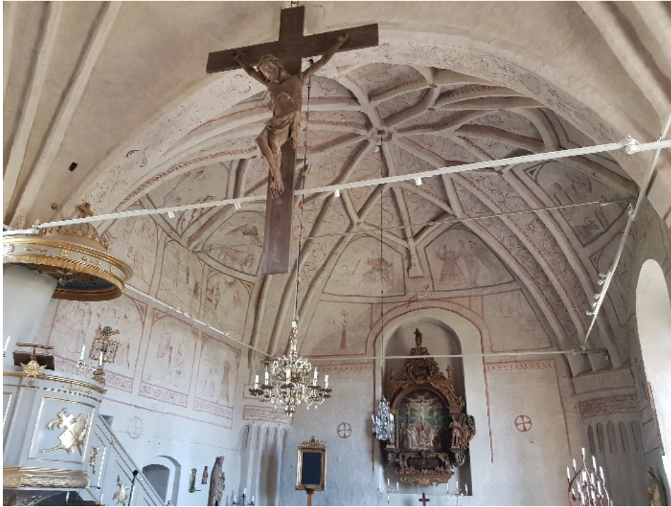
Figur 10. nya spotlights monterade.
