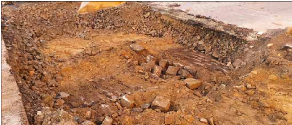
Figur 5. Sentida gata av storgatsten på norra delen av schaktet. Foto från nordöst.
