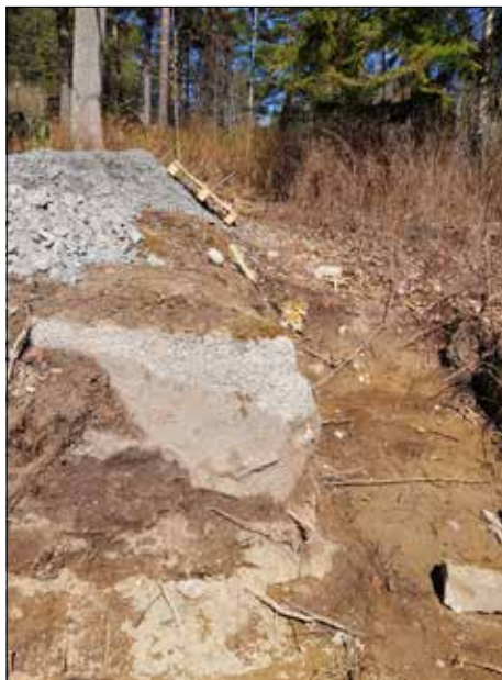
Figur 6. Schakt S233 från sydväst. Påförda fyllmassor samt del av husgrund och det gulbruna fyndförande sandiga siltlagret synligt i botten på schaktet.
