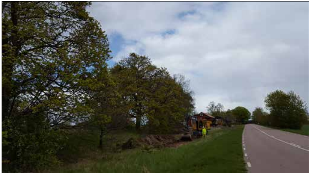
Figur 11. Östra delen av förundersökningsområdet och den gamla landsvägen. Foto från söder av Maud Emanuelsson.
