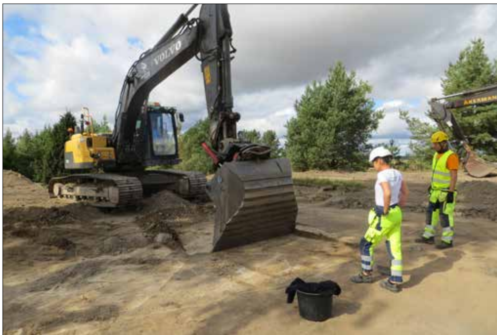
Figur 12. Schaktning av förundersökningsområdet med Michael Schneider och Ingela Harrysson samt maskinist Erik Gustavsson. Foto från nordöst av Reidar Magnusson.
