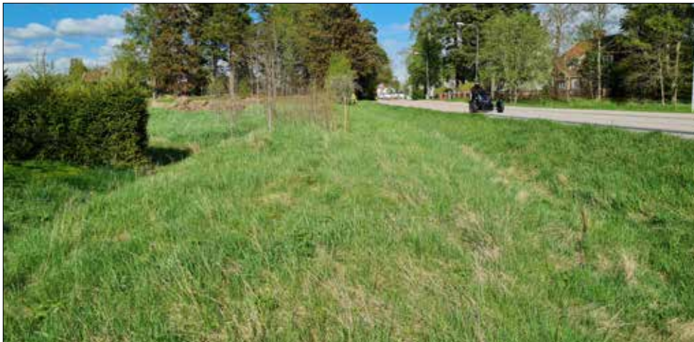
Figur 9. Vägbank. Foto från sydväst.
