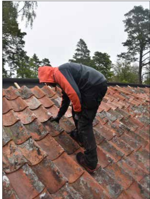
Figur 23. Christian i arbete. Att återbruka äldre lertegel är som att lägga ett pussel. Vissa takpannor är svarare att finna en bra placering för.
