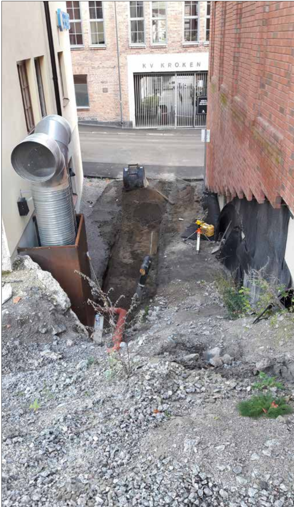
Figur 4. Översikt över östra delen av schakt 1 från väster. I bakgrunden syns Garvaregatan.
