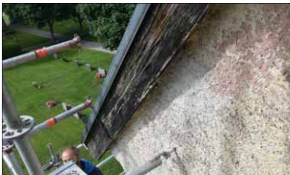
Figur 28. Takfotsbräda, östra gaveln. Uttorkad men i övrigt i bra skick, brädan bevaras och målas.
