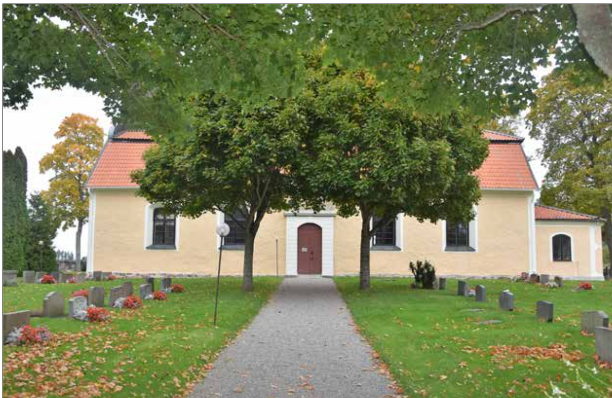
Figur 38. Slutbesiktning, september 2021. Södra fasaden.
