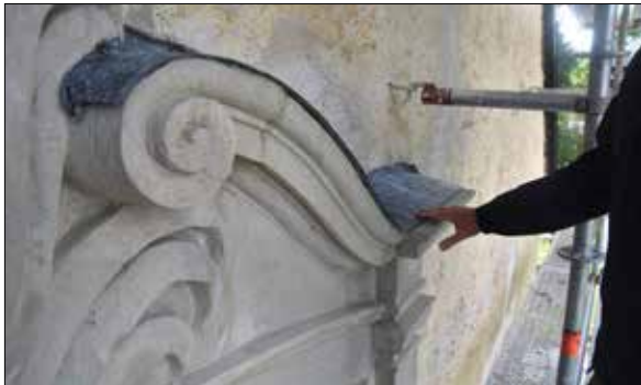
Figur 35. Detalj av stenarbetet, västra gaveln. Nästan klart i augusti 2021. Plåtarbetet överstämde inte riktigt med ritning över utförande.
