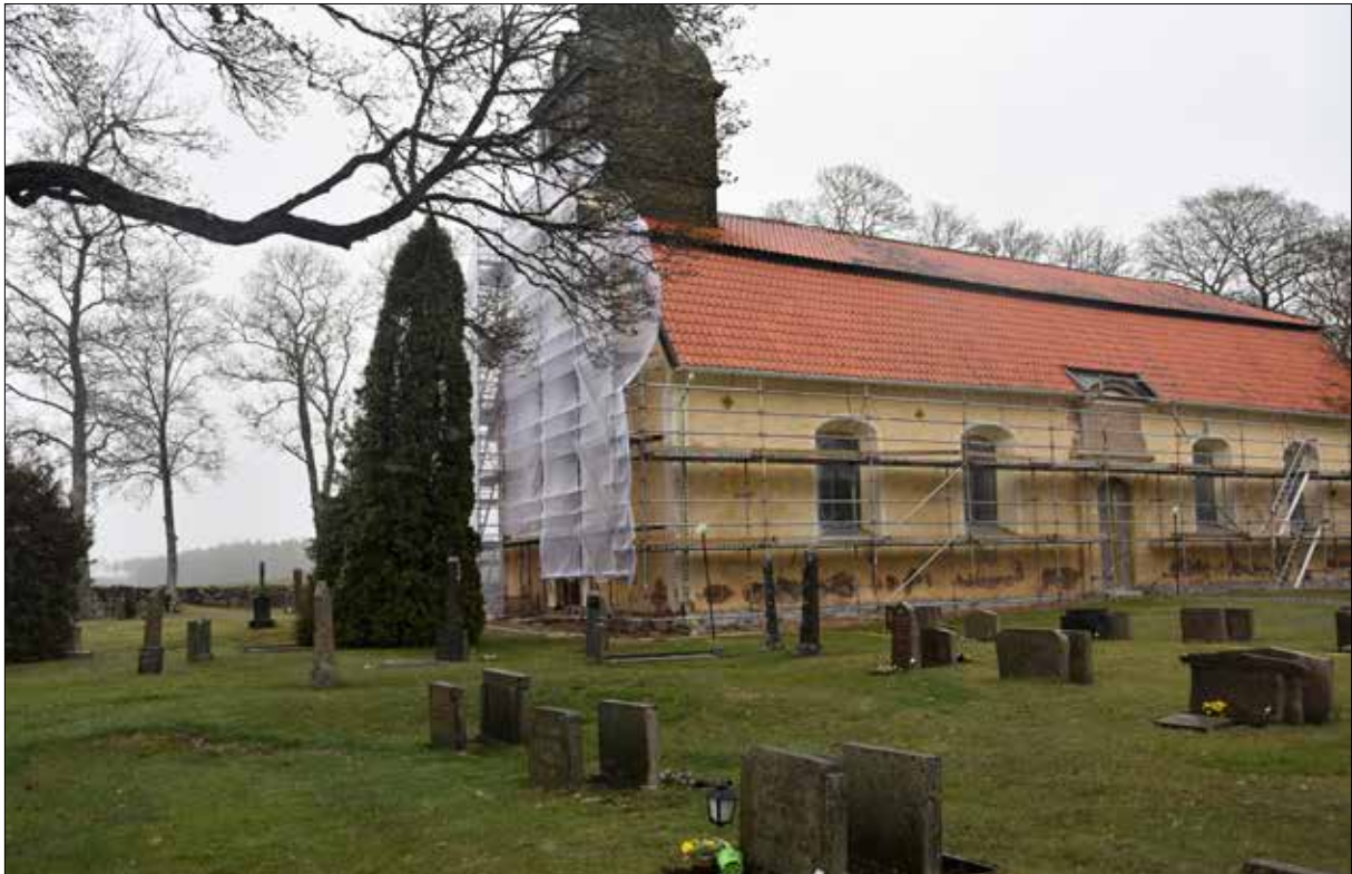
Figur 20. Ställning på plats, april 2021.
