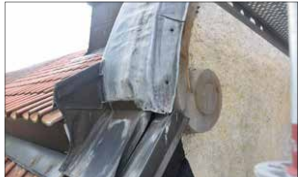
Figur 27. Detalj av blyplåt, västra gaveln.
