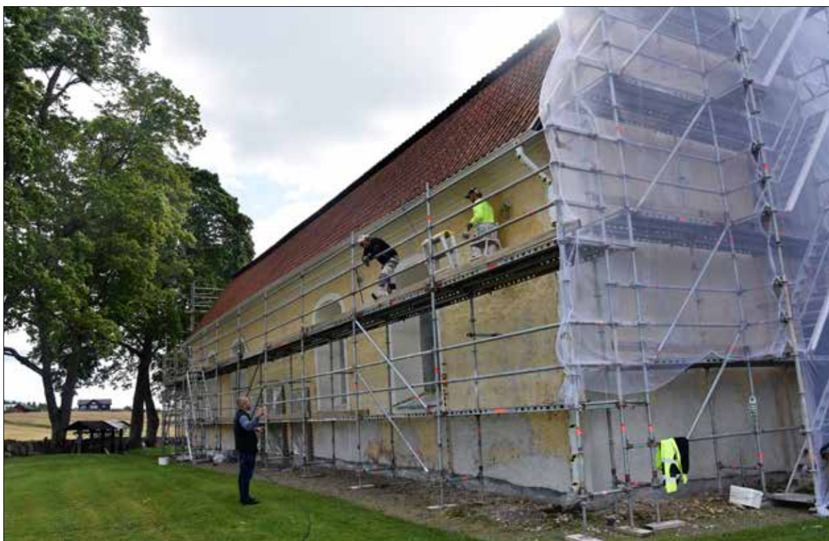
Figur 30. Norra sidan och västra gaveln, putslagning pågår, augusti 2021.
