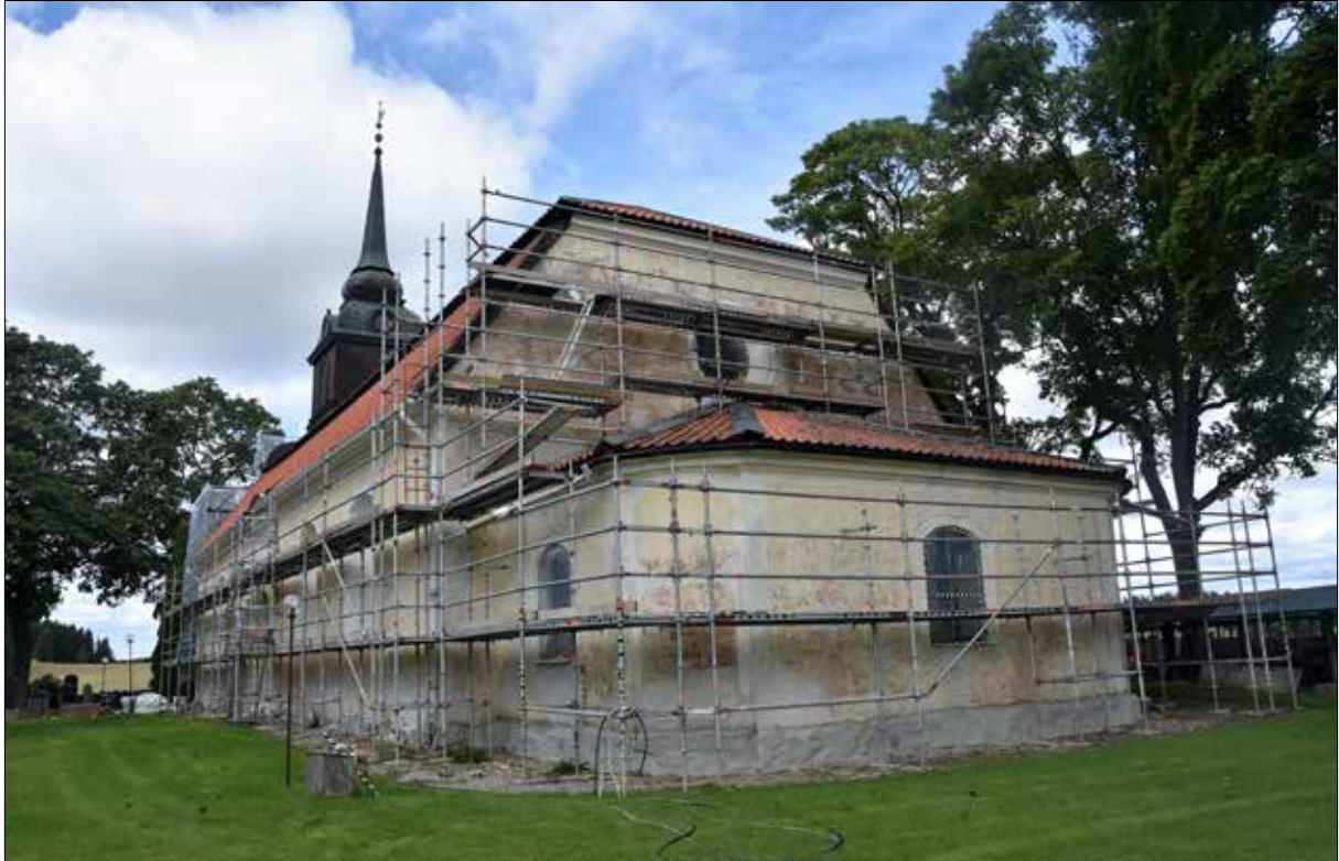
Figur 32. Södra fasaden, östra gaveln, augusti 2021.
