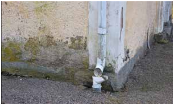
Figur 10. Nordvästra hörnet före renovering i mars 2021.
