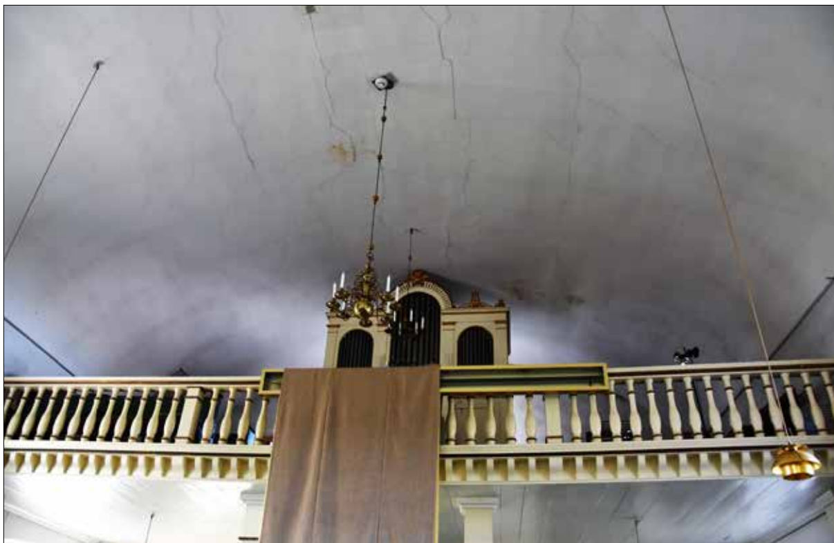
Figur 14. Läktaren med balusterräcke innan förstärkning görs med dragstag. Startmöte i mars 2021.
