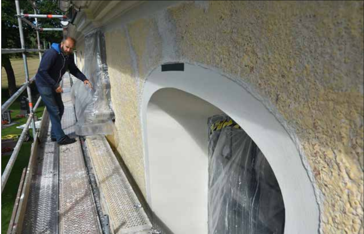
Figur 34. Konservator Gabor ser till att stenarbetet över södra entrén är ordentligt inplastat inför avfärgning av fasader.
