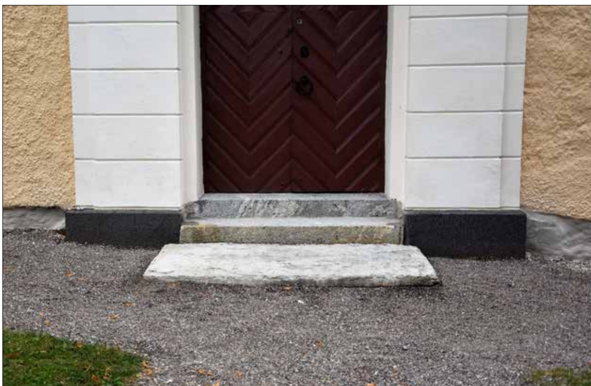
Figur 39. Västra entrén, jämför med figur 4. Trappan har kompletterats med ny sten. Putsockel har ersatts av stensockel. Se också fasad och putsad dörrumfättning, vilken skällnad!
