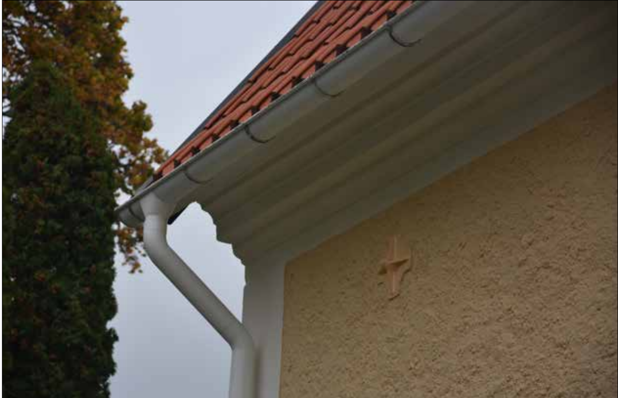
Figur 49. Detalj av dragtagsplatta, takfot och stuprör. Efter målning i kulör NCS S 1020-Y30R är dragtagsplattorna knappt synliga.
