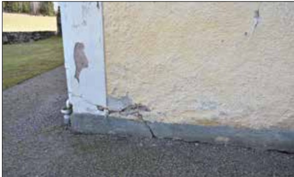
Figur 8. Sydvästra hörnet före renovering.
