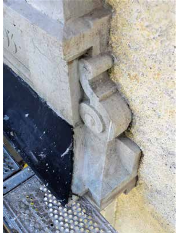
Figur 25. Detalj av sten med plättäckning, västra gaveln.
