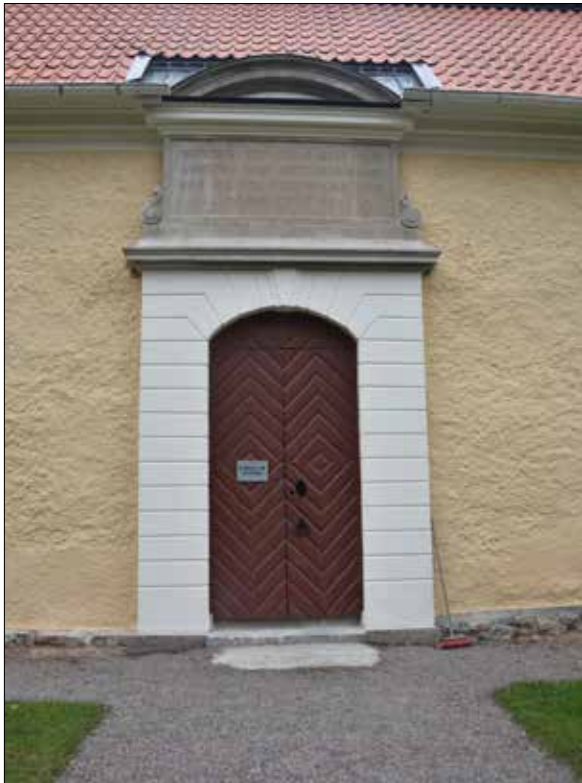
Figur 41. Södra entrén efter renovering.
