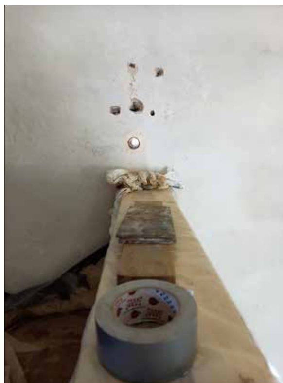
Figur 16. Håltagning genomförd i kyrkans murverk, inför placering av dragstag. Norra väggen i närbild. Foto Håkan Pettersson, Byggcenter Bygg & Service AB.
