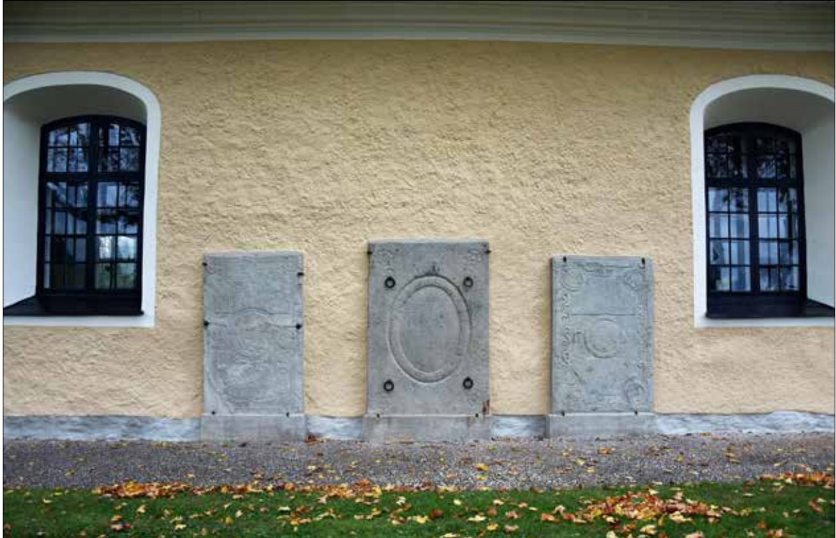
Figur 40. Norra fasaden, jämför med figur 5. Gravbällar har tvättats rena från alger. Kramlor har skrapats rena från rost och målning behandlats med blymönja och svart linoljafärg. Lägg märke till fasad, sockel och takfot. Fönstersnickerier har ojats in, vilket bidrar till ett fint helhetsintryck.
