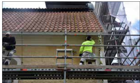
Figur 29. Målning av takfot, norra fasaden i augusti 2021.
