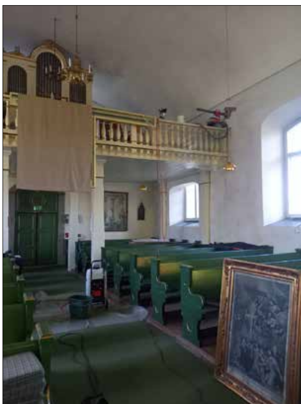
Figur 15. Ovan läktaren pågår håltagning i befintlig mur, norra sidan. Foto Håkan Pettersson, Byggcenter Bygg & Service AB.
