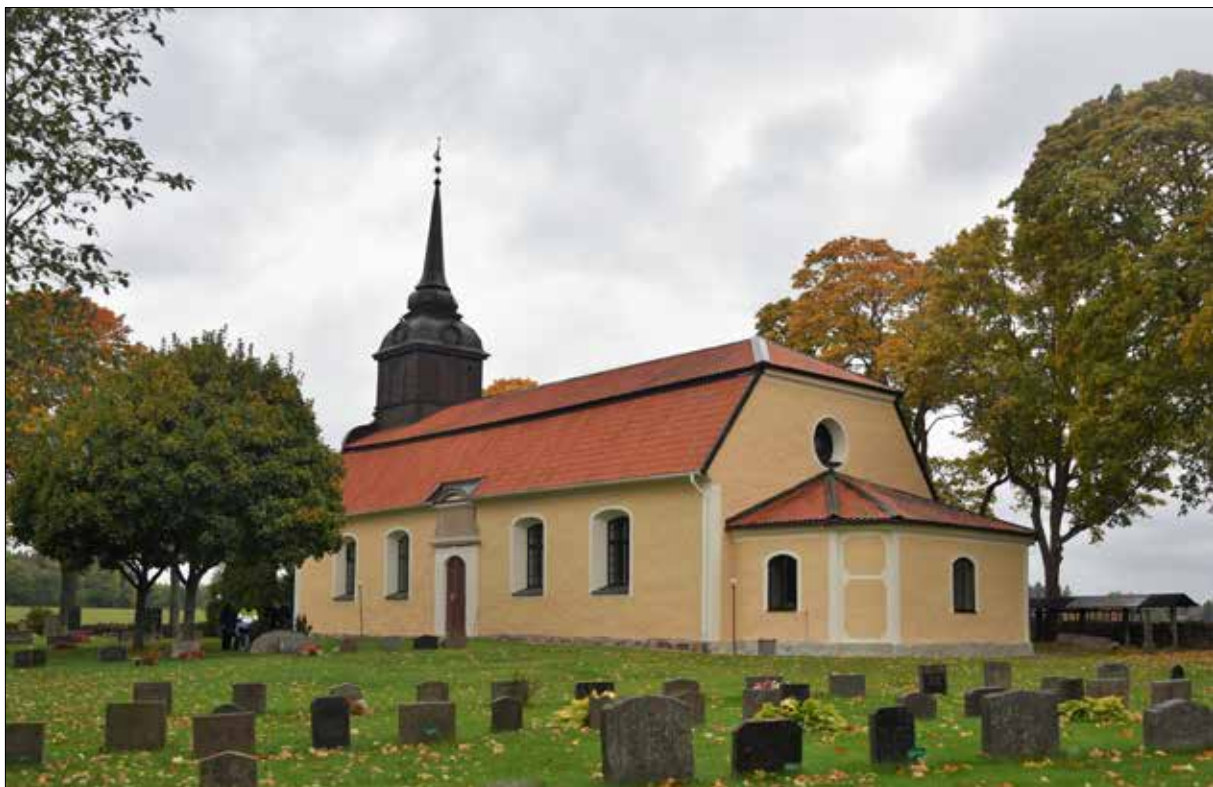
Figur 44. Södra och östra fasaden vid slutbesiktning. Lägg märke till att vindskivan ovan korfönstret målats svart.
