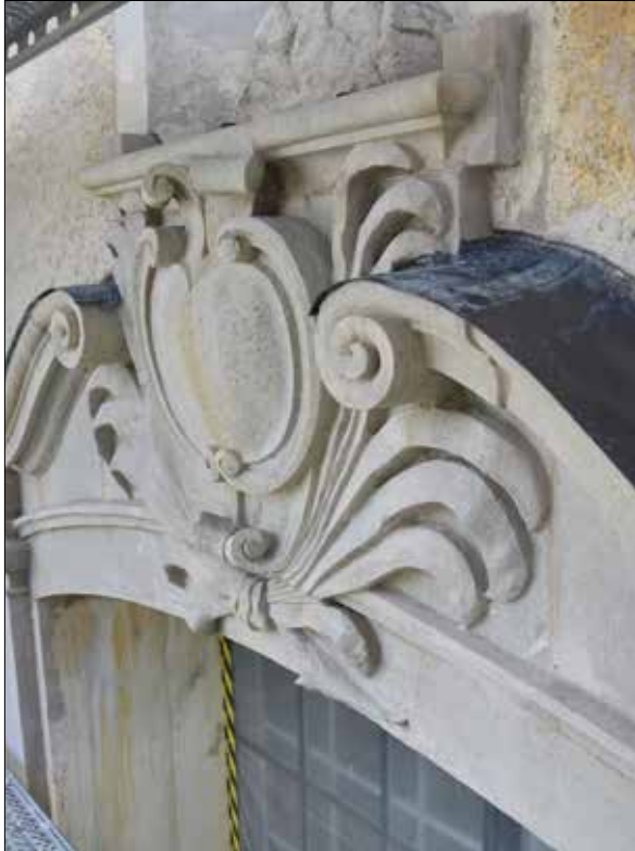
Figur 24. Västra gaveln. Renovering av stenarbeten pågår, augusti 2021.
