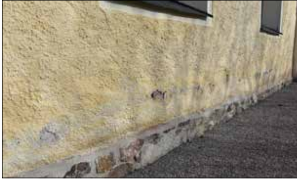
Figur 7. Detalj av sockel och fasad, södra sidan.
