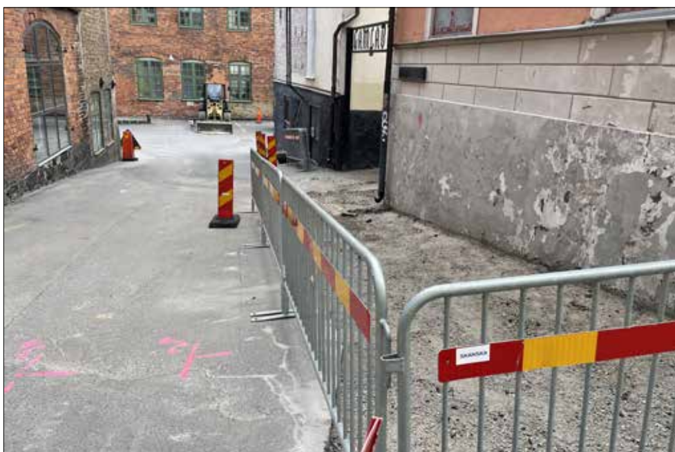
Figur 4. Gränden sedd från Västgötegatan i norr innan schaktningen började.
