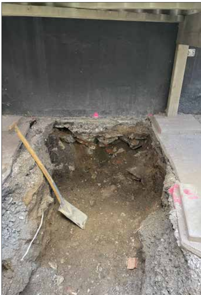
Figur 7. Schaktet emot husväggen under trätrappan. Lager 1 syns längs schaktkanterna. Foto från norr.
