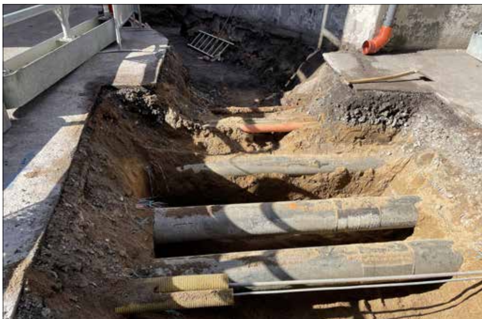
Figur 9. Schaktet i Västgötegatan. Foto från norr.
