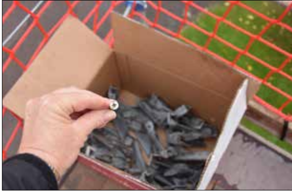
Figur 10. Ståldrännan på den norra sidan stöddes av konsoler. Dessa var fastskruvade med moderna skruvar.
