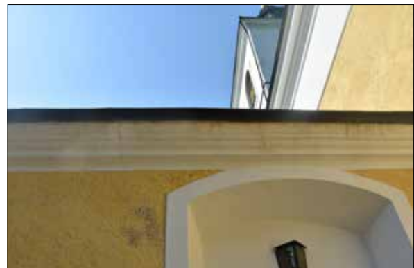
Figur 7. Detalj av rinningar på takfot, norra sidan.
