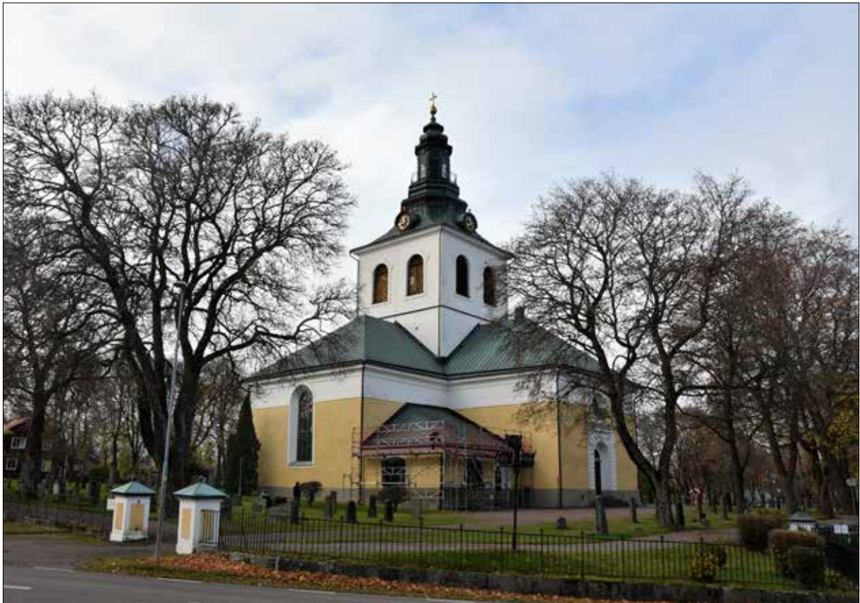
Figur 25. Slutbesiktning av sakristians tak. Byggställning fortfarande kvar.
