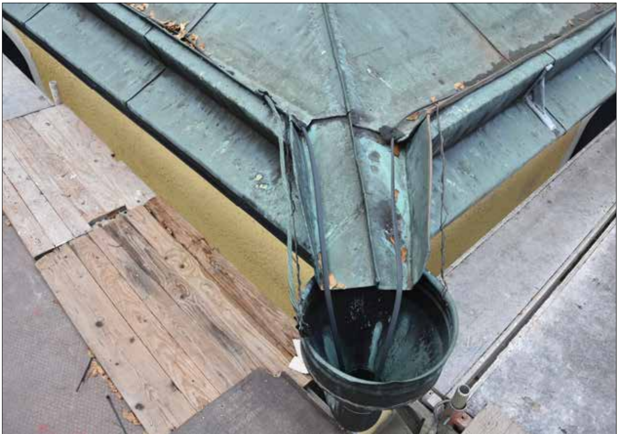
Figur 23. Detalj av vattkenpa efter justering.
