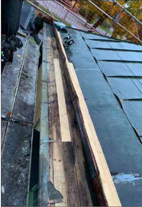
Figur 18. Rötskadade brädor byts ut. Foto Johan Andersson.
