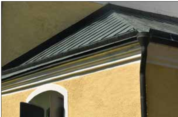
Figur 4. Takfot och fotränna, östra sidan.
