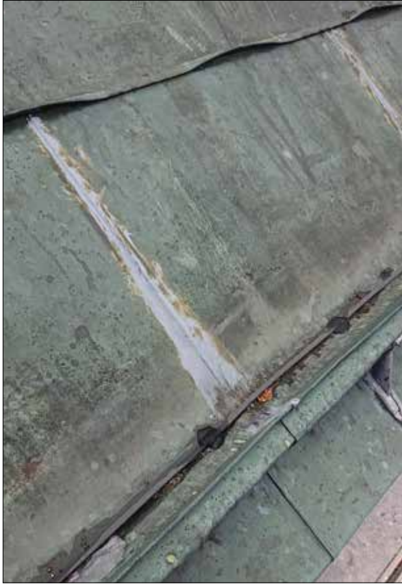
Figur 14. Tidigare lagning.
