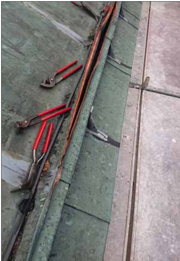
Figur 16. Vid öppning påträffades rötskadad bräda.
