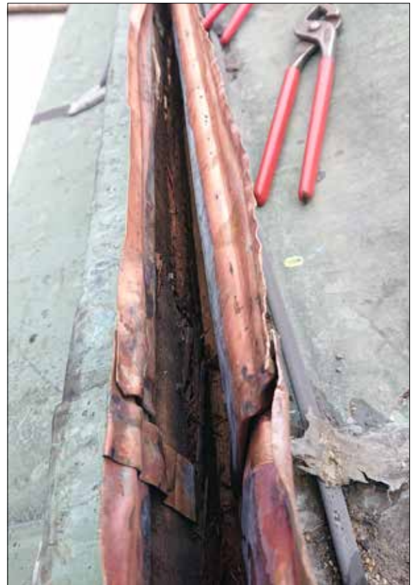
Figur 17. Arbete med upptagning pågår. Foto Johan Andersson.
