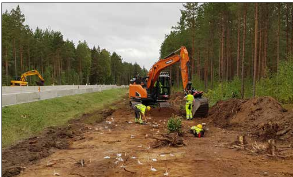
Figur 7. Vid schaktningsmomentet användes två grävmaskiner parallellt, en grävmaskin på varsin sida väg 56. Foto från norr av Karolína Karlsson.
