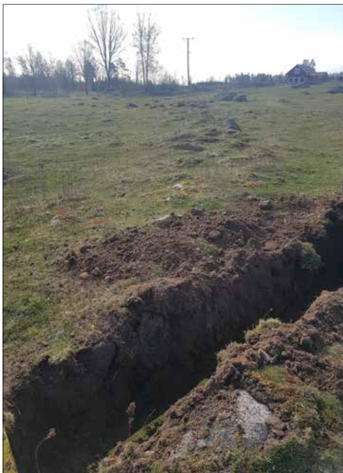
Figur 4. Schaktning i befintligt schakt genom stensträngen i hägnadssystemet L2010:6618. Foto från nordväst.
