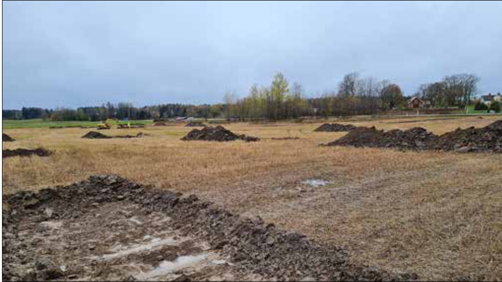
Figur 11. Vy över sökschakt. Schakt 306 i förgrunden. Foto från nordväst.
