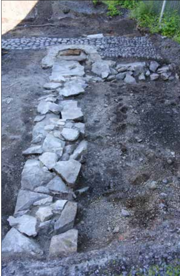
Figur 10. Husgrund 2286. I bakgrunden syns den kullerstenslagda gatan 2298. Foto från väster.
