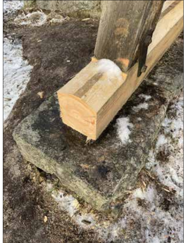
Figur 33. Avfasad sylstock före tjärstrykning.
