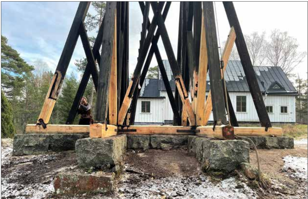
Figur 28. Utsikt mot öster. Alexander Nordin skymtar i bild.
