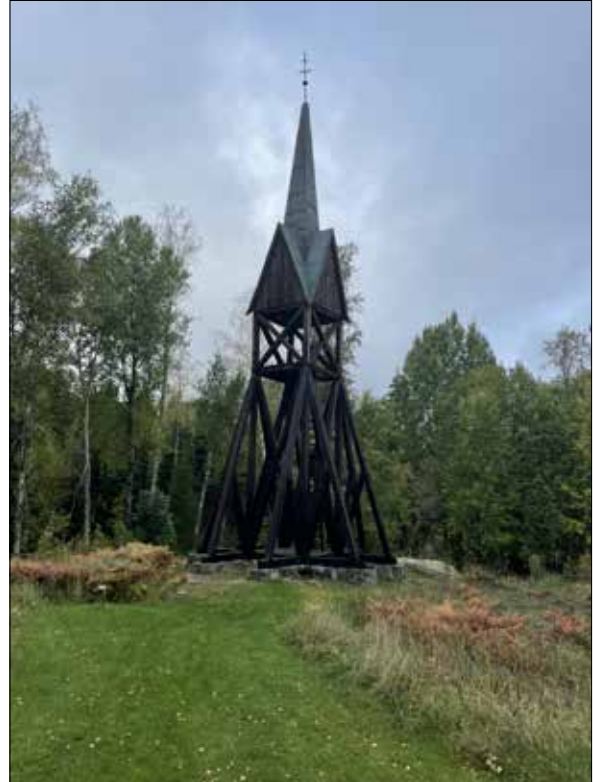
Figur 9. Startmöte i oktober. Klockstapeln i sin belbet före renovering.
