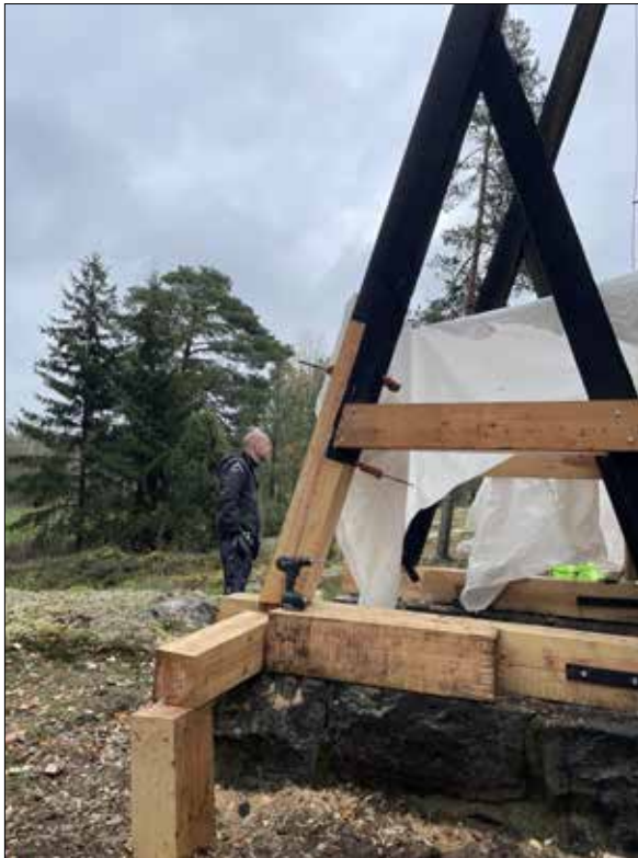
Figur 16. Utsikt mot nordöst. Peter Lindgren kontrollerar genomfört arbete.
