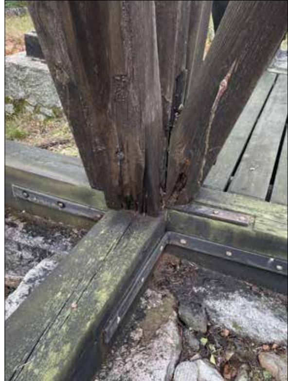
Figur 13. Detalj av mittstolpe före renovering.
