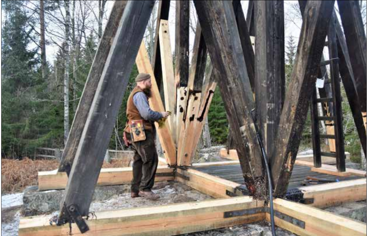
Figur 29. Utsikt mot väster. Detalj av timmerlagningarna som tjärstruktits. Alexander Nordin i bild.
