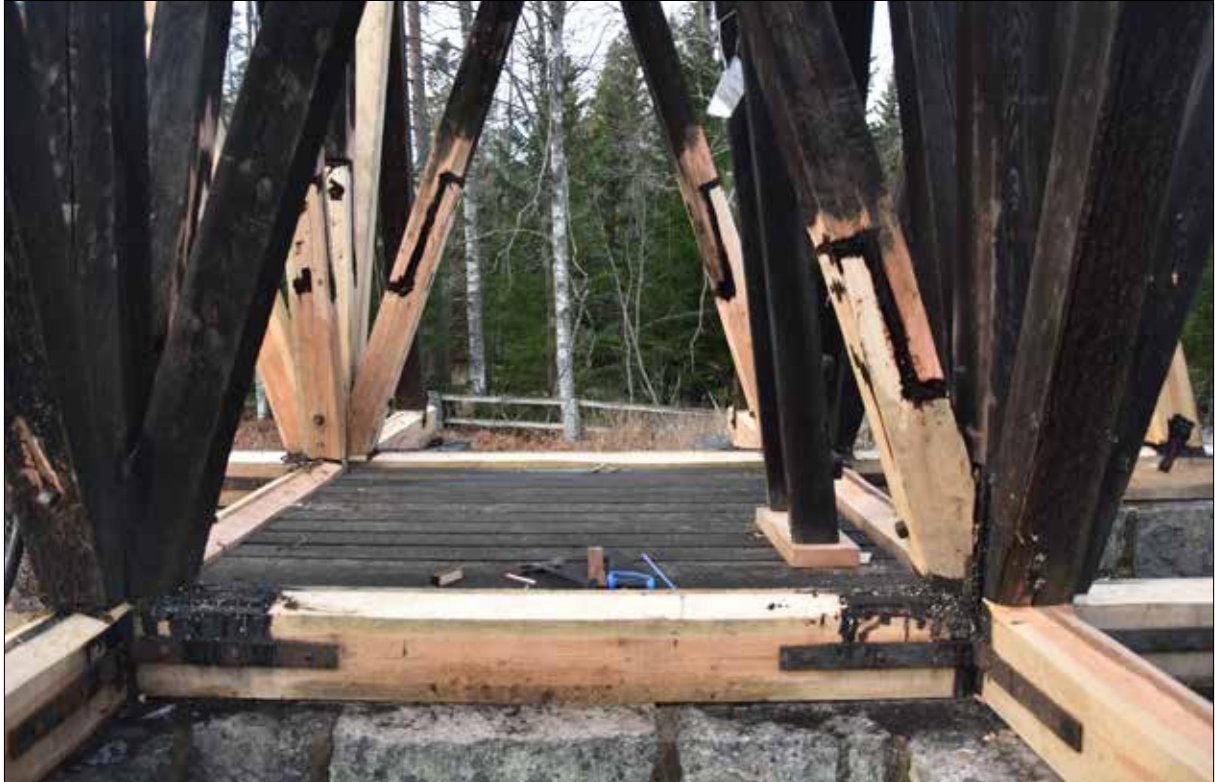
Figur 25. Utsikt mot väster. Timmerlagningar och skarvar har tjärstrykts.
