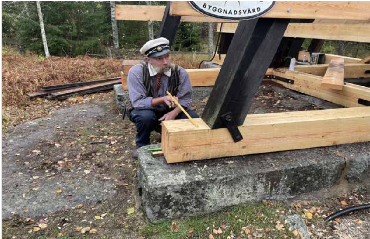
Figur 20. Syllstockarnas utseende diskuteras. Beslut tas om att fasa av kanterna för bättre vattenavrinning.
