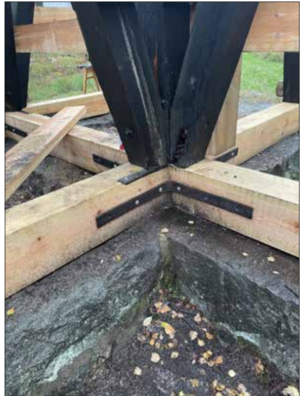
Figur 17. Detalj av mittstolpe och återmonterade beslag.
