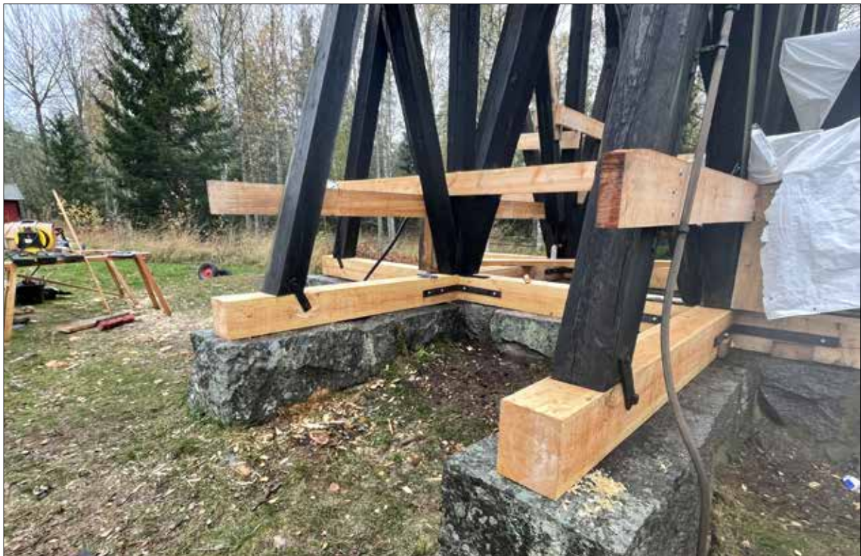
Figur 21. Andra byggmötet. Utsikt mot sydväst.
