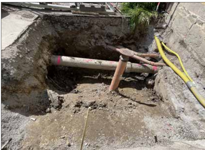
Figur 9. Schaktet anslöt till skolbyggnadens vägg i väster. Foto från norr.
