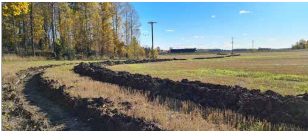
Figur 12. Vy över den södra halvan av sträckan för schaktningsövervakning. Foto från norr.
