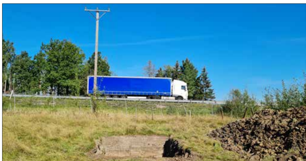
Figur 15. Schakt för ledning under E18. Bakom lastbilens förarhytt är hållristningsplats belägen. Foto från söder.
