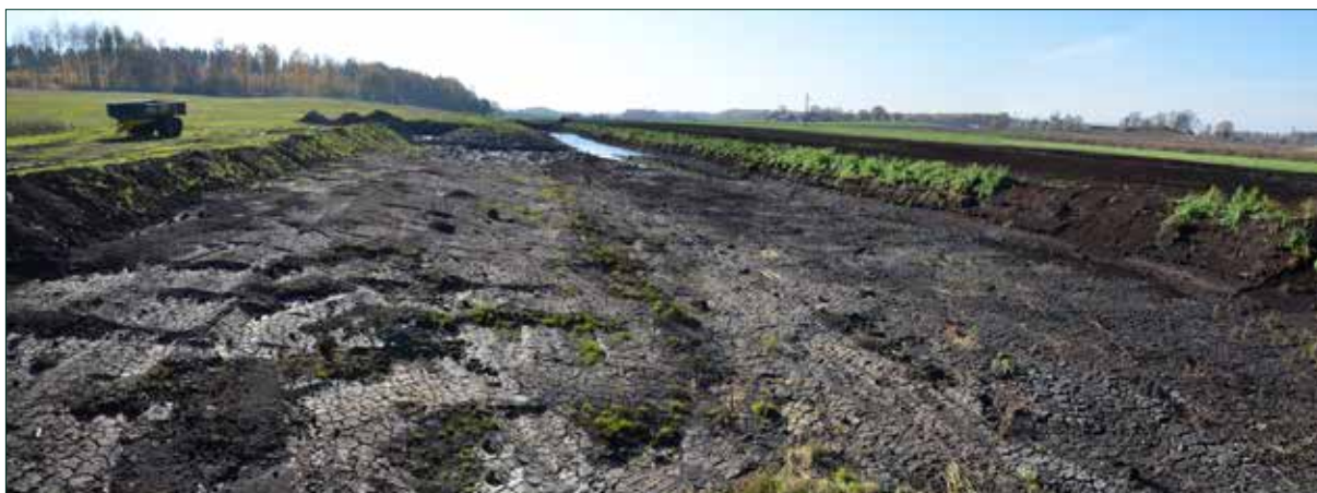
Figur 6.14. Vid besiktningen i mitten av oktober 2018 var schakt 1 och 2 åter torrlagda med hjälp av vattenpump, inför schaktning av angränsande ytor. Botten av schaktet var dock fortsatt vattensjukt och bara delar av ytan gick att beträda. Vy mot söder.
