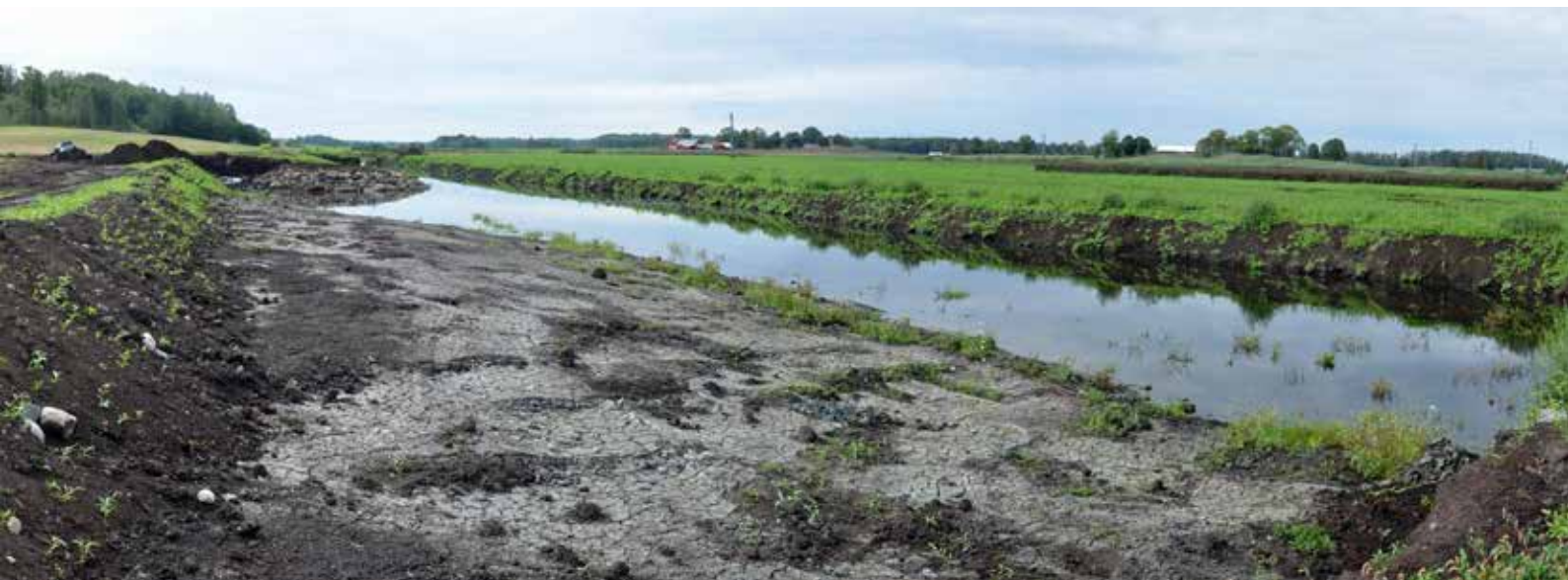
Figur 6.5. Schakt 2 (närmast kameran), i bakgrunden det nu vattenfyllda schakt 1. Vy mot sydväst.
