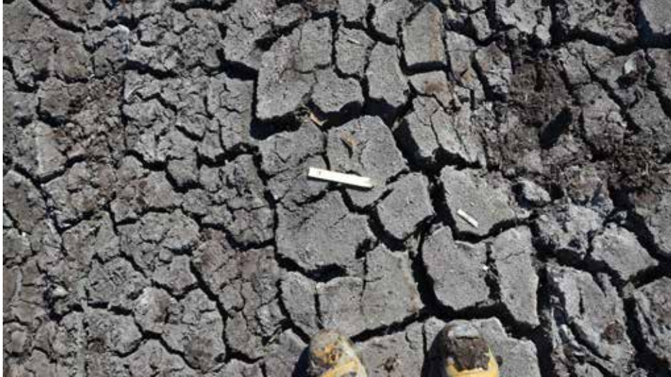
Figur 6.34. Vid besiktningen av de schaktade ytorna i våtmarken sommaren 2018 var de frilagda våtmarkslagren uppspruckna av djupa torrsprickor. På bilden syns ett område med lergyttja, med fläckvisa rester av överliggande mörk gyttja. Efter det att dammen senare vattenfylldes så eroderade vattnet ut slam som omsedimenterade på dammens botten. Under denna process täcktes de framschaktade ytorna av utsvallat material, slammets kom även att fylla de kvarvarande torrsprickorna. Notera att det på bilden syns några ben från brax. Innan bilden togs har ett ben plockats upp ur och lagts ner intill fyndplatsen, ett annat ben skymtar delvis exponerat i en torrspricka – ännu inbäddat i lergyttja.
