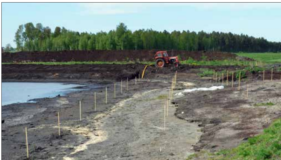
Figur 6.28. Den nyligen torrlagda norra delen indelad i ett rutnät om 5 \times 5 meter stora rutor. I bakgrunden syns den gula slangen till vattenpumpen. Pumpen drevs av ström från traktorn.
