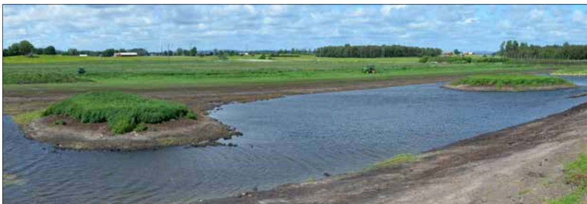
Figur 6.40. Södra ytan efter det att skredbranten schaktats ner och släntats, vattenståndet i dammen är stigande. Vy mot nordväst.
