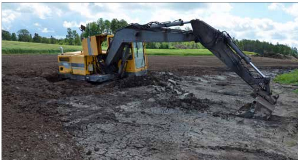
Figur 6.43. Vid markägarens avslutande planering av den norra ytan sjönk grävmaskinen och fastnade i de mjuka och vattensjuka lagren.
