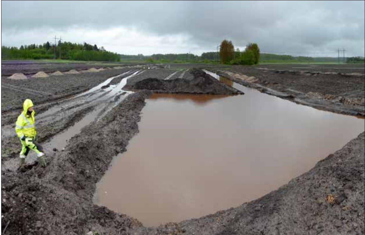
Figur 15. Under fältarbetets sista fältvecka påverkades utredningen av kraftiga regn som fyllde schakten till bredden med vatten.
