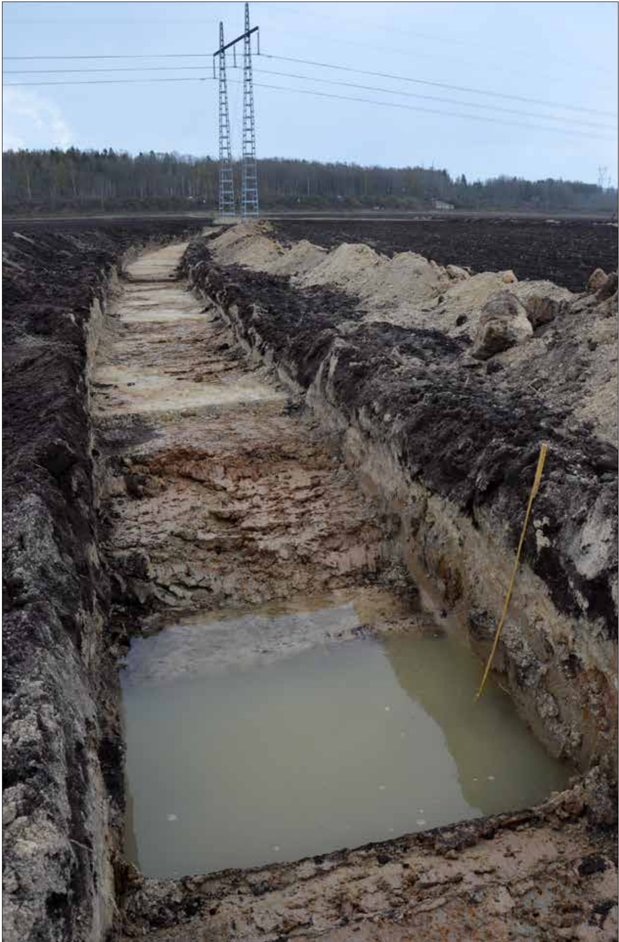
Figur 14. Exempel på djupschaktad del av ett sökschakt.
