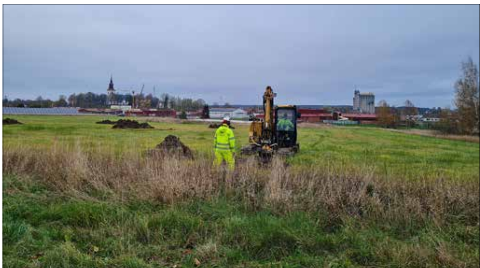
Figur 12. Vy över södra delen av utredningsområdet med sökschakt. Schakt 684 i förgrunden. Foto från sydväst.
