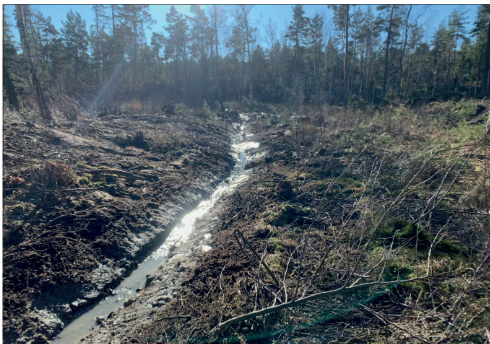
Figur 7. Ett nyligen grävt dike som dränerar ytan ner mot viken Lilla Horsvarpet. Foto från norr.
