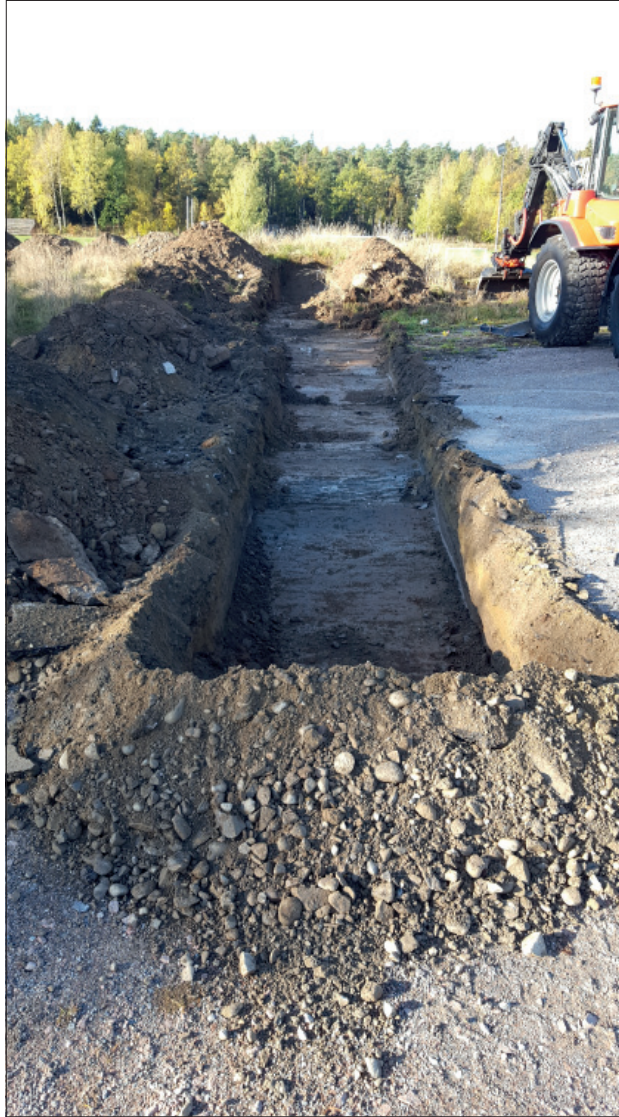
Figur 9. Schakt 1, grävt från den möjliga skärvstenshögen och vidare ut i den grusade ytan. I schaktet framkom tre härdar. Foto från öster.
