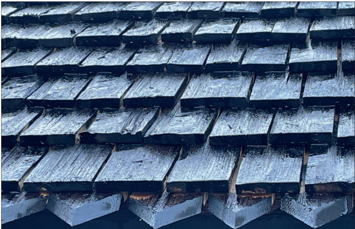
Figur 39. Platsbesök den 24 mars. En första tjärstrykning är utförd. Lite ojämnt men killarna kom tillbaka ...
