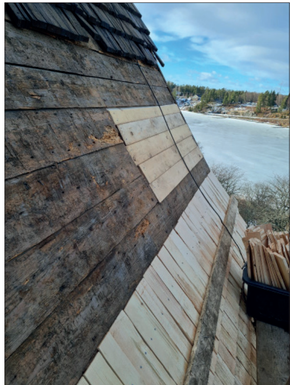
Figur 21. Detalj av lagad läkt. Kyrktak AB:s egen dokumentation.
