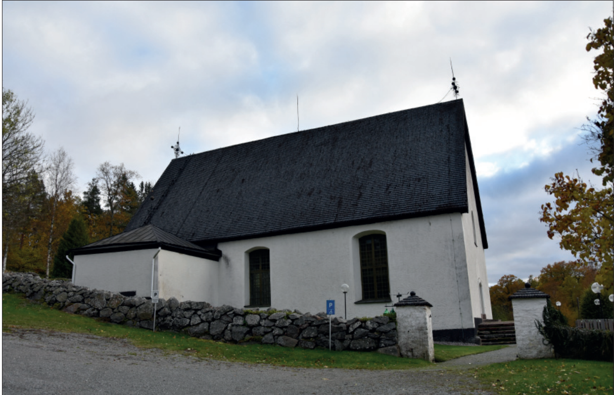
Figur 3. Platsbesök före omläggning av spåntaket, hösten 2020.
