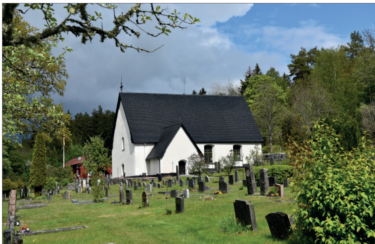
Figur 43. Södra takfallet har också tjärstrukits, maj 2022.
