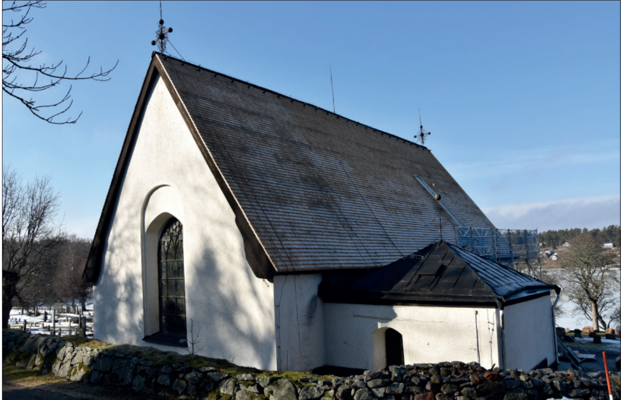
Figur 36. Platsbesök den 17 mars. Hela taket omlagt.
