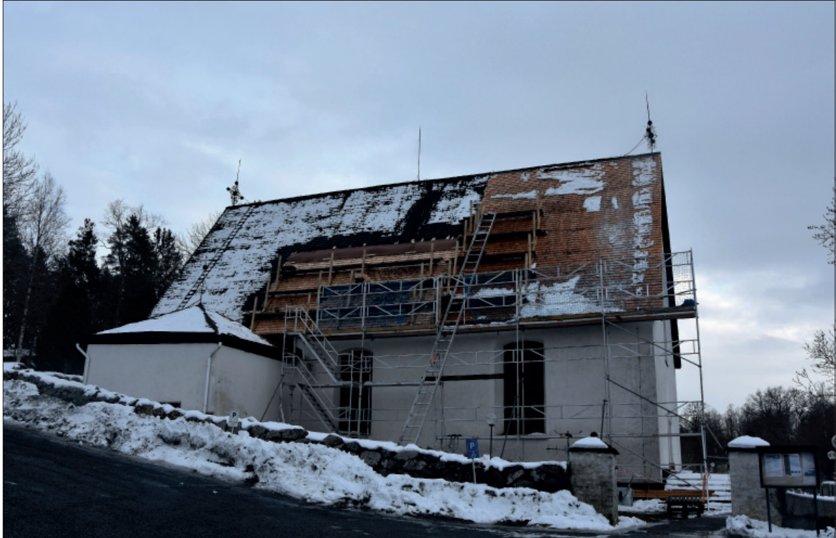
Figur 28. Platsbesök den 24 februari. Två tredjedelar av taket är klart.
