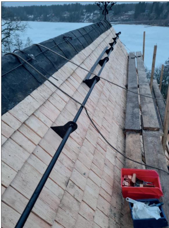
Figur 23. Montering av taksäkerbet. Kyrktak AB:s egen dokumentation.
