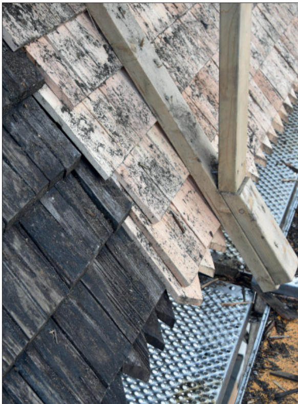
Figur 20. Nytt spån möter äldre spån.
