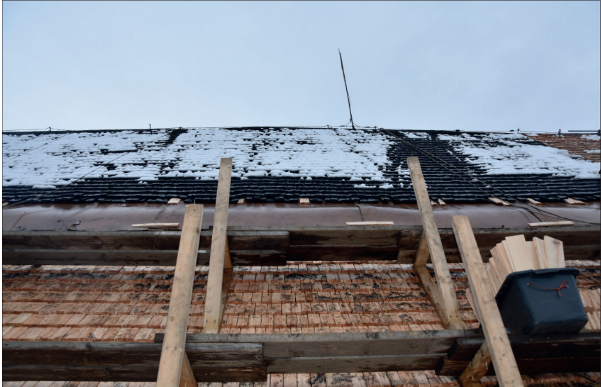
Figur 30. Utsikt uppåt vid platsbesök.
