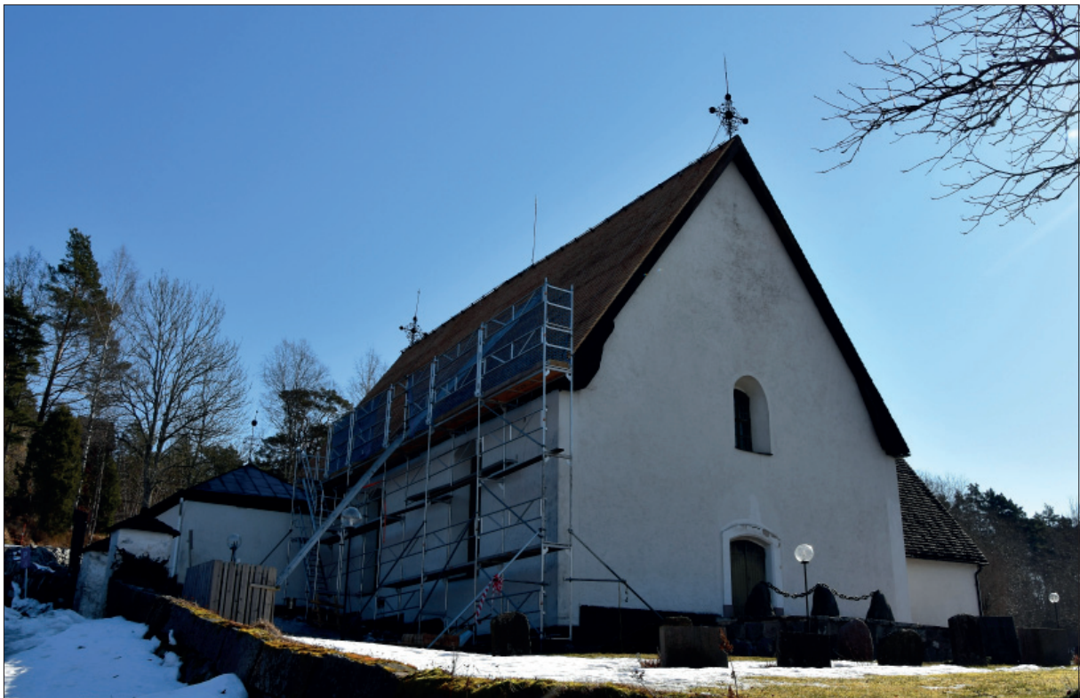
Figur 33. Platsbesök den 17 mars. Taket är färdiglagt.
