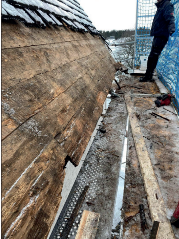
Figur 14. Skadad takfotsbräda. Kyrktak AB:s egen dokumentation.
