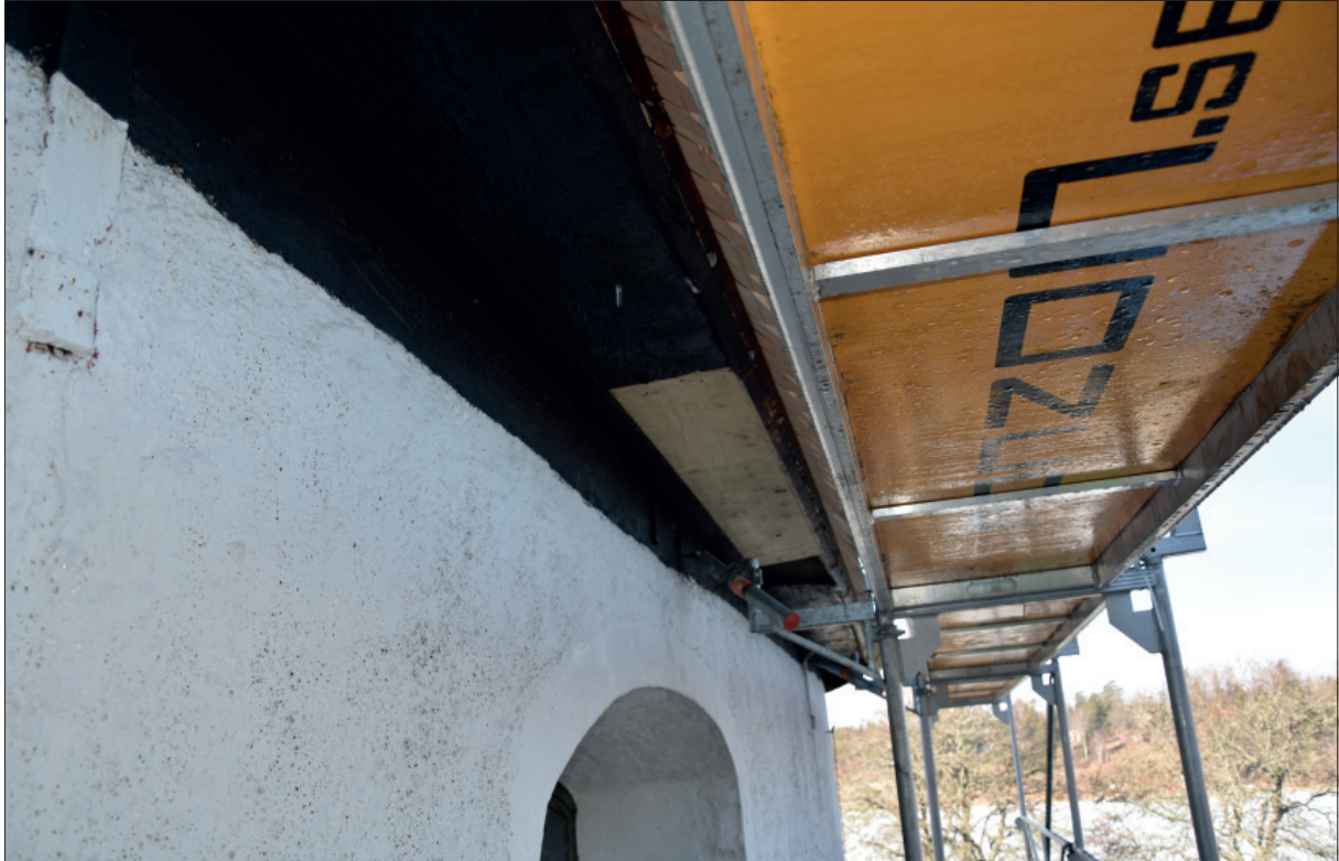
Figur 34. Lagad takfot före tjärning.
