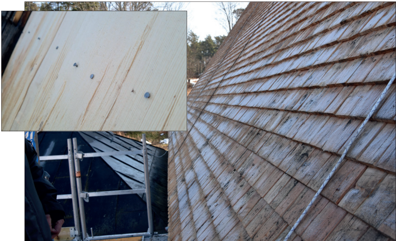
Figur 35. Detalj av spik och norra takfallet, utsikt mot väster i mars 2022.
