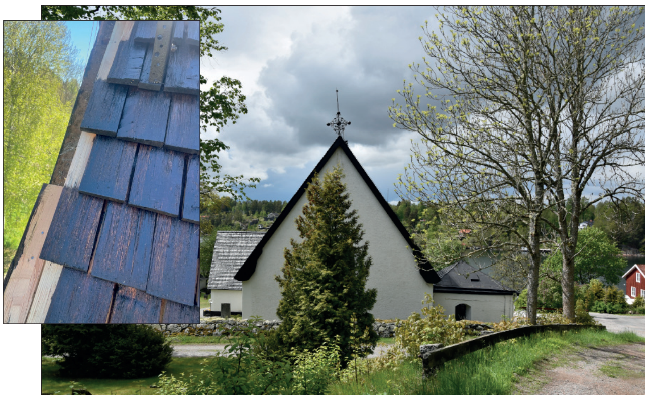
Figur 41. Västra gaveln, omläggning av spån samt färdigt resultat på långt håll.
