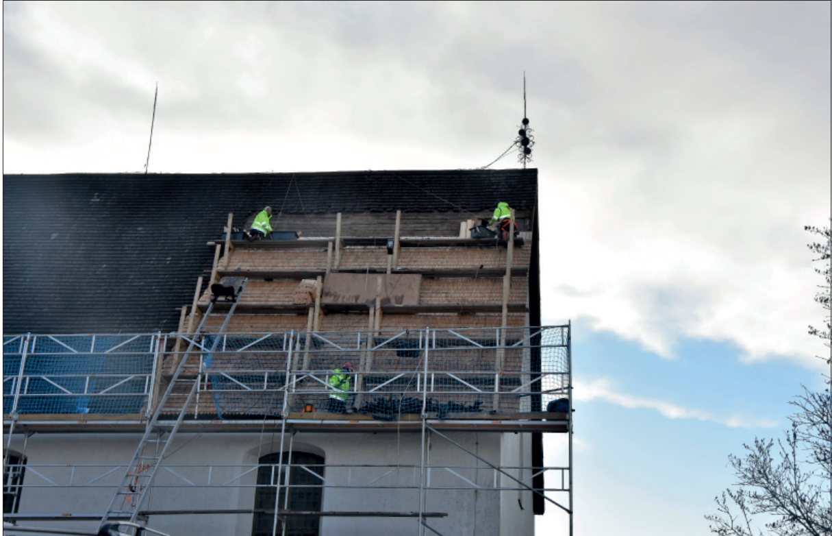
Figur 19. Arbete pågår med lagning av bärläkt.
