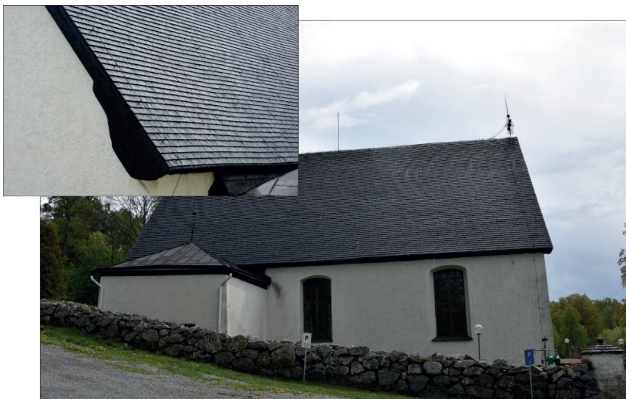
Figur 42. Detalj av avslut mot vindskeiva. Det luktar gott och ser snyggt ut!
