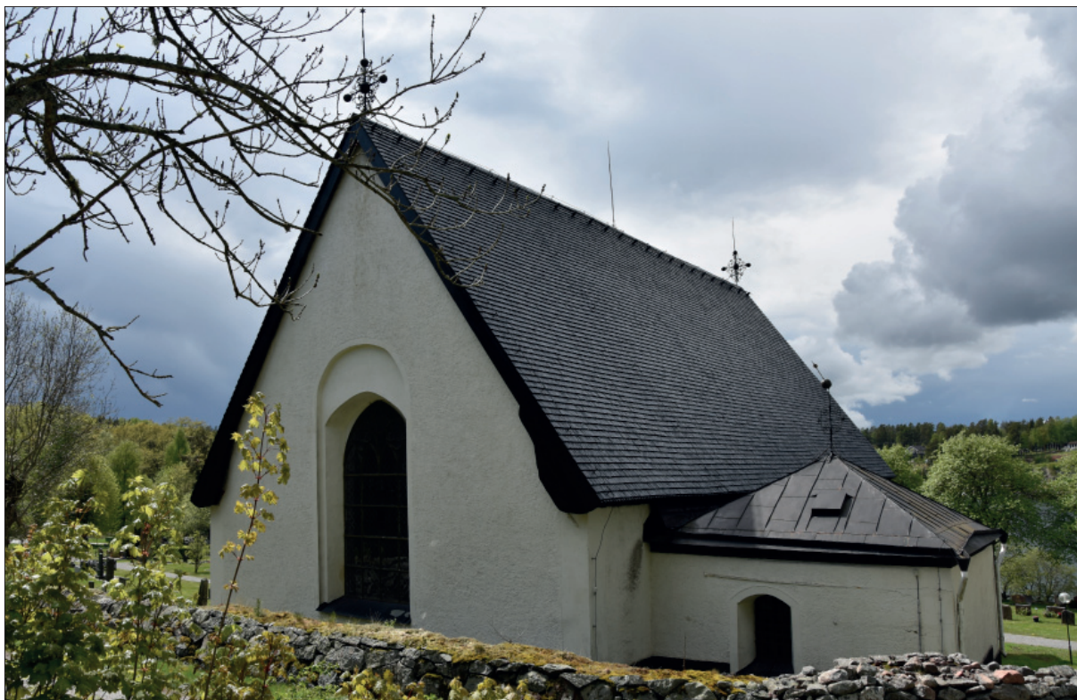
Figur 40. Platsbesök den 27 maj. Anslutet mot vindskivan är åtgärdat och taket tjärat två gånger.
