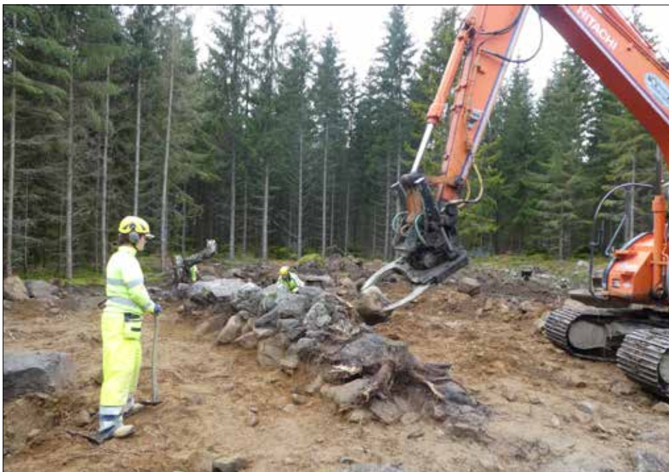
Figur 3. Sten i röset lyftes med grävmaskinens gripklo. Foto från sydöst.
